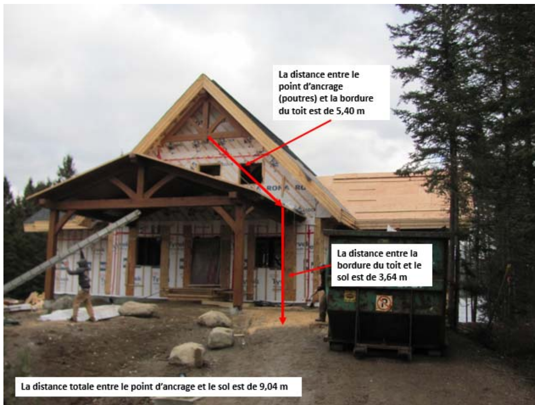
Photo 8 : Distance entre le point d'ancrage des cordes d'assurance verticales et le sol
