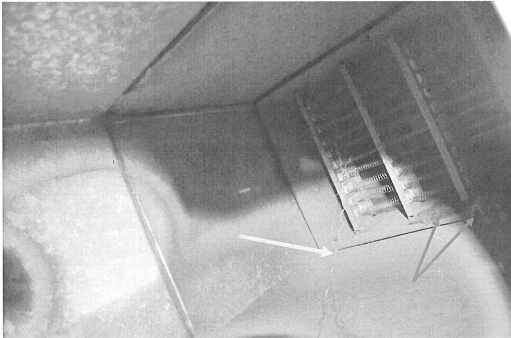
Photographie 7 : Vue de l'intérieur de la gaine de ventilation montrant le serpentin électrique. La flèche jaune pointe vers la section étirée d'un des trois éléments chauffants. Les flèches vertes pointent des débris.
