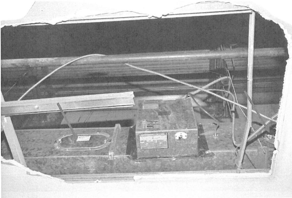
Photographie 6 : Trappes d'accès à la gaine de ventilation (flèches).
