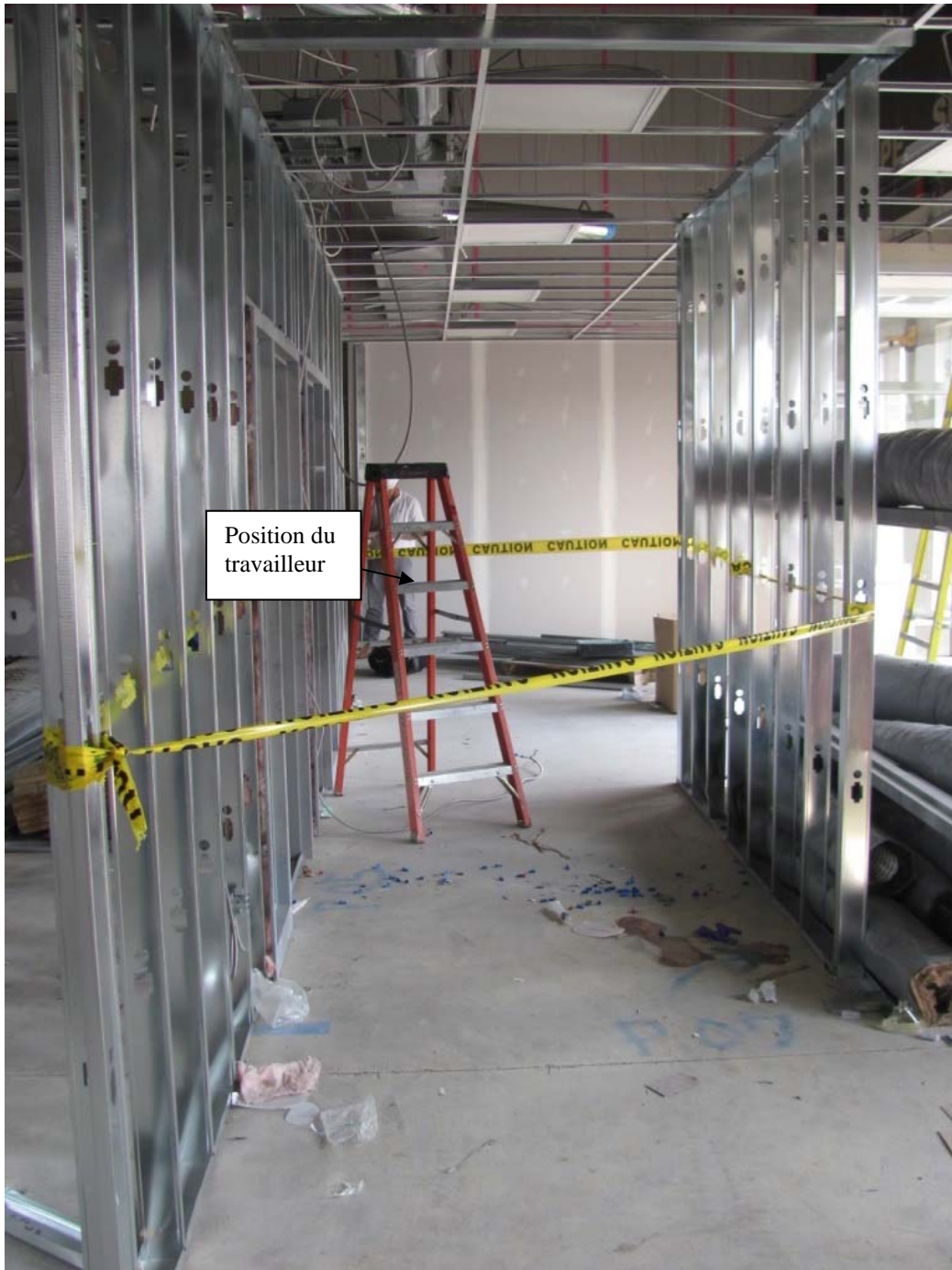
Photo 4 : Position du travailleur dans l'escabeau (Source : CNESST) Il utilise des pinces à bec long de 8 pouces avec outil à dénuder de marque Mastercraft.
