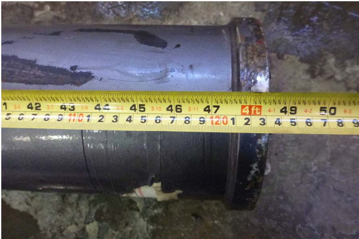
Photo 25 : Vue rapprochée de l'extrémité supérieure de la section supérieure du vérin, montrant qu'elle mesure approximativement 4 pieds de longueur.
