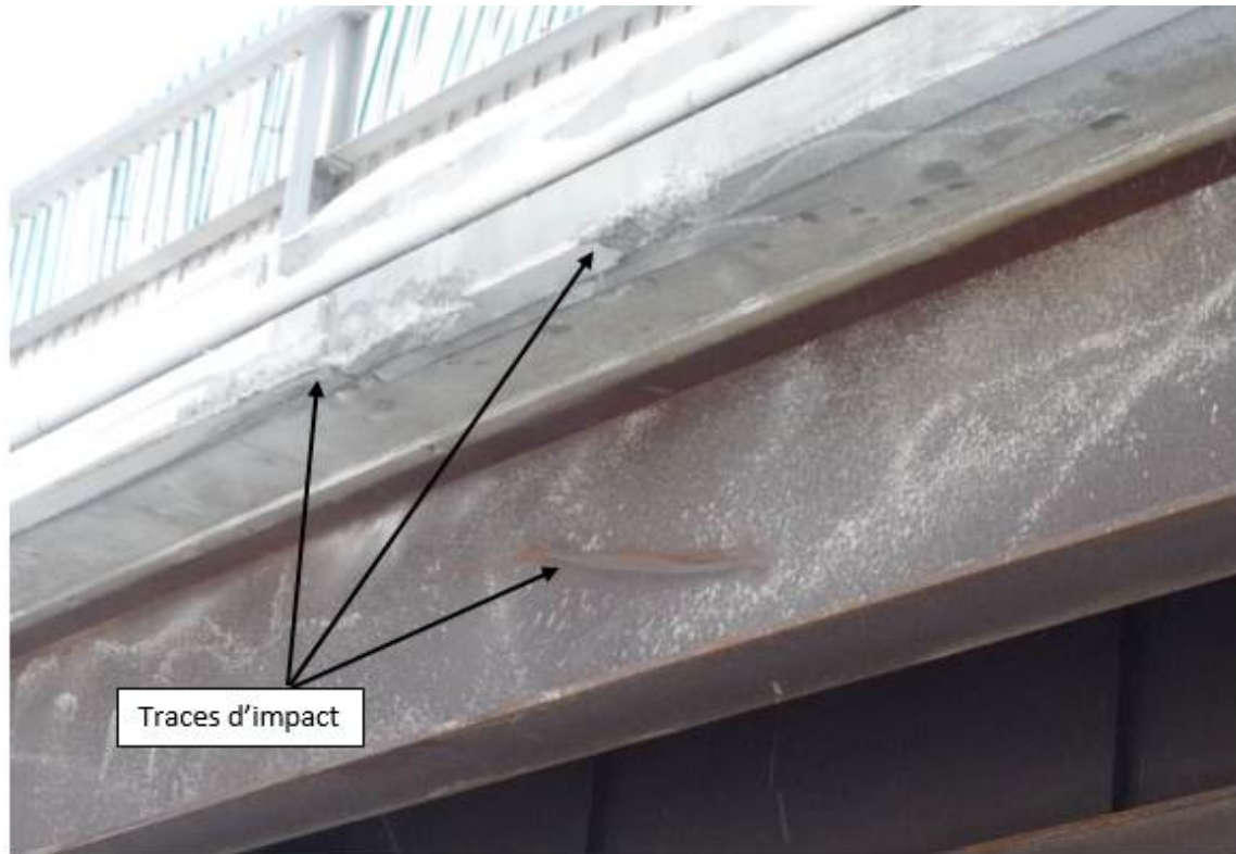
Photo 18 : Traces d'impact sur le viaduc du Boulevard des Hautes-Plaines (Source : CSST)
