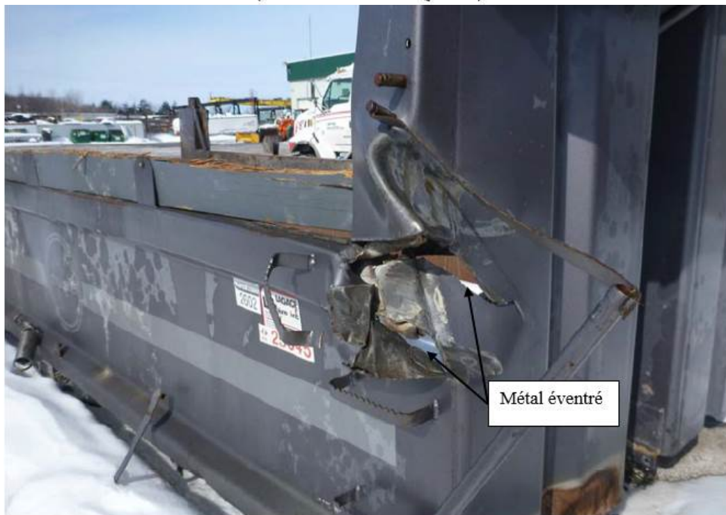
Photo 11 : Vue rapprochée montrant le métal de la benne éventré (Source : Prolad Expert inc.)
