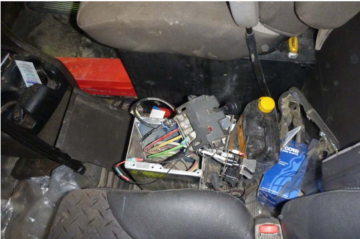
Photo 62 :Vue générale de la console centrale, entre les sièges, montrant le boîtier de contrôle de la prise de force (PTO) et de la pompe hydraulique activant la benne.
