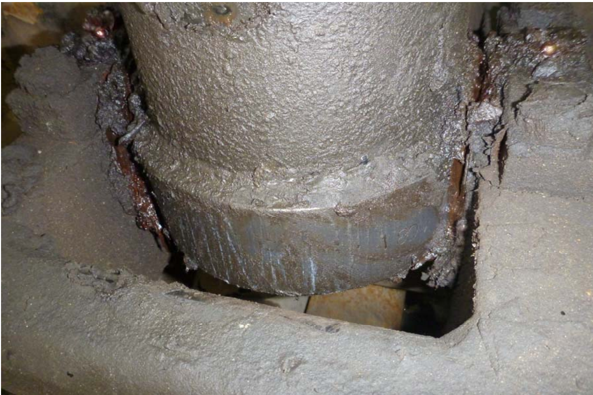
Photo 20 : Vue générale du pivot de la base du vérin.
