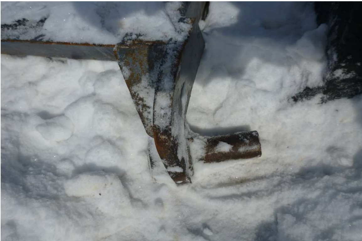
Photo 56 : Vue rapprochée du pivot supérieur du côté gauche, montrant qu'il est déformé.
