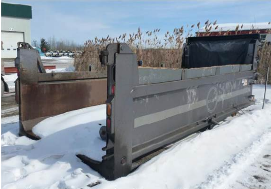
Photo 12 : Arrière de la benne basculante montrant l'arrachement du hayon (Source : Prolad Experts Inc.)
