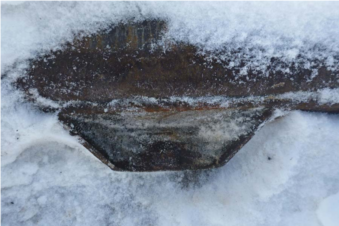
Photo 59 : Vue rapprochée du support de droite.
