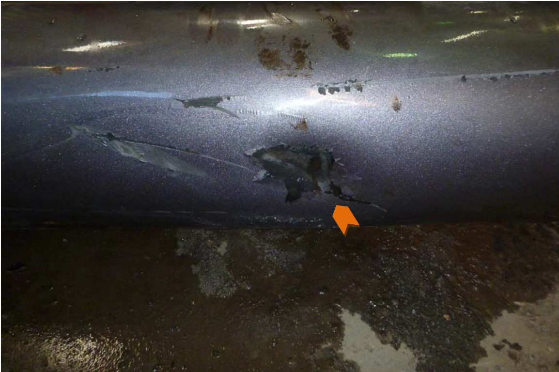
Photo 24 : Vue rapprochée de la photo précédente, montrant des traces d'endommagement.
