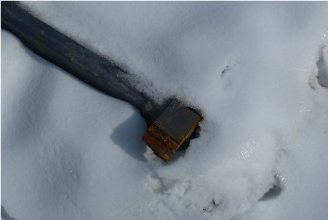
Photo 57 : Vue rapprochée de la penture supérieure du côté droit, montrant qu'elle est arrachée.
