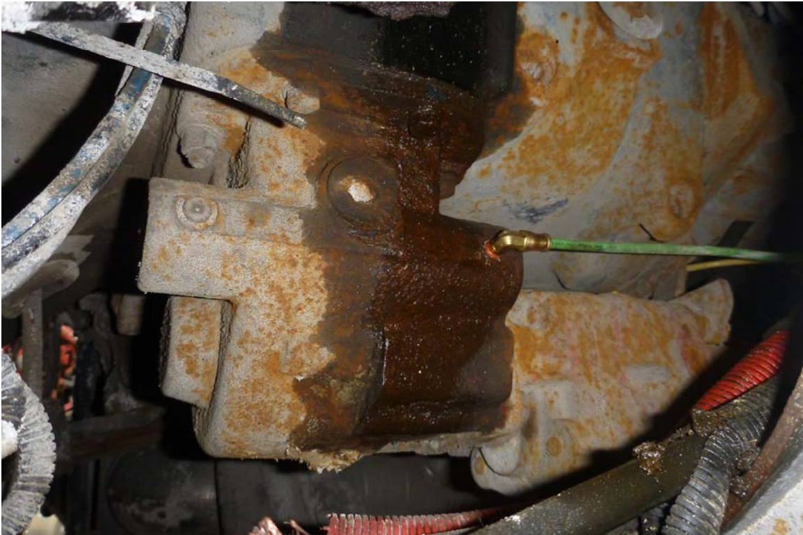
Photo 75 :Vue générale de la prise de force (PTO ou Power Take Off ).
