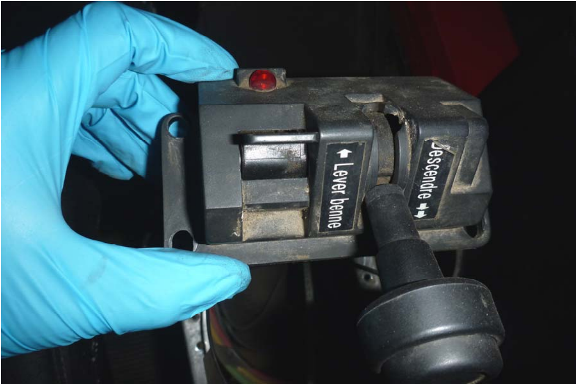
Photo 63 : Vue générale du module de contrôle de la prise de force et de la pompe hydraulique.
