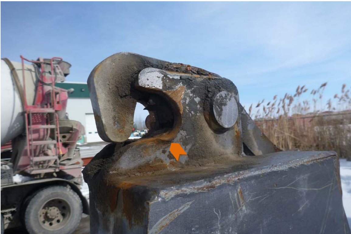
Photo 50 : Vue rapprochée du support de pivot supérieur du côté arrière gauche de la benne basculante, montrant des traces d'écrasement.
