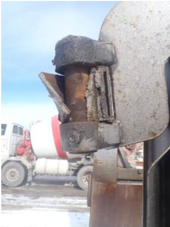
Photo 13 : Penture supérieure côté droit arrachée (Source : Prolad Expert Inc.)
