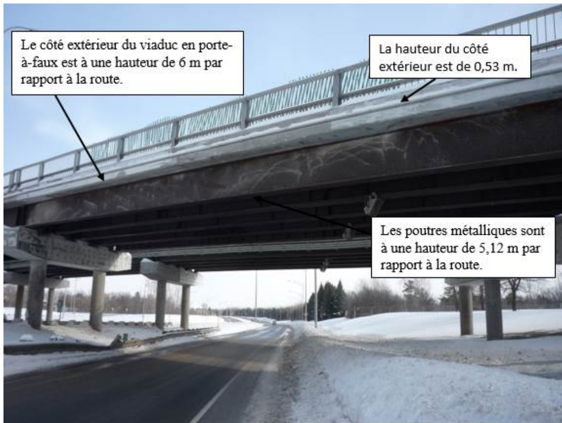
Photo 17 : Vue latérale du viaduc du Boulevard des Hautes-Plaines (Source : CSST)
