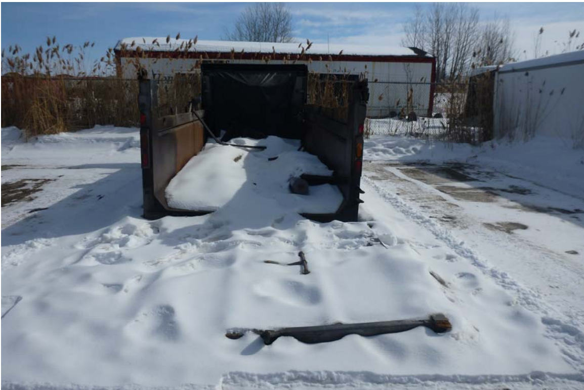
Photo 48 : Vue générale de l'arrière de la benne basculante.
