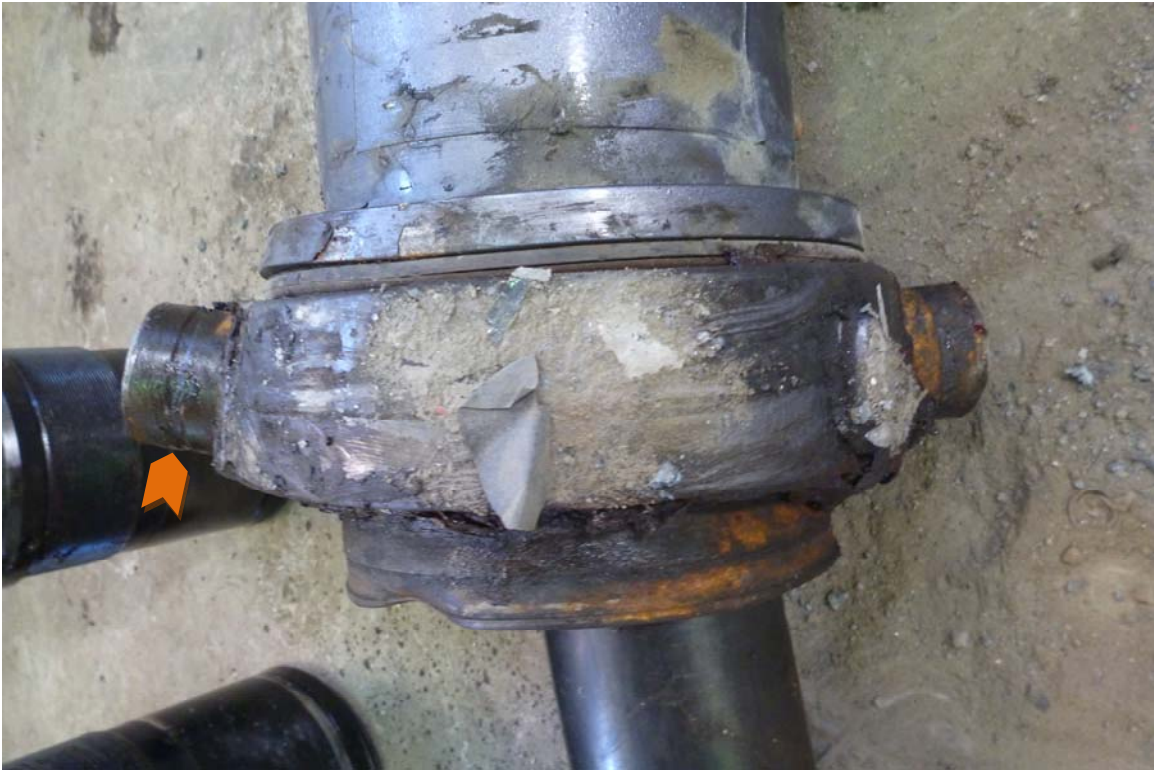
Photo 27 : Vue générale du pivot de la section supérieure du vérin, montrant qu'il est déformé.
