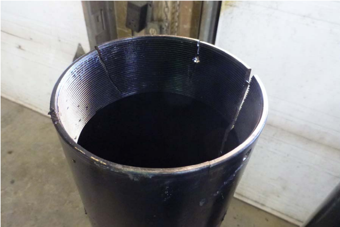
Photo 35 : Vue rapprochée de l'extrémité de la section de gauche, montrant qu'elle est fissurée sur sa partie filetée.
