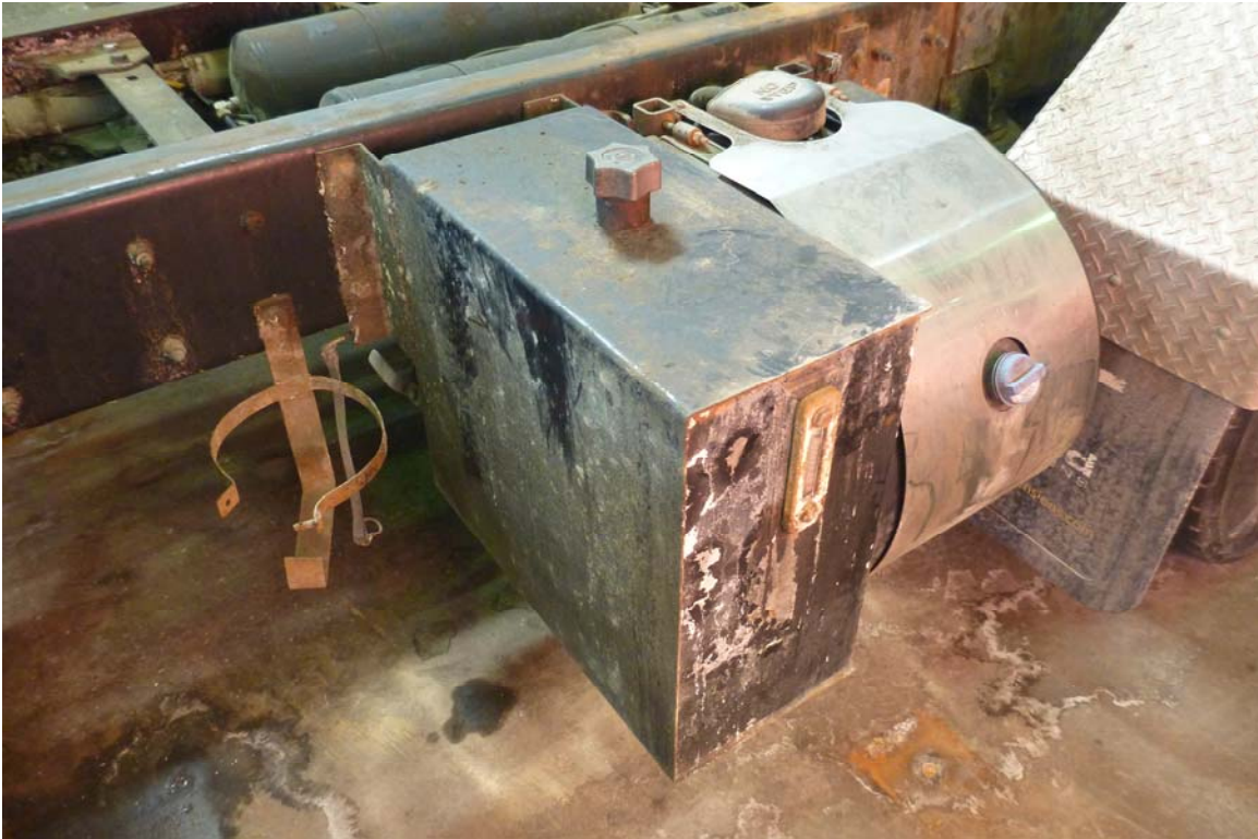
Photo 15 : Vue générale du réservoir d'huile hydraulique, situé du côté arrière droit.
