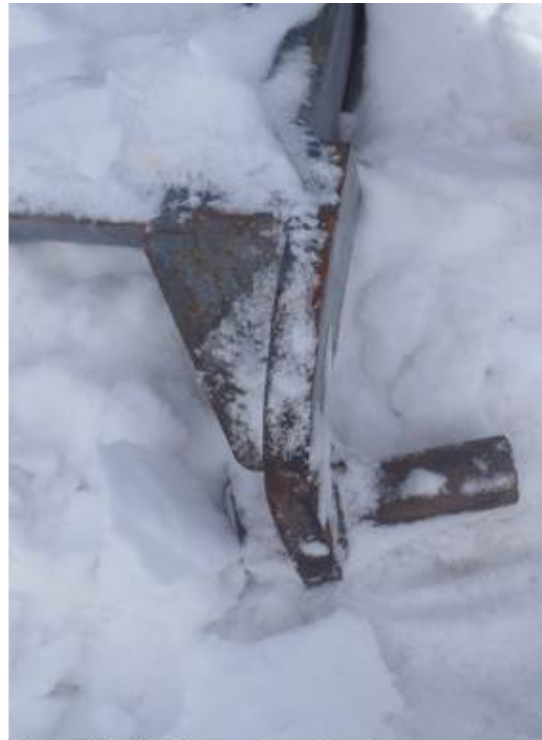
Photo 14 : Déformation du pivot supérieur gauche (Source : CSST)
