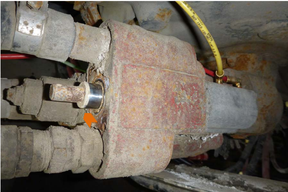
Photo 78 : Vue rapprochée du piston de la pompe, en position "Neutre".
