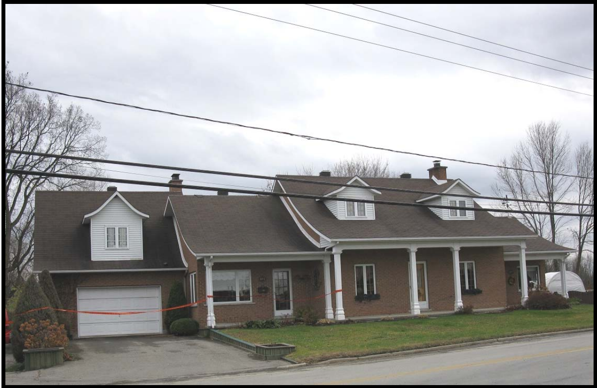
Photo 2 : Vue de face du chantier (source : CSST)
