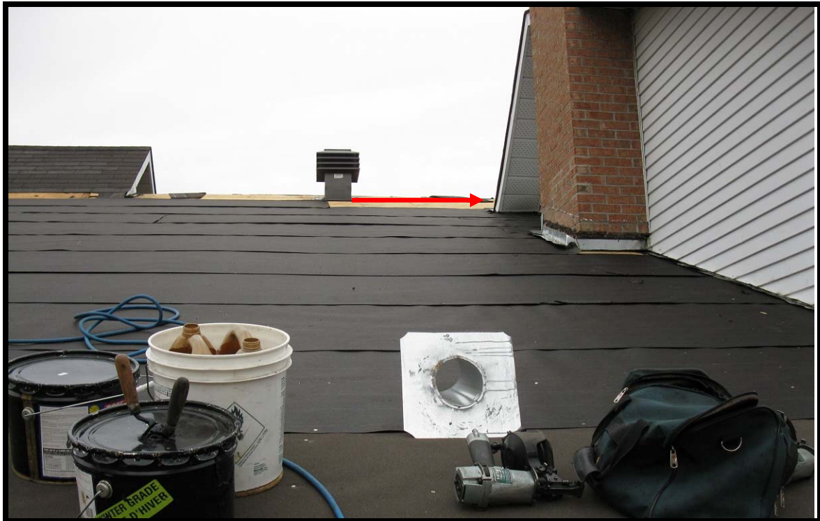
Photo 4 : Déroulement du papier-feutre de la gauche vers la droite (source : CSST)
