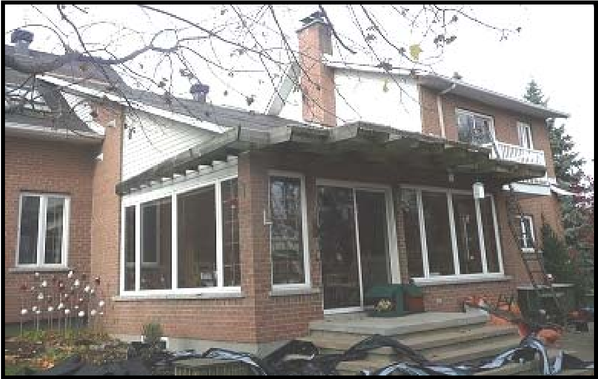
Photo 3 : Vue du versant en cours de rénovation (source : CSST)
