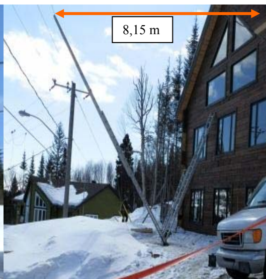
Photo 3 : Façade de la résidence (vue latérale) Source : CSST
