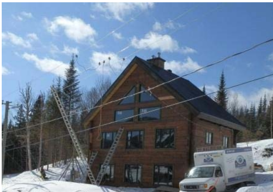
Photo 1 : Vue générale du chantier Source : CSST
