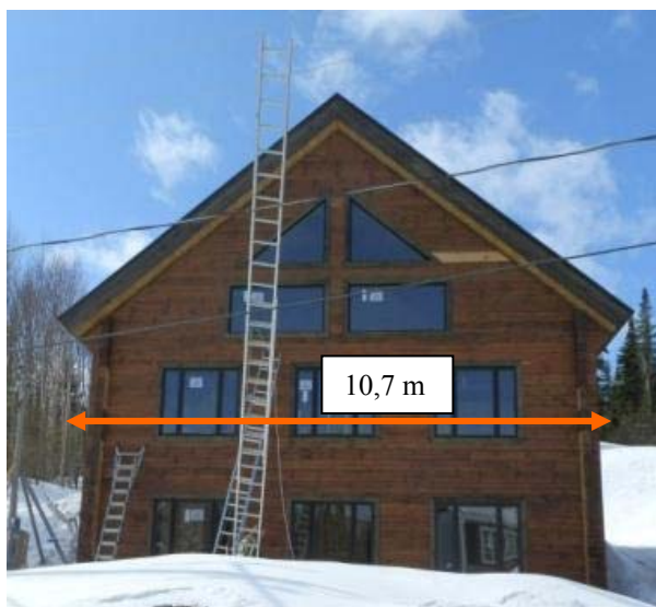
Photo 2 : Façade de la résidence Source : CSST
