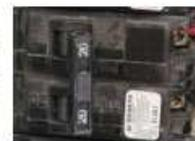
**Photo 23 : disjoncteur standard double de 20 A**
