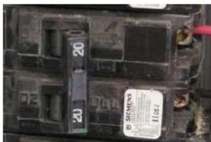
**Photo 20: disjoncteur standard de 20 A actuellement utilisé pour alimenter l'unité de climatisation murale**
