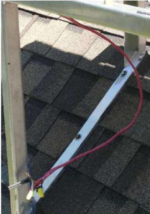
Photo 7 : câbles non-conformes pour l'extérieur et jonction de branchements non-protégée par une boîte de jonction étanche aux intempéries
