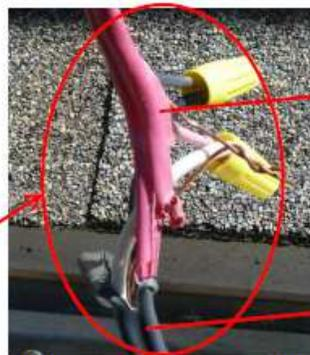
Photos 13 et 14 : raccords entre le câble venant de l'intérieur et celui à l'extérieur de l'immeuble
