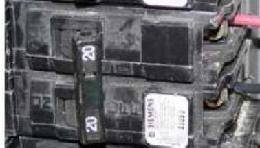
Photo 5 : disjoncteur double de marque Siemens de 20 Ampères alimenté à 240 Volts
