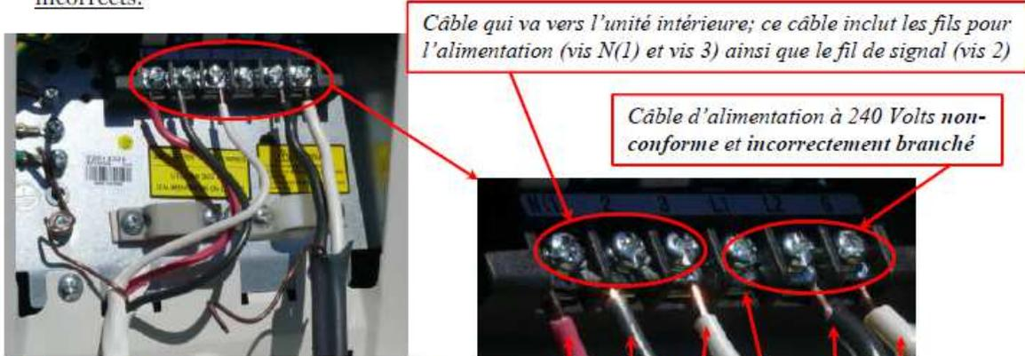
Photos 24 et 25 : raccordements électriques erronés sur l'unité extérieure (thermopompe)
