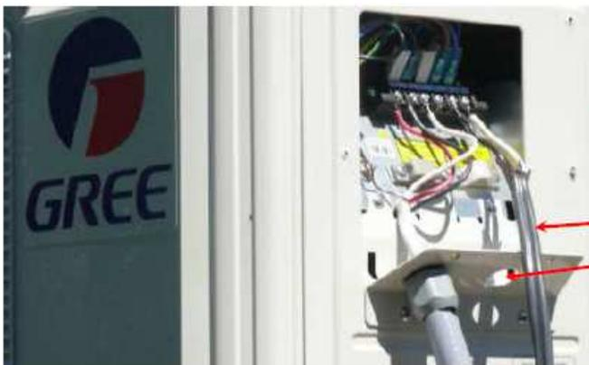
Photo 12 : raccords électriques sur l'unité extérieure
