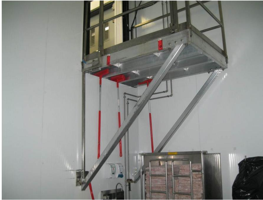
Figure 17: Mezzanine dans la chambre froide.
