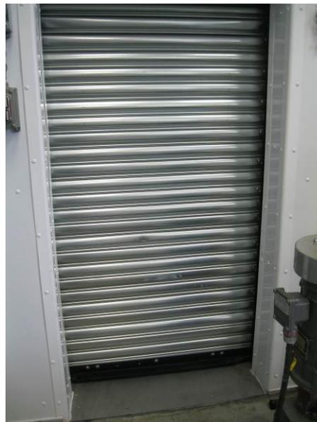
Figure 16 : Registre coupe-feu entre la mezzanine des broyeurs et la chambre froide.
