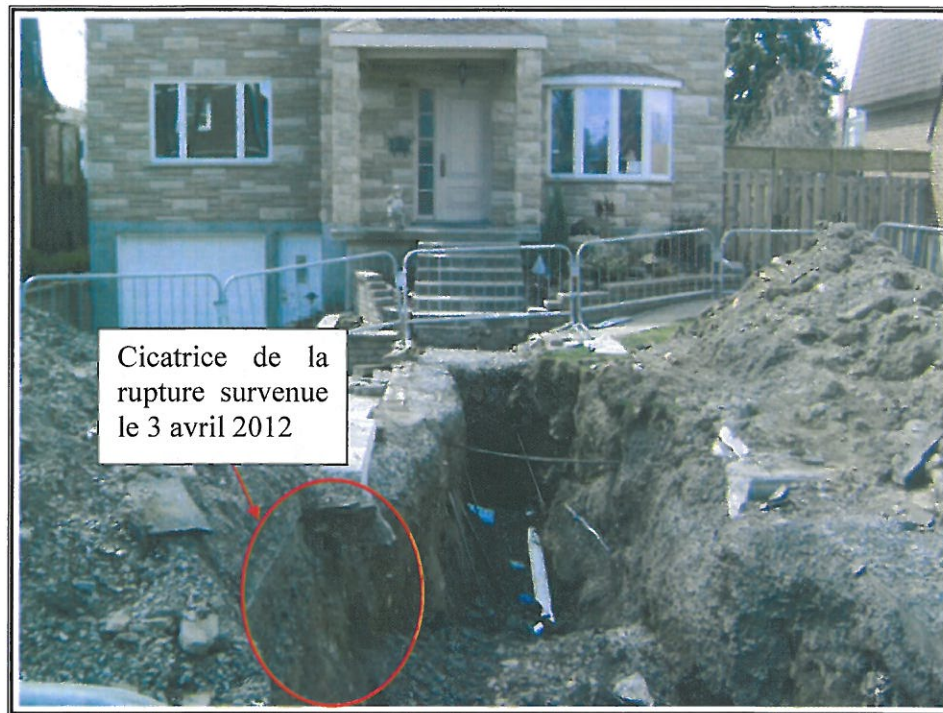
PHOTO 3 : Intérieur de la tranchée. (photo prise par le 10 avril 2012)
