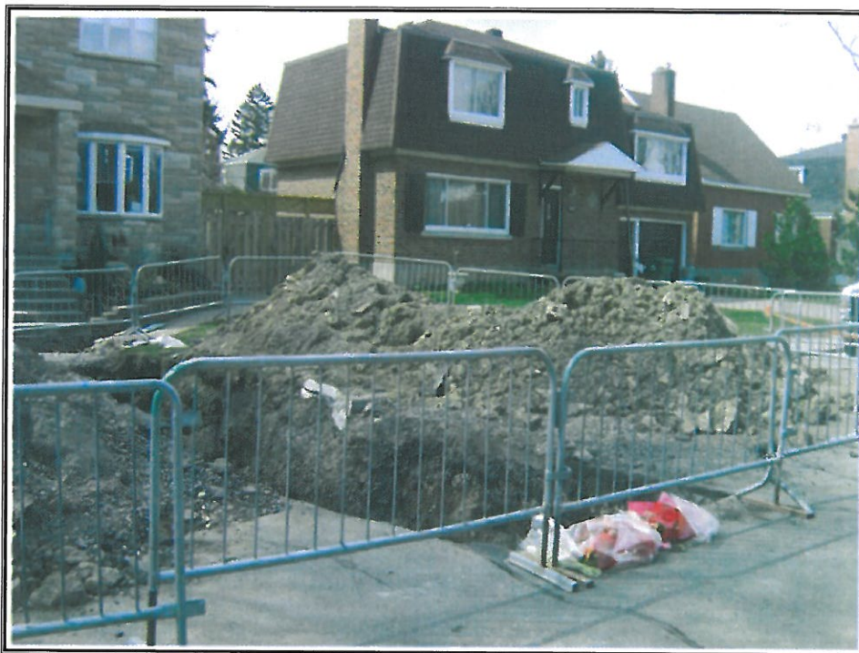
PHOTO 1 : Vue de la tranchée à partir du coin sud-est (photo prise par le 10 avril 2012).
