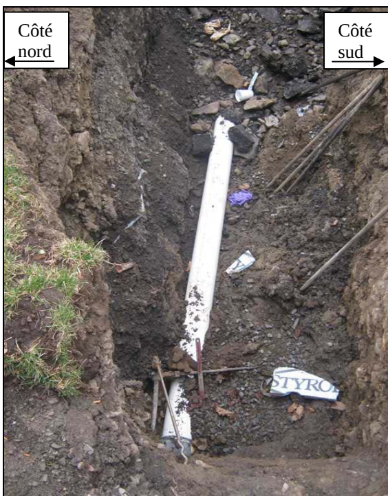
Photo 9 : Première section du conduit d'égout installée avant l'effondrement
