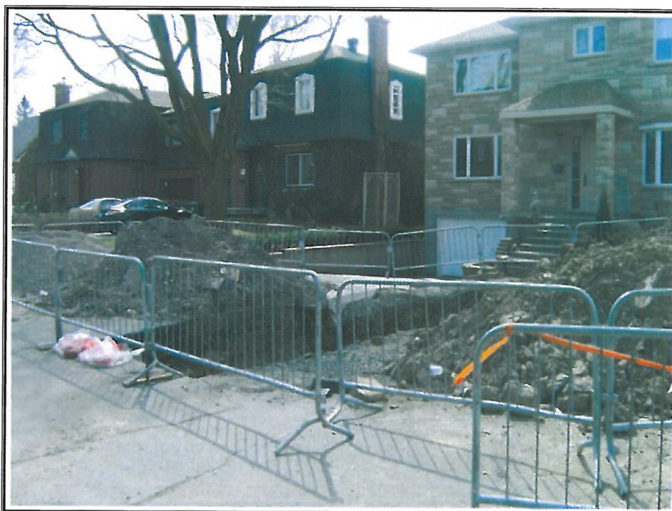
PHOTO 2 : Vue de la tranchée à partir du coin nord-est (photo prise par le 10 avril 2012).
