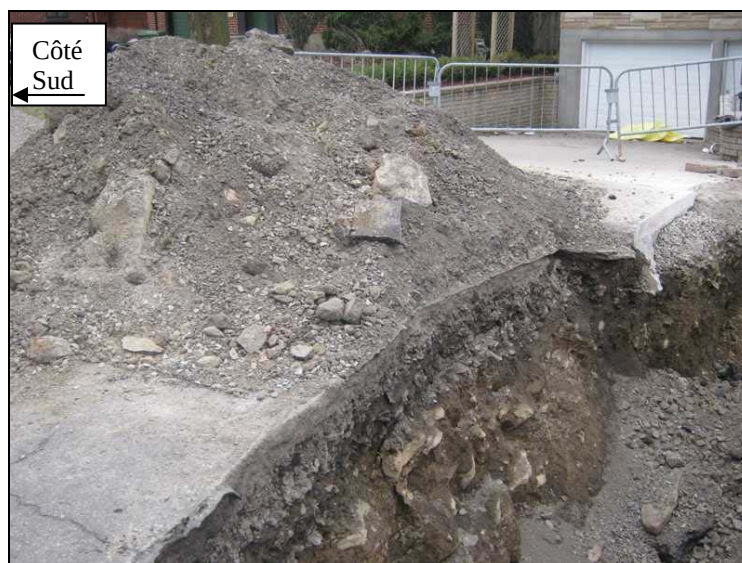
Photo 5 : Remblai de matériaux granulaires entreposé au sommet de la paroi sud de la tranchée
