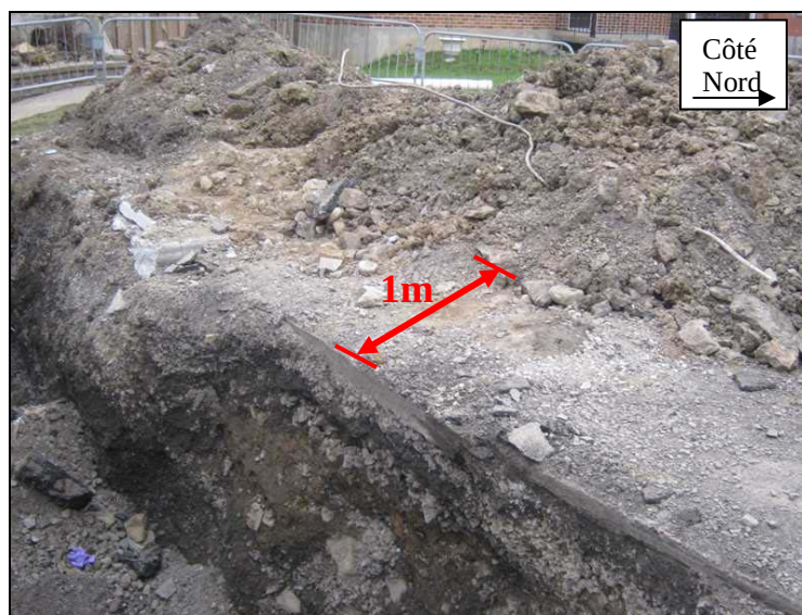
Photo 6 : Déblai naturel entreposé à 1m de la paroi nord de la tranchée
