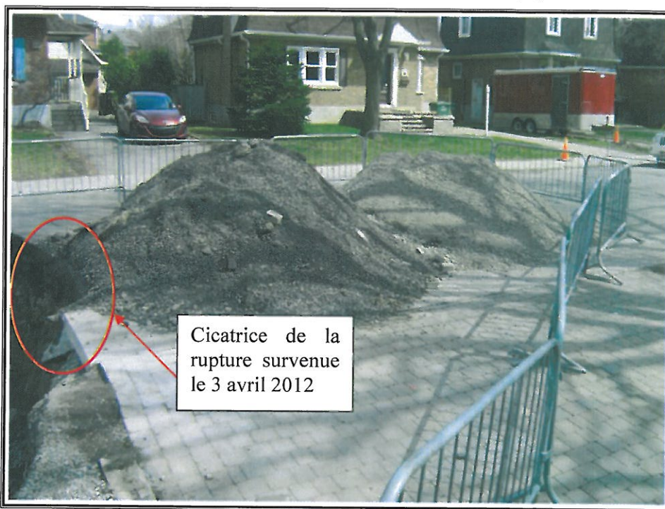
PHOTO 4 : Déblais de matériau MG-20 entreposés au sud de la tranchée. Le premier tas (le plus rapproché) a été extrait de la tranchée. Le second tas (le plus éloigné) a été livré au chantier le 3 avril 2012. (photo prise par le 10 avril 2012)
