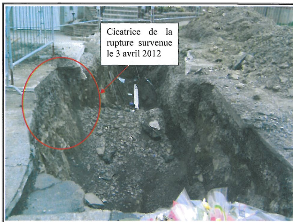
PHOTO 3A : Intérieur de la tranchée. (photo prise par le 11 avril, après enlèvement du déblai)
