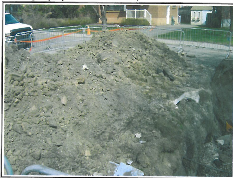
PHOTO 5 : Déblais extraits de la tranchée (entreposés au nord de la tranchée). (photo prise par le 10 avril 2012)
