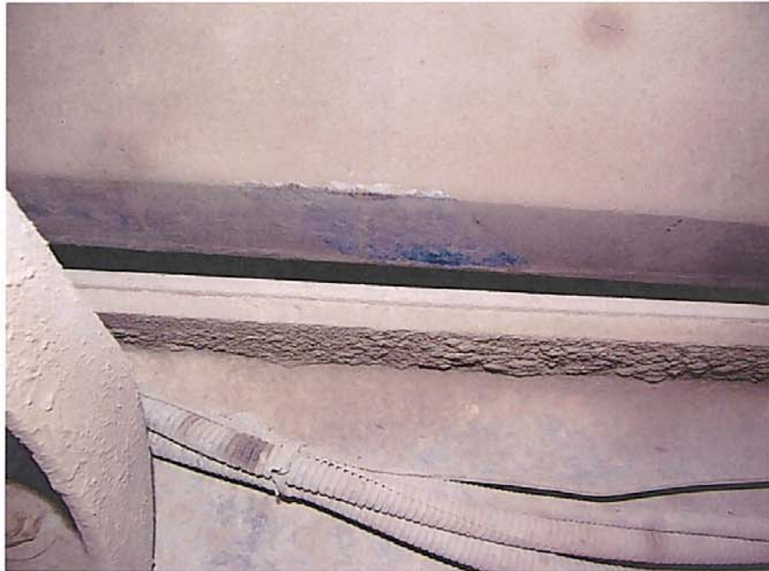
Photographie 5 : Marque en diagonale sous le renfort inférieur de la benne
