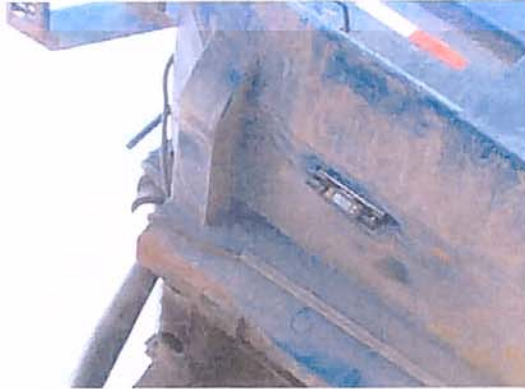
photo 6 Source CSST niveau d'angle
