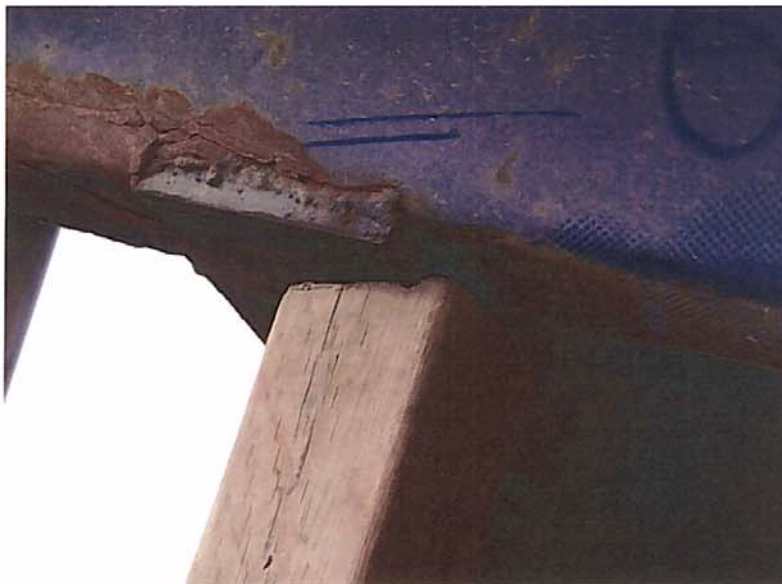
Photographie 4 : Blocage du bois sous la benne
