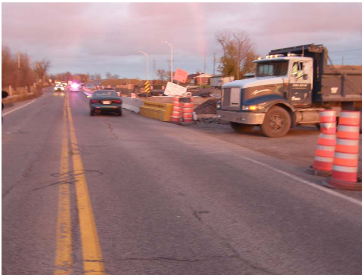
Photo 1: Accès numéro un du chantier; source : CSST
