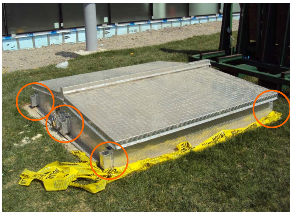
Photo 5 : Puits d'accès 1 (double) du réservoir 5 : les cercles illustrent les points d'ancrage de garde-corps amovibles Source : CSST
