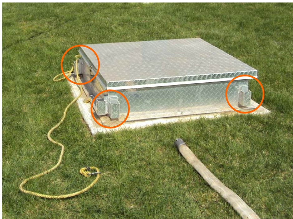
Photo 4 : Puits d'accès 2 (simple) du réservoir 5 : les cercles illustrent les points d'ancrage de garde-corps amovibles Source : CSST
