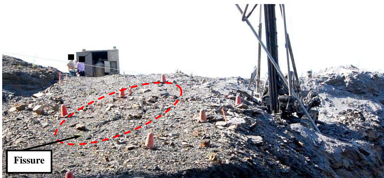
Figure 18 : Fissure présente sur les lieux la journée de l'accident (source : CSST).
