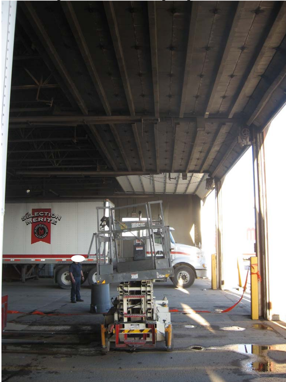
Photo 2 : La plateforme élévatrice après qu'elle ait été redressée
