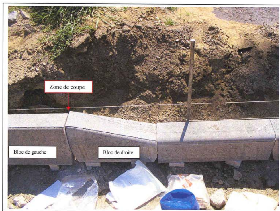
Photo 6. En glissant, le bloc de gauche aurait poussé la lame de scie vers la droite. Cette inclinaison de la lame aurait favorisé le phénomène de cabrage.
