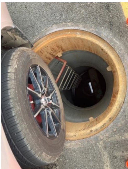
Fig. 4 - Regard d'égout Source : CNESST
