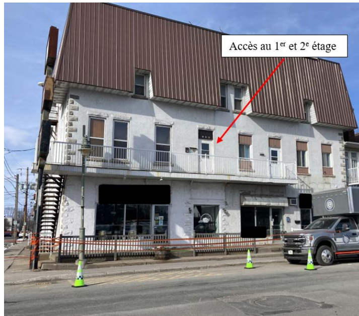
Fig. 7 - Façade du bâtiment d'habitation Accès aux appartements du 1 er et 2 e étage Source : CNESST
