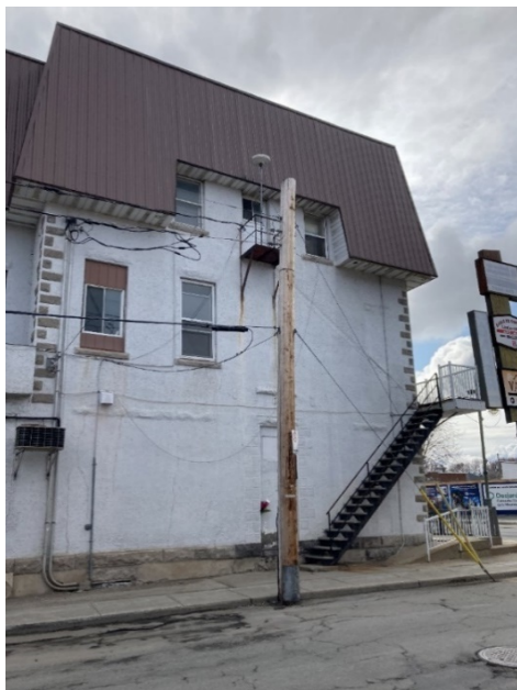
Fig. 6 - Escalier extérieur principal Accès aux appartements du 1 er et 2 e étage Source : CNESST
