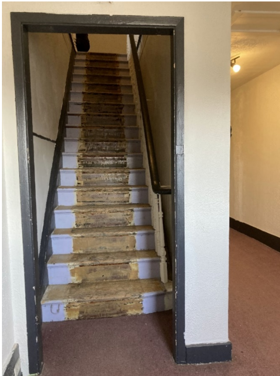
Fig. 8 - Escalier intérieur Accès vers le deuxième étage Source : CNESST
