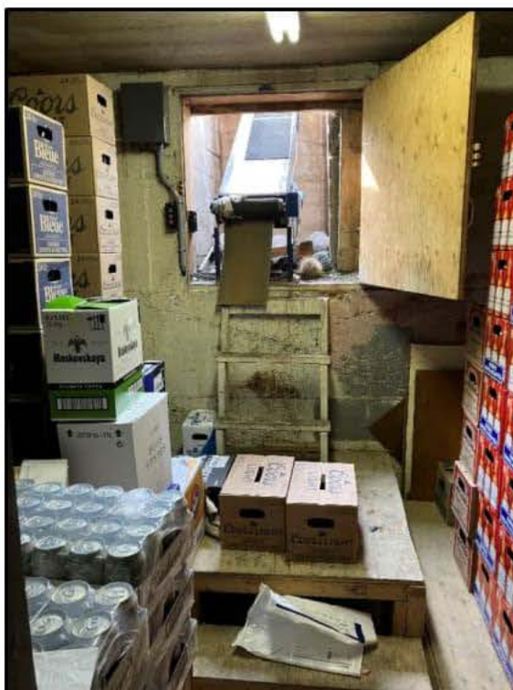
Fig. 4 – Section de réception et d'entreposage des boissons du sous-sol
