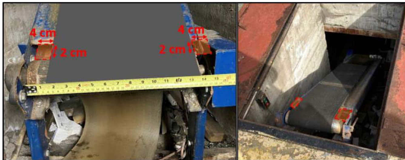
Fig. 9 – Ouvertures donnant accès aux angles rentrants au haut et au bas du convoyeur Source : CNESST
