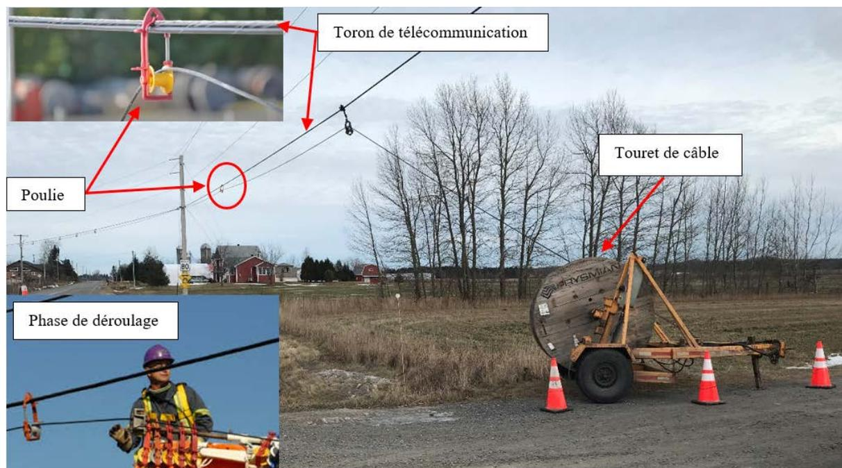
Fig. 7 : Câble à fibre optique retenu par les poulies lors de la phase de déroulage<sup>1</sup>
