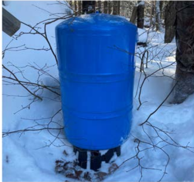
Fig. 13 - Photographie d'un réservoir d'eau pressurisé Source : CNESST
