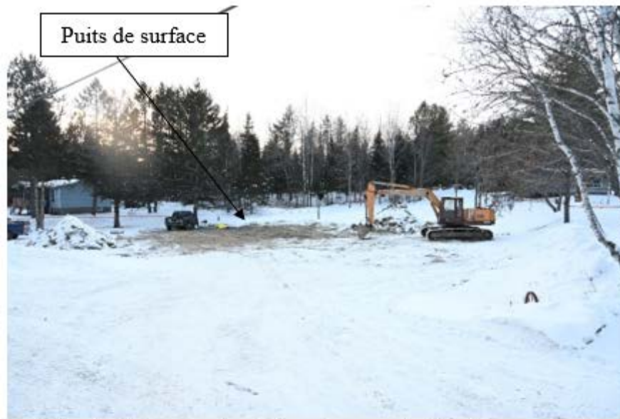
Fig. 4 - Photographie du lieu de travail – Vue direction sud Source : CNESST
