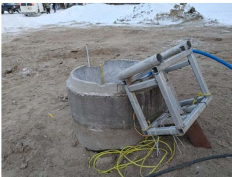
Fig. 8 - Photographie du puits de surface Source : CNESST
