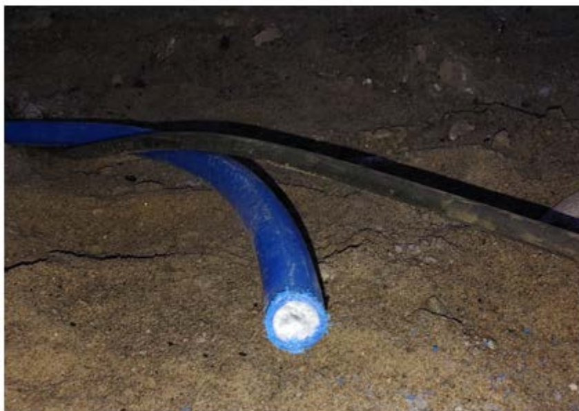
Fig. 9 - Photographie de la conduite d'eau – Section coupée après l'accident Source : CNESST
