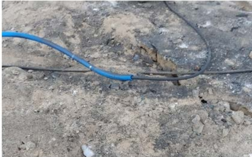
Fig. 17 - Photographie du tuyau de vapeur inséré dans la conduite d'eau Source : CNESST
