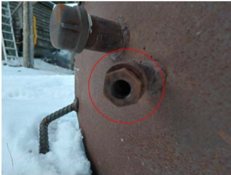
Fig. 21 - Photographie du raccordement à la chaudière artisanale Source : CNESST
