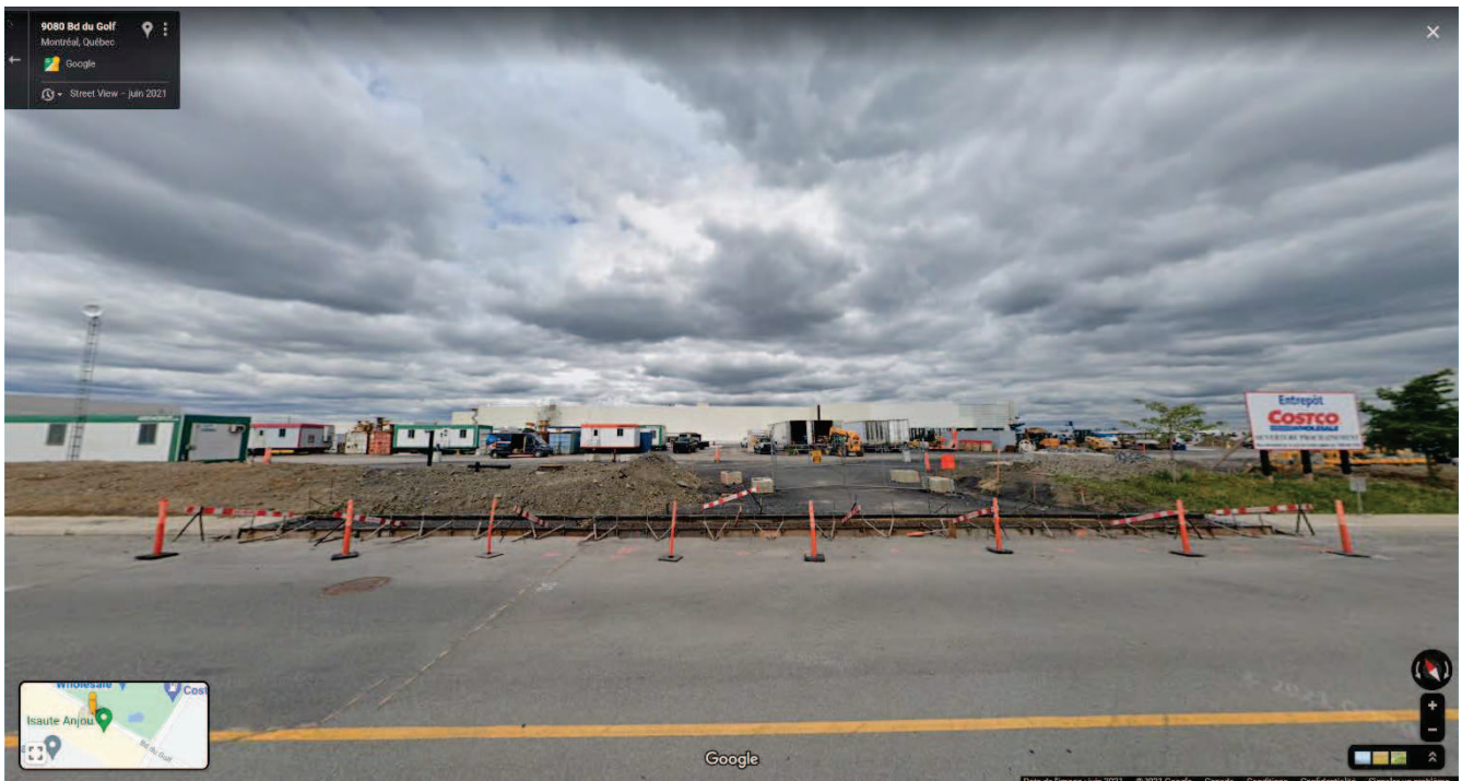
Fig. 4 - Site de l'accident avant la coulée de béton Source : Google Street View [vers 14h30, le 22 juin 2021]
