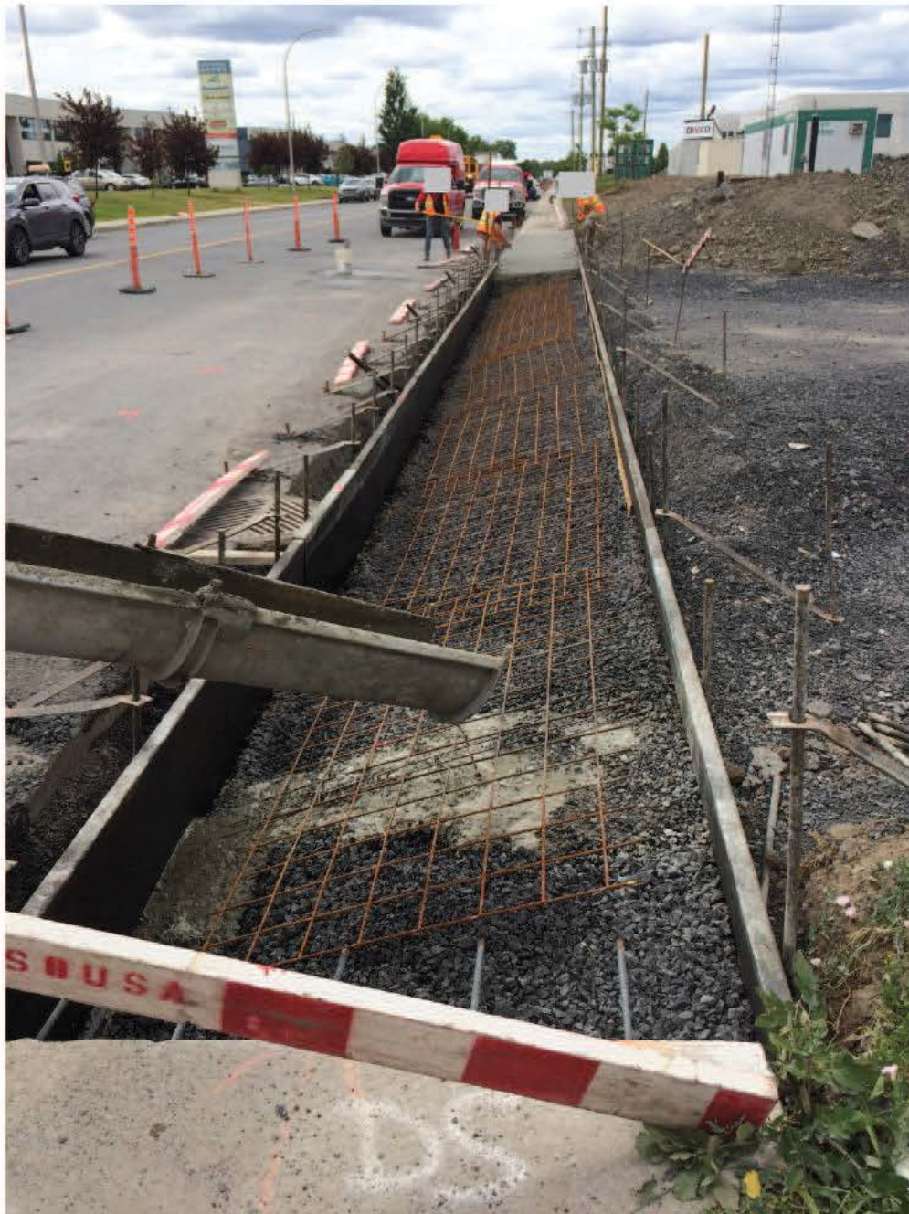
Fig. 5 - Entrée charretière du lieu de l'accident pendant les travaux de coulée Source : Ville de Montréal
