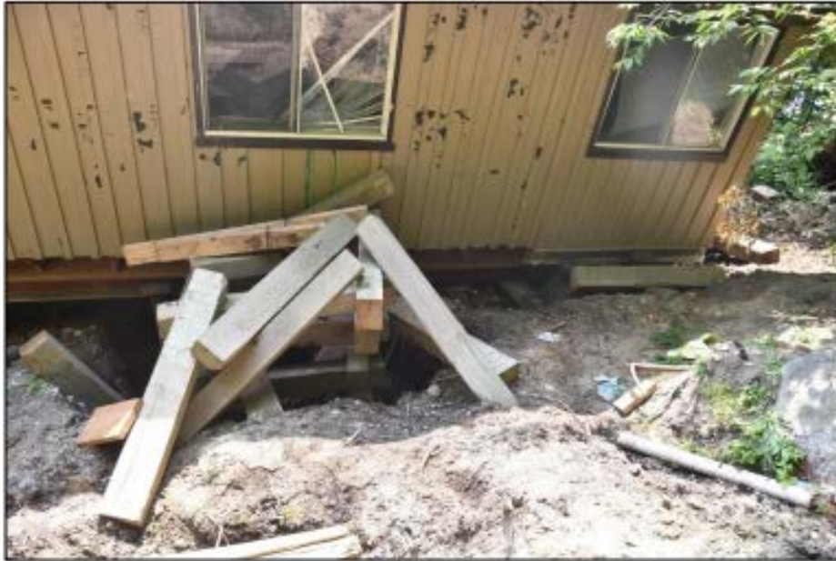
Photo 20 : Effondrement latéral de la cage B
