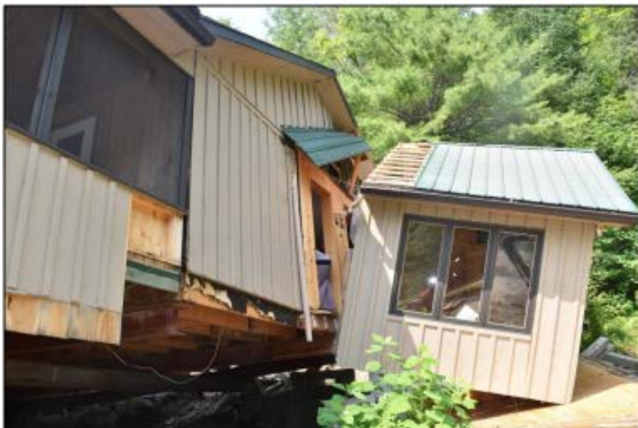
Photo 29 : Annexe latérale partiellement décrochée du bâtiment principal
