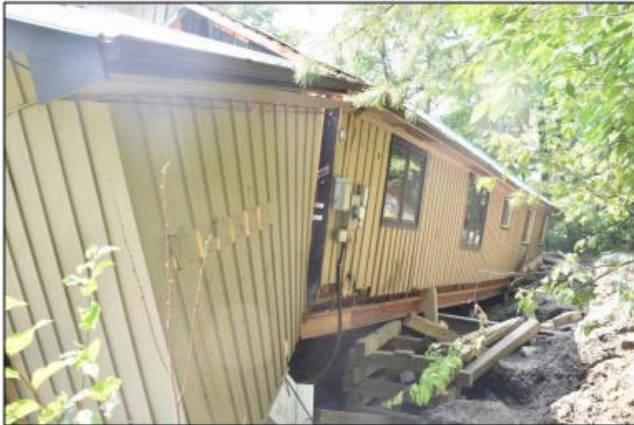
Photo 28 : Annexe latérale partiellement décrochée du bâtiment principal
