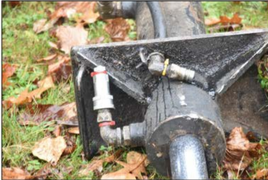
Photo 11 : Vérin de l'appui D (sud-est), connecteur femelle brisé au tuyau et l'autre simplement désaccouplé
