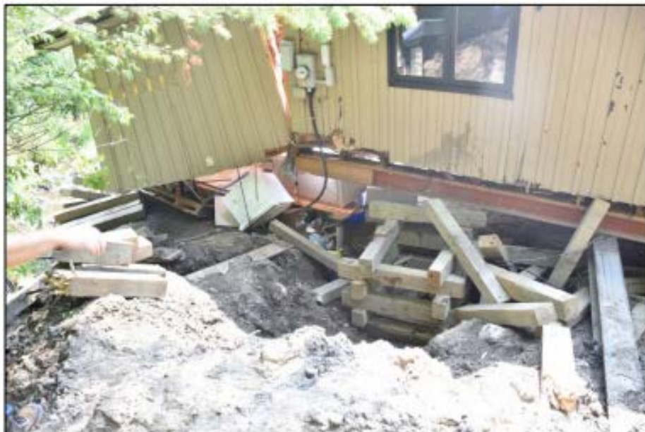
Photo 23 : Effondrement latéral de la cage A et déplacement de l'extrémité de la poutre de levage
