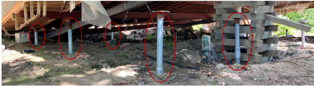
Fig. #17: Une partie des pieux vissés
