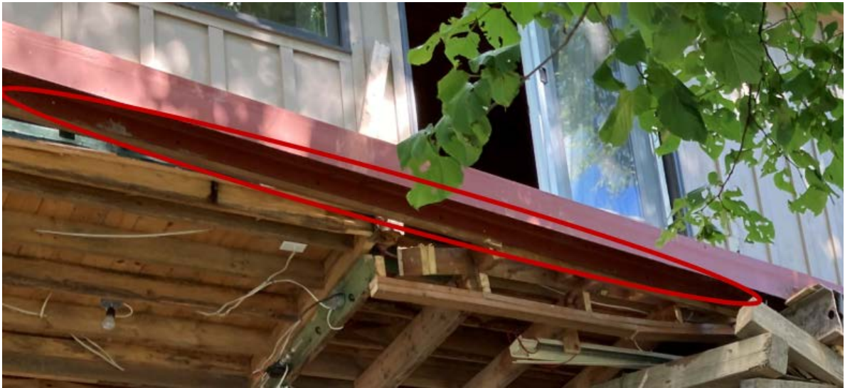
Fig. #15: Poutre d'acier non fixée à la charpente
