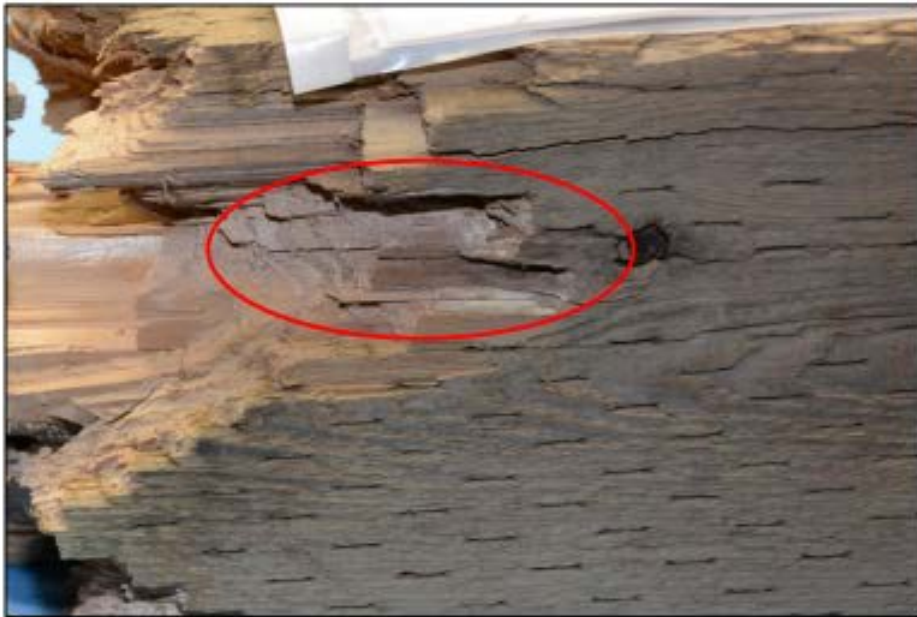
Photo 40 : Oxydation dans le faciès de rupture suggérant une déficience antérieure à l'incident
