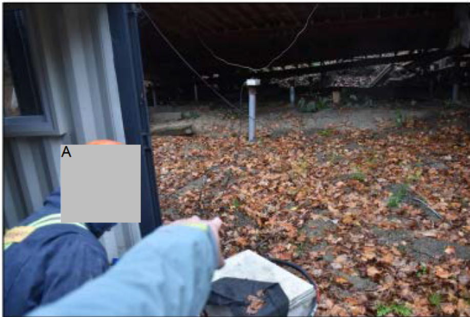
Photo 3 : Manette de contrôle déposée sur l'un des pieux sous la maison levée
