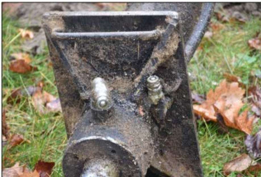
Photo 14 : Vérin de l'appui C ( sud-ouest ), connecteurs simplement désaccouplés des tuyaux
