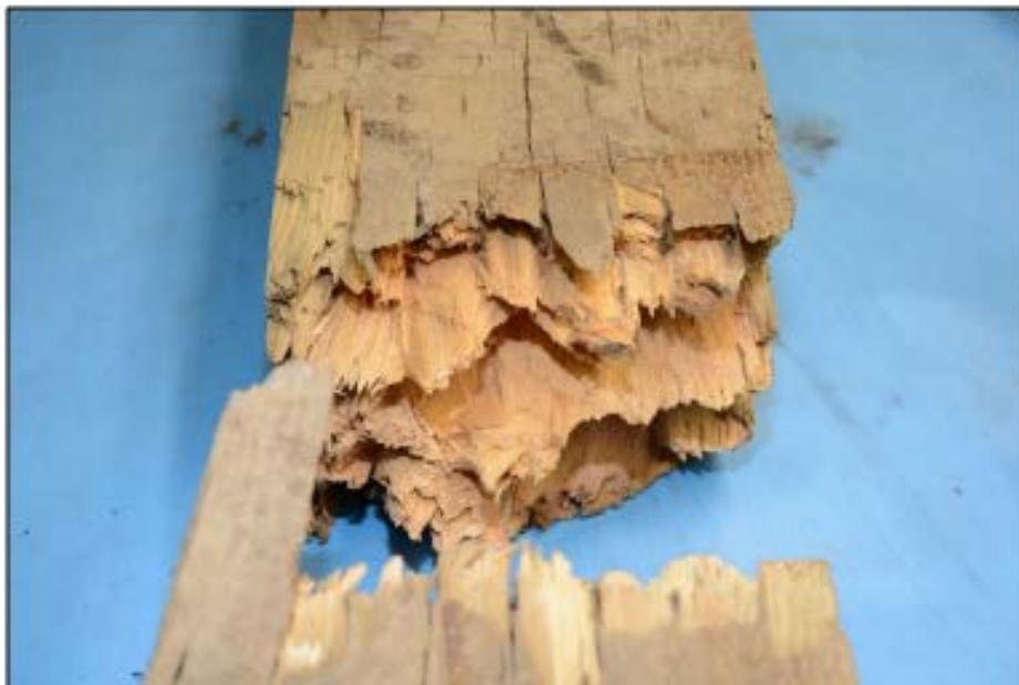
Photo 33 : Rupture de la pièce B ne présentant pas de défaut préexistant
