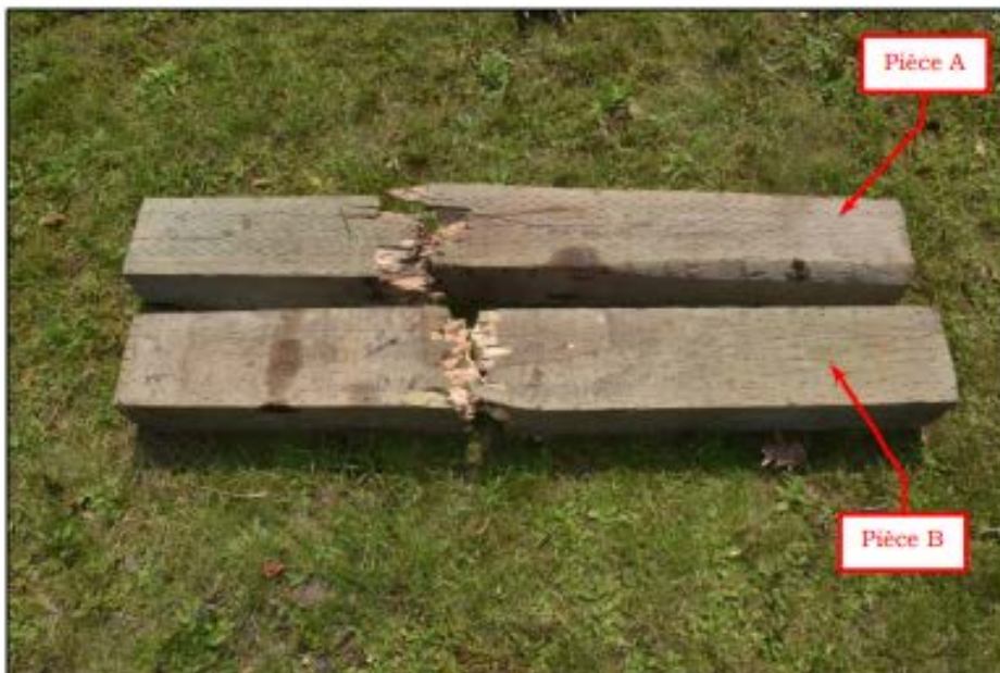
Photo 27 : Pièces de transfert rompues de la cage A et prélevées pour examen
