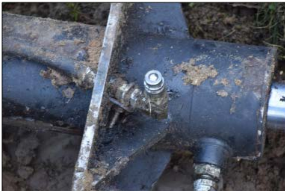
Photo 16 : Vérin de l'appui B ( nord-ouest ), l'un des connecteurs est simplement désaccouplé
