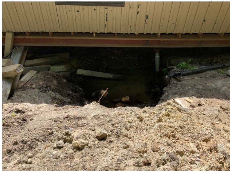
Fig. #16: Excavation située au centre à l'arrière du bâtiment afin d'y accueillir une tour de caissons
