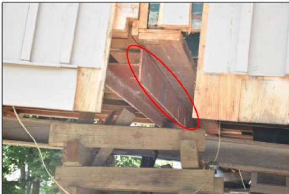
Photo 6 : Poutre déversée le long du mur avant (axe D) non-boulonnée sous l'annexe avant
