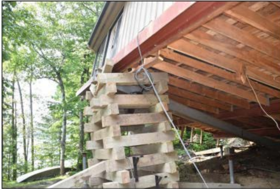
Photo 18 : Vérin désaxé ne supportant plus la poutre de levage dans la cage C
