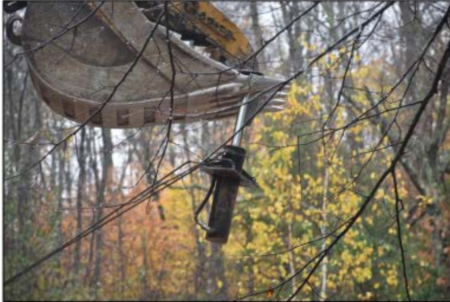
Photo 13 : Vérin de l'appui C ( sud-ouest ) récupéré par la pelle mécanique, tuyau encore branché
