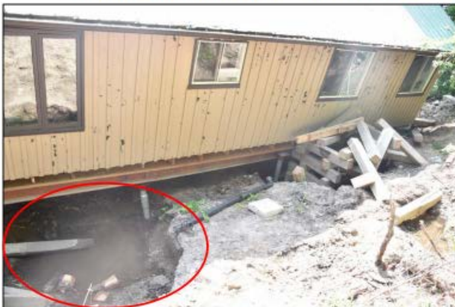
Photo 10 : Espace excavé pour une cage de levage additionnelle approximativement à mi-chemin entre les deux cages arrière (A et B)
