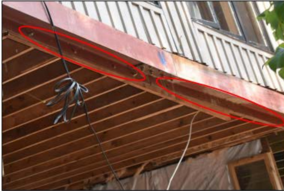
Photo 5 : Poutre déversée le long du mur avant (axe D), boulonnée à gauche de la jonction et non-boulonnée à droite
