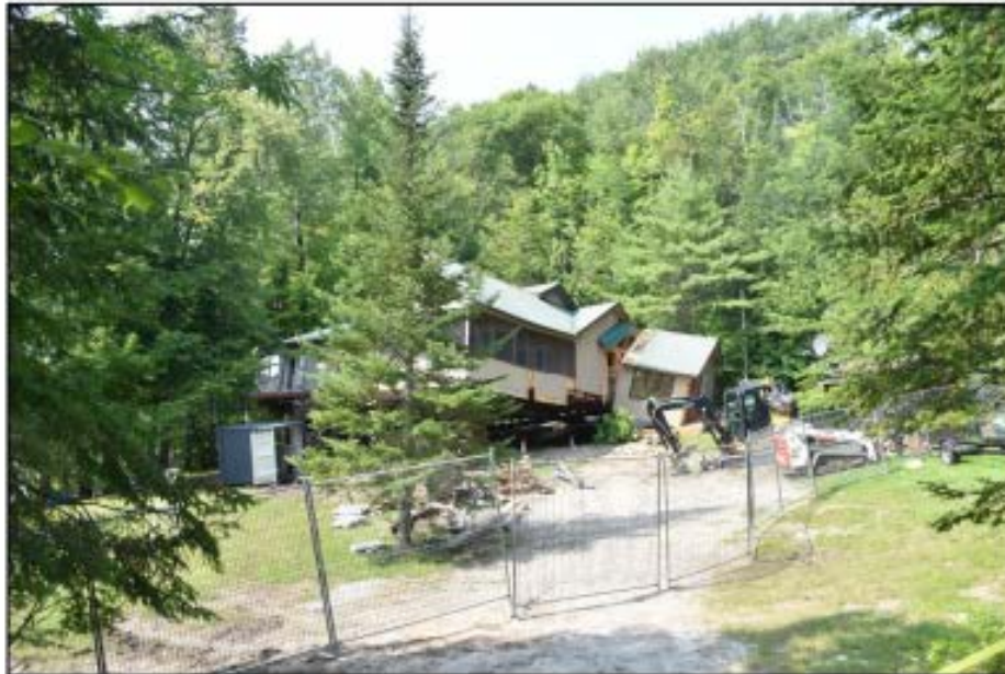
Photo 1 : Vue générale du chantier
