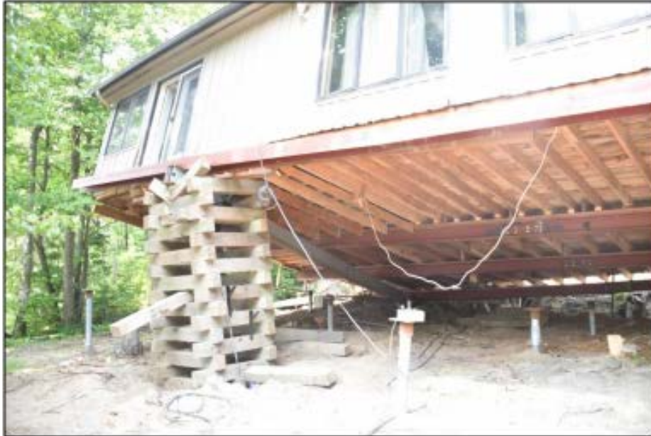
Photo 13 : Cage C demeurée relativement intacte (à l'exception de la rupture de quelques pièces au sommet)
