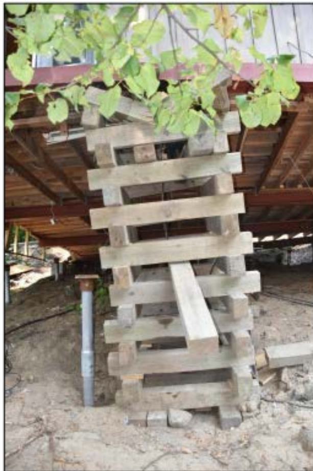
Photo 17 : Cage C désaxée suite à l'incident
