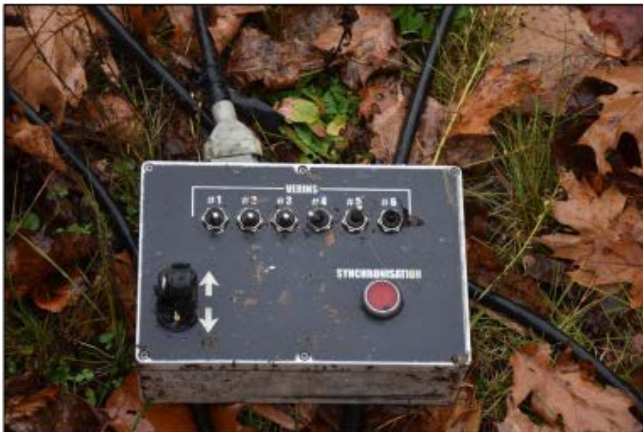
Photo 12 : Manette de contrôle récupérée sous les décombres
