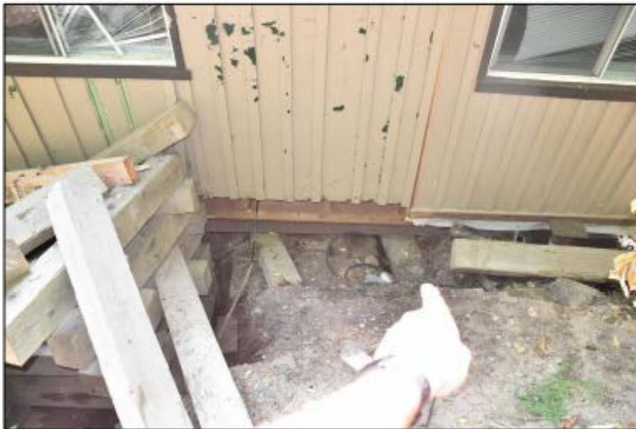
Photo 21 : Extrémité de la poutre de levage déplacé latéralement par rapport à la cage B
