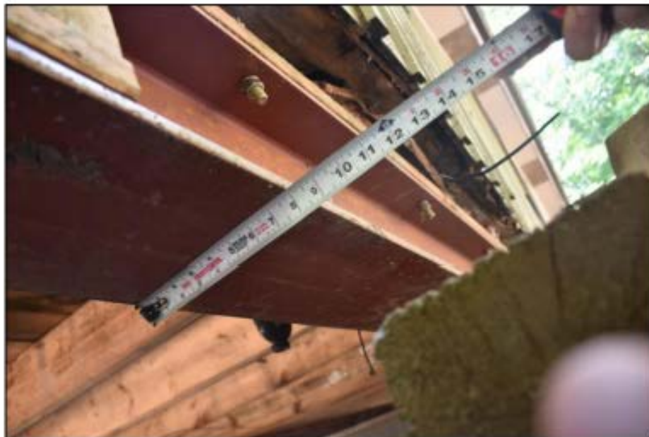
Photo 4 : Poutre boulonnée le long du mur arrière (axe A)
