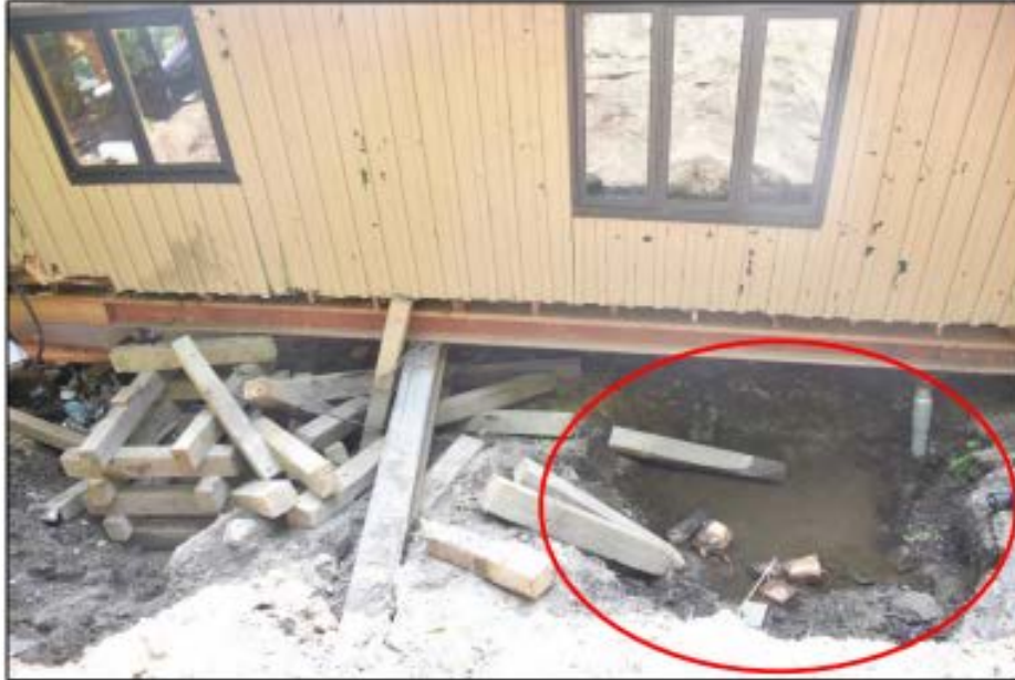
Photo 9 : Espace excavé pour une cage de levage additionnelle approximativement à mi-chemin entre les deux cages arrière (A et B)
