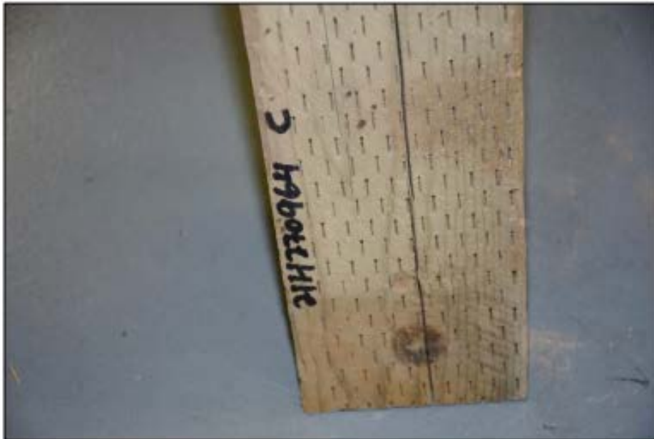
Photo 30 : Pièce C intacte, pruche traitée de grade no 1
