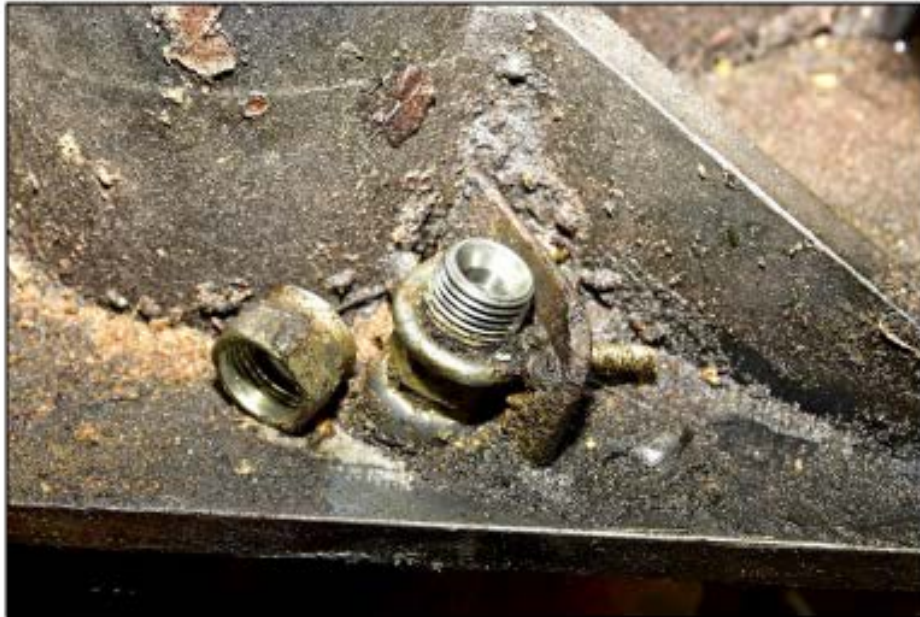
Photo 1 : Raccord inférieur endommagé
