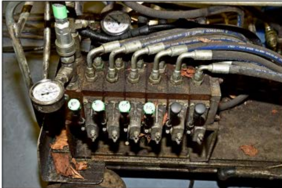
Photo 9 : Leviers des valves de contrôle des vérins
