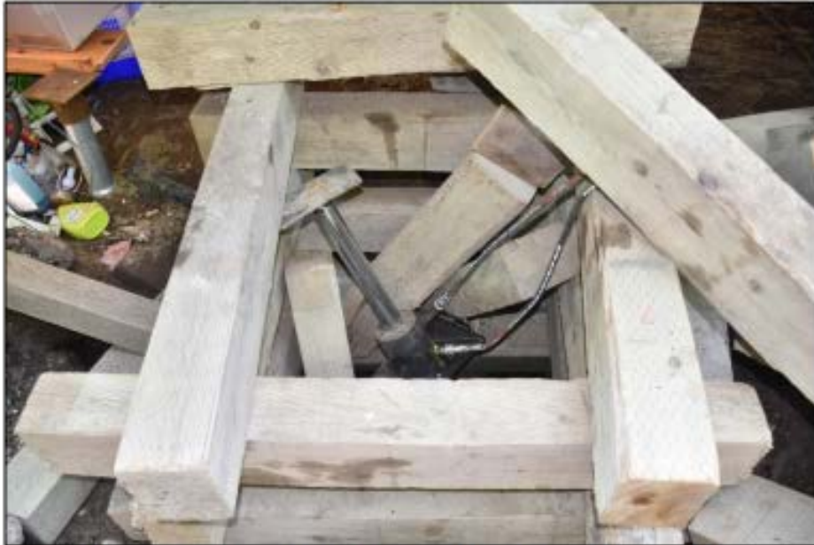
Photo 24 : Vérin et pièces de transfert rompues à l'intérieur de la cage A
