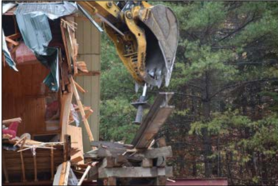
Photo 9 : Vérin de l'appui D ( sud-est ) récupéré par la pelle mécanique
