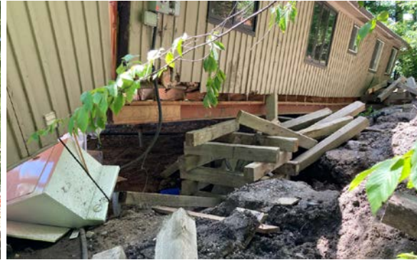
Fig. #10: Arrière du bâtiment Source : CNESST
