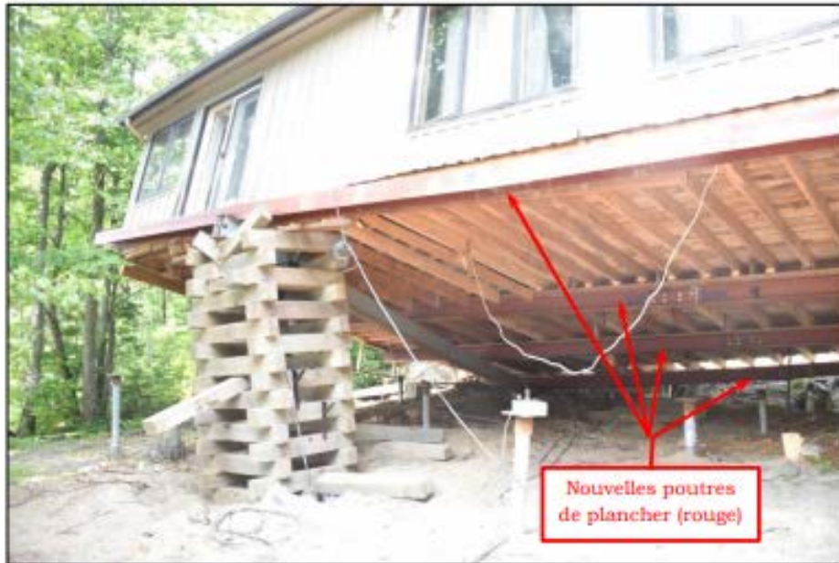
Photo 3 : Nouvelles poutres (rouges) supportant la charpente de bois du plancher
