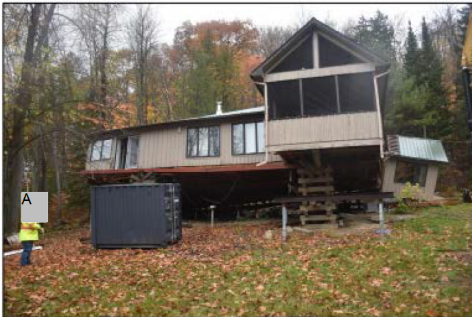
Photo 4 : Module de contrôle du système rangé dans le contenu avant le début de la démolition
