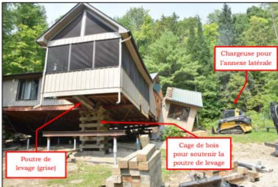
Photo 2 : Système de levage composé de poutres (grises) sur cages de bois et d'une chargeuse
