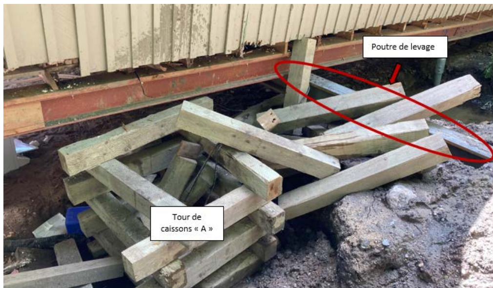
Fig. #11: Déplacement de la poutre de levage Source : CNESST
