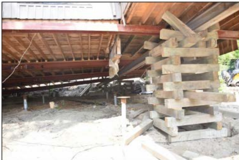
Photo 12 : Cage D demeurée relativement intacte (à l'exception de la rupture de quelques pièces au sommet)
