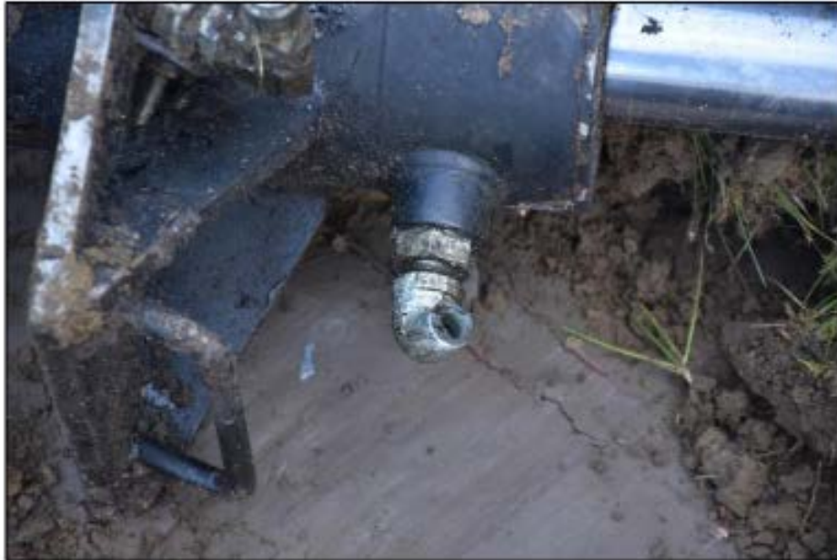
Photo 17 : Vérin de l'appui B ( nord-ouest ), l'autre connecteur mâle est brisé
