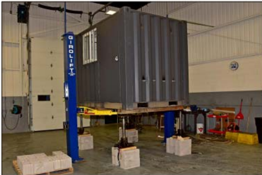
Photo 6 : Installation initiale du conteneur sur les vérins
