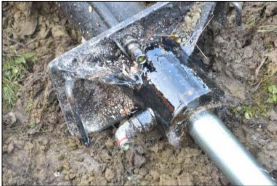
Photo 19 : Vérin de l'appui A ( nord-est ), les deux connecteurs mâles sont brisés
