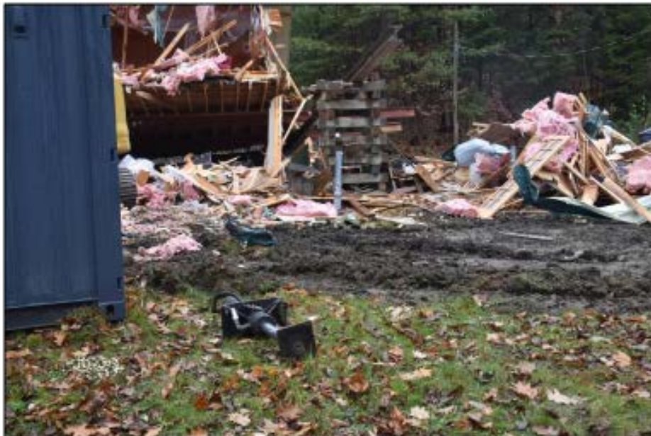
Photo 10 : Vérin de l'appui D ( sud-est )
