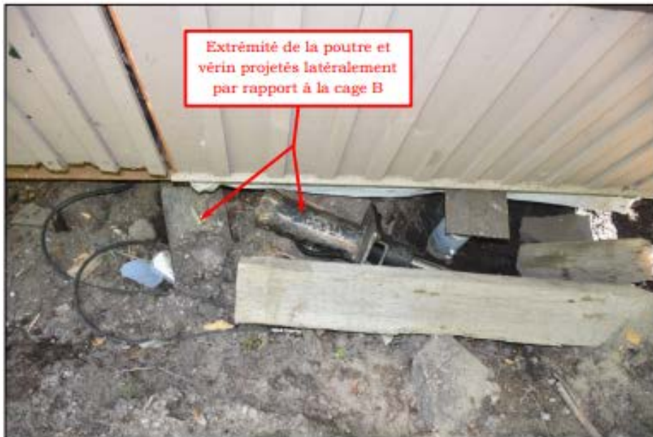
Photo 22 : Vérin plus loin que la poutre par rapport à la cage B
