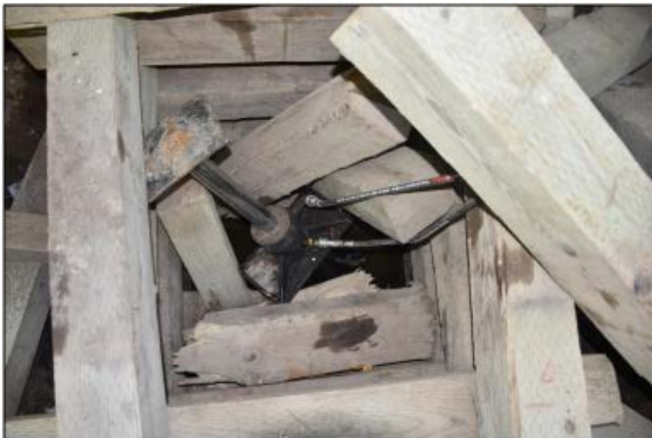
Photo 25 : Vérin et pièces de transfert rompues à l'intérieur de la cage A
