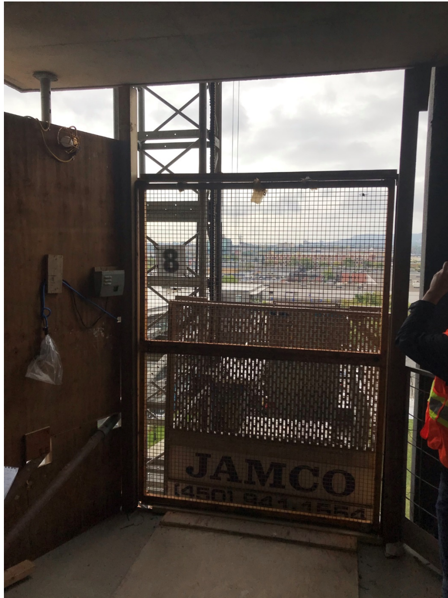
Photo 3 : Exemple de la porte palière du 8° étage (source : CNESST)
