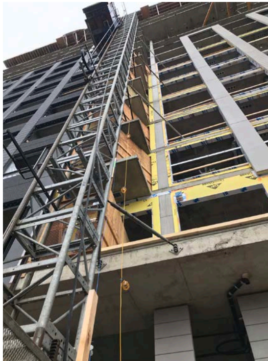
Photo 2 : Ascenseur de chantier (source : CNESST)
