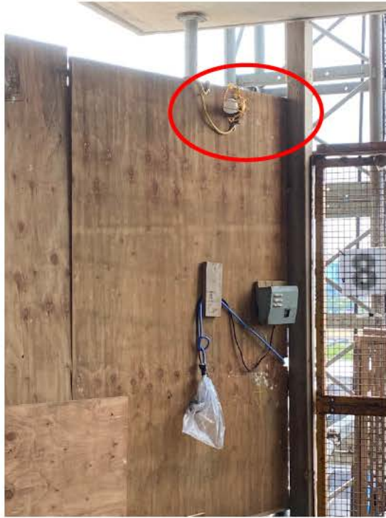
Photo 4 : Lumière installée au 8e étage (source : CNESST)
