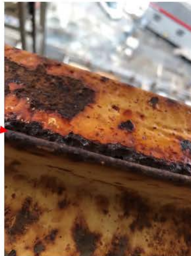
Photo 9 : Dessus du bâti supérieur de la porte palière (source : CNESST)
