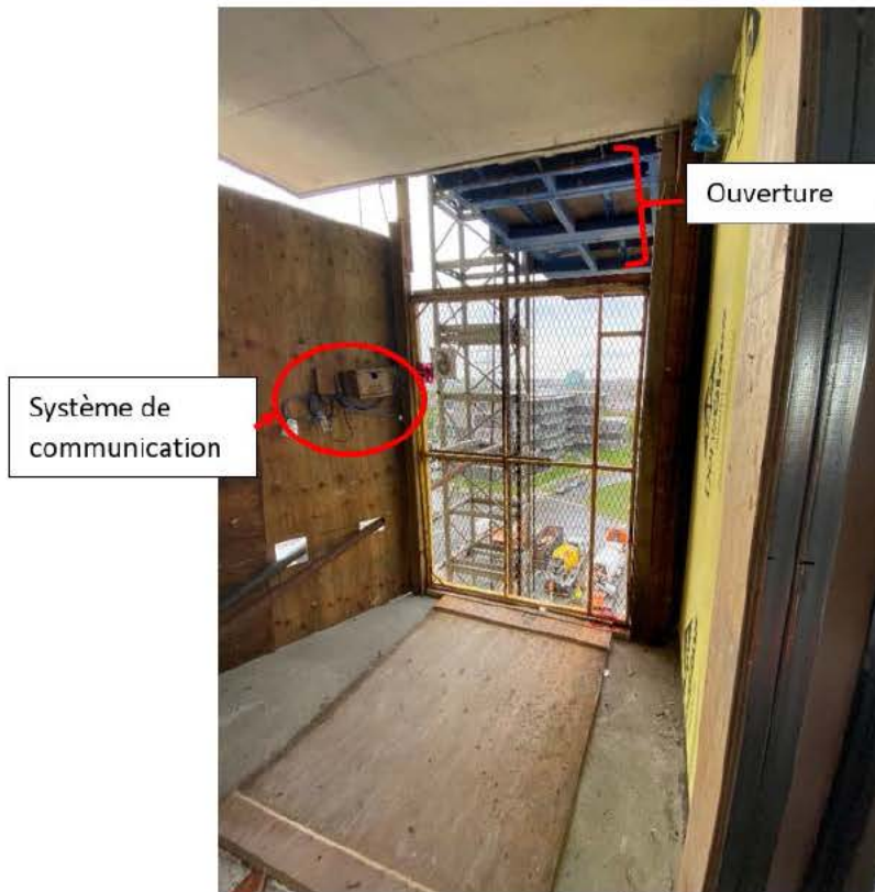
Photo 6 : Porte palière du 6 e étage, configuration similaire au 7 e étage (source : CNESST)
