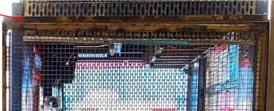
Photo 8 : Haut de la porte palière (source : CNESST)
