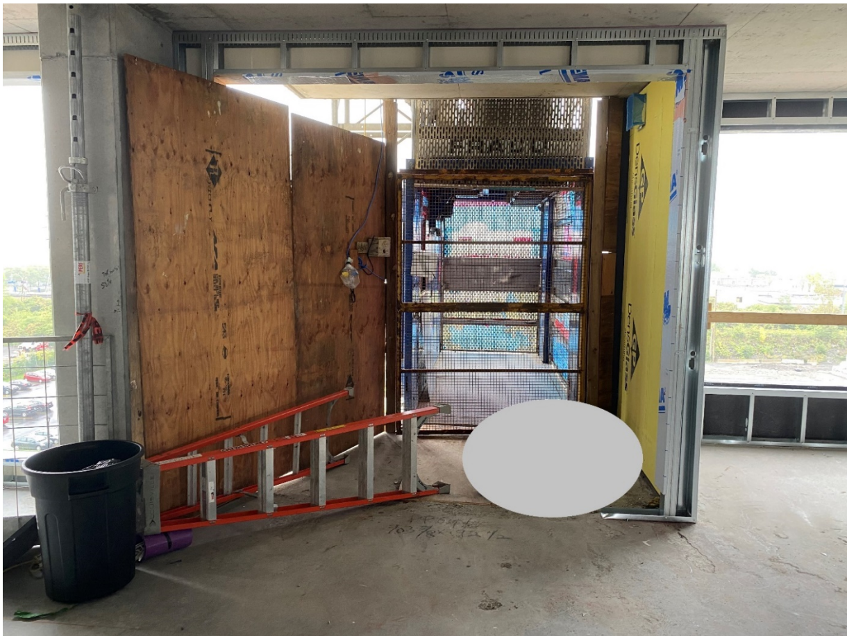
Photo 1: Lieu de l'accident (source : CNESST)
