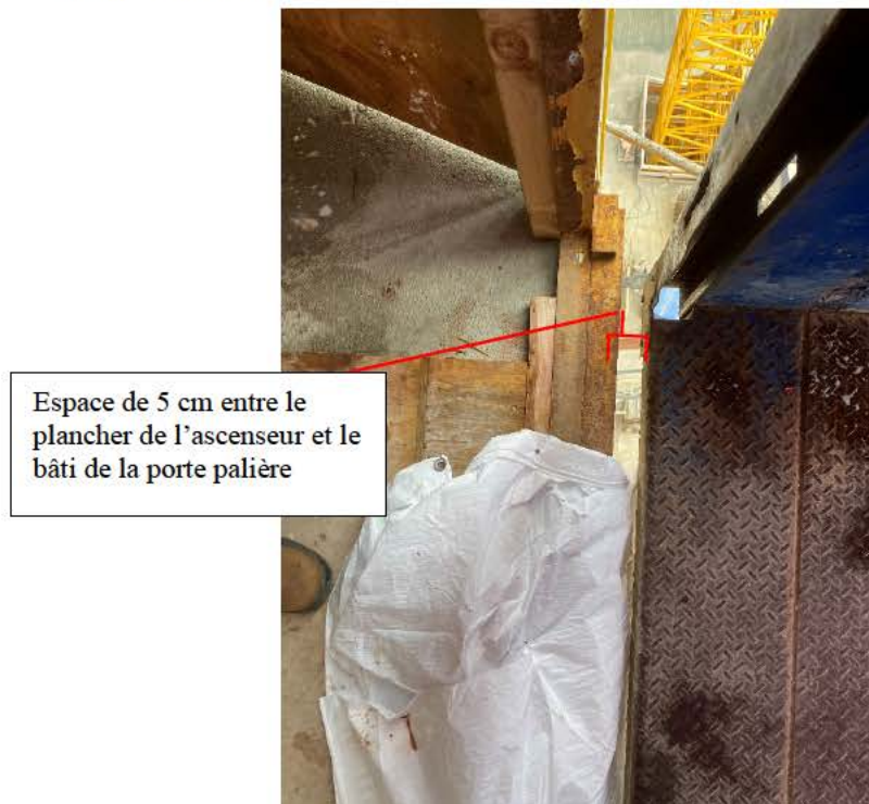
Photo 7 : Espace entre le plancher de l'ascenseur et le bâti de la porte palière (source : CNESST)
