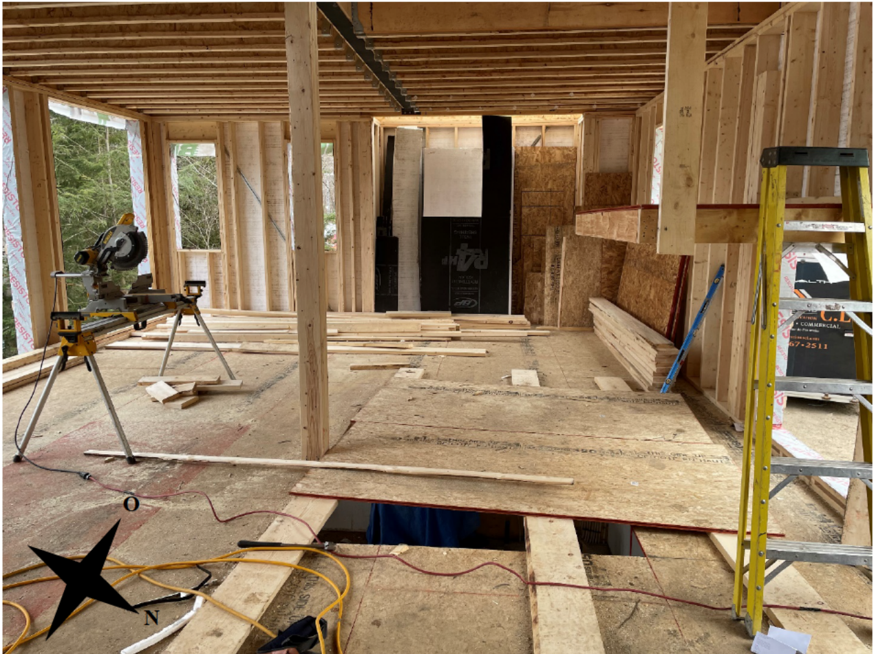
Photo 3 : Ouverture pour la cage d'escalier au rez-de-chaussée
