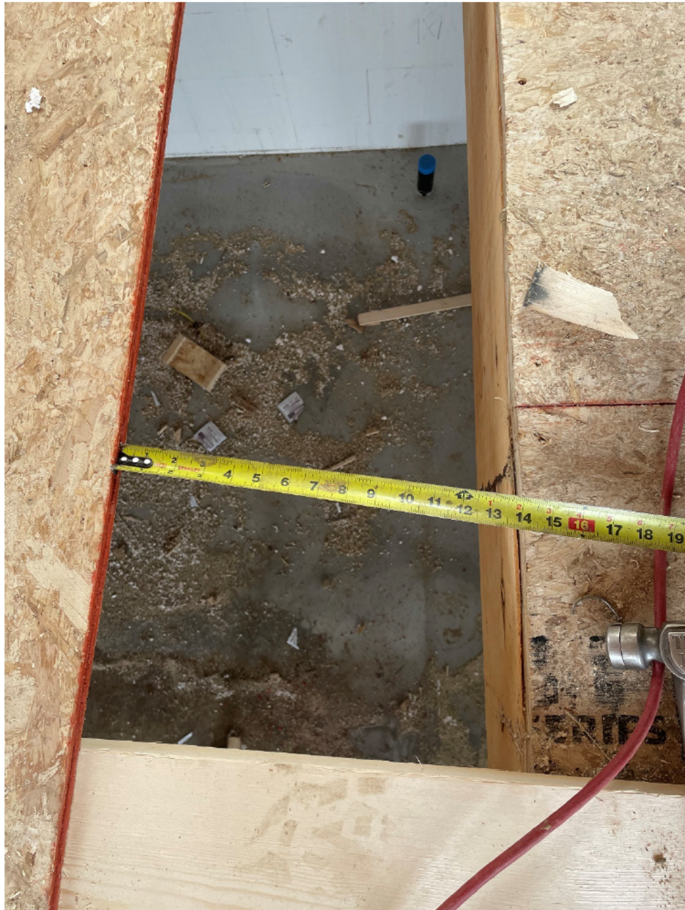
Photo 6 : Ouverture créée au plancher
