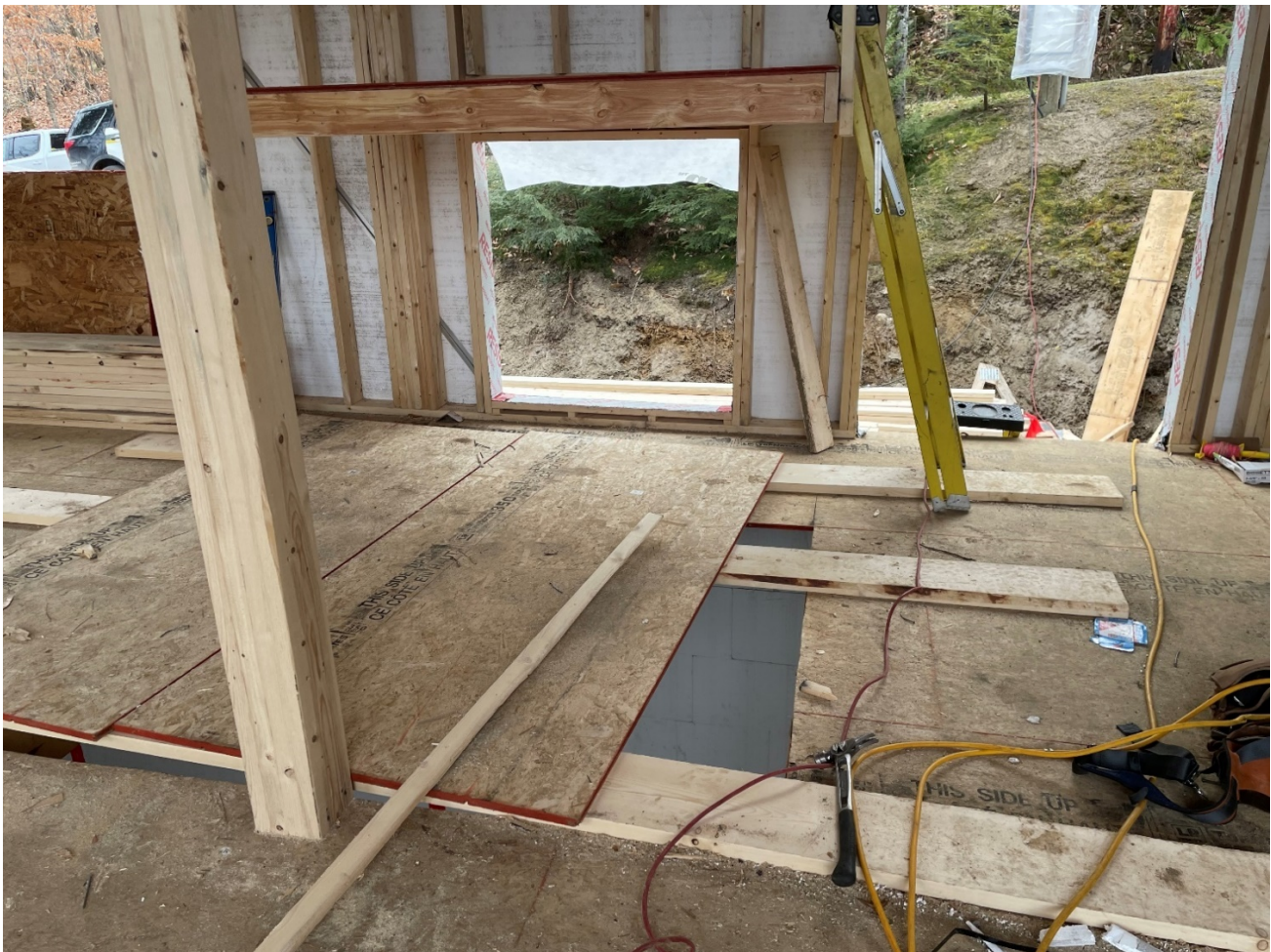
Photo 1 : Lieu de l'accident
