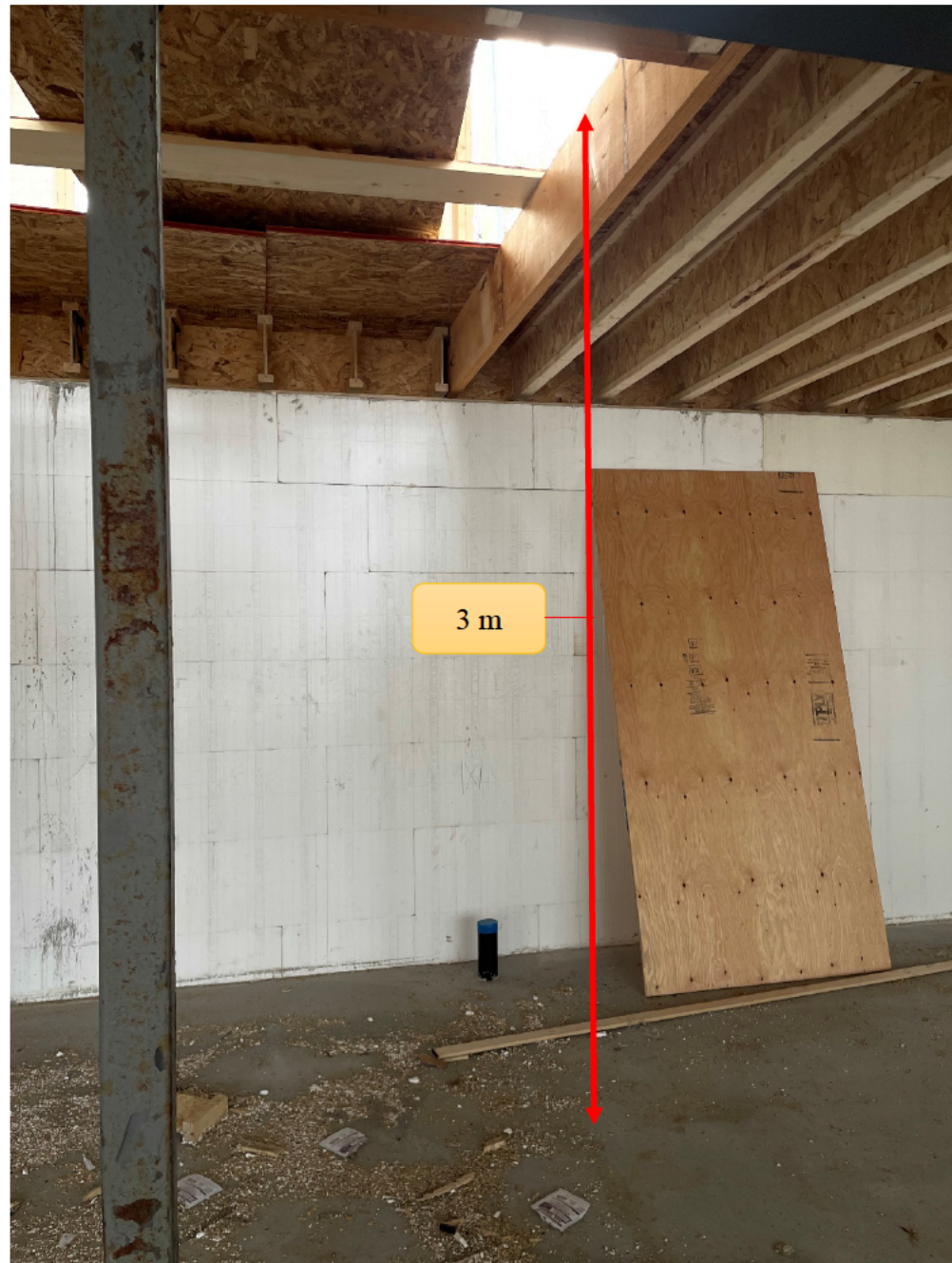
Photo 5 : Hauteur du plancher
