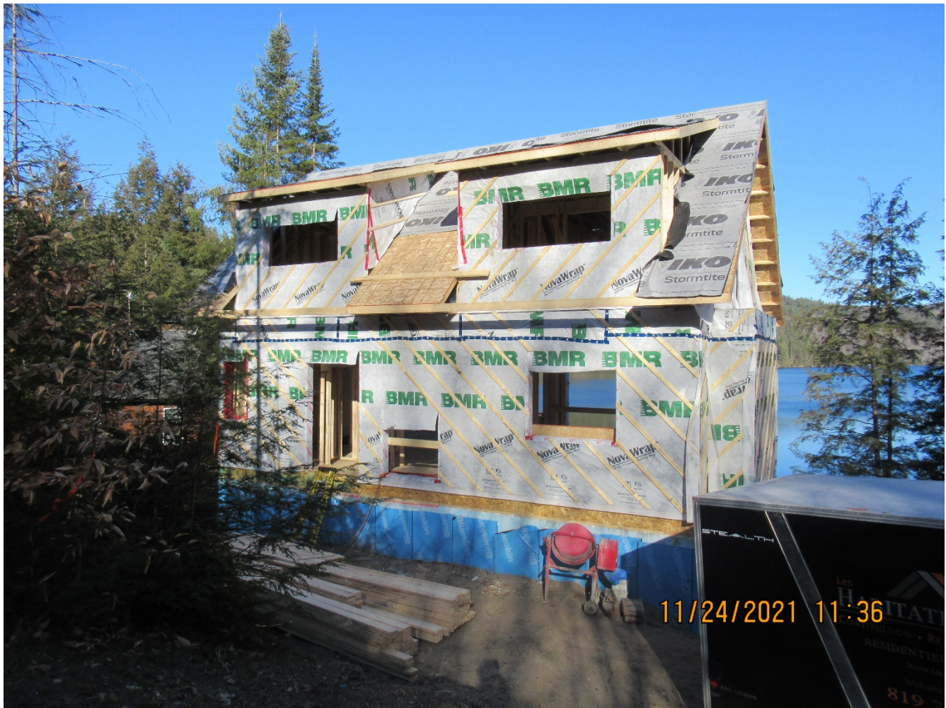
Photo 2 : Vue globale du chantier
