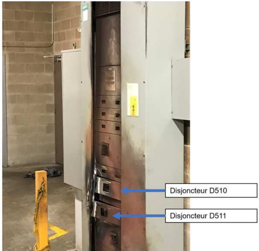
Figure 6 : Panneau S perforé par les éclats d'arcs (source : CNESST)
