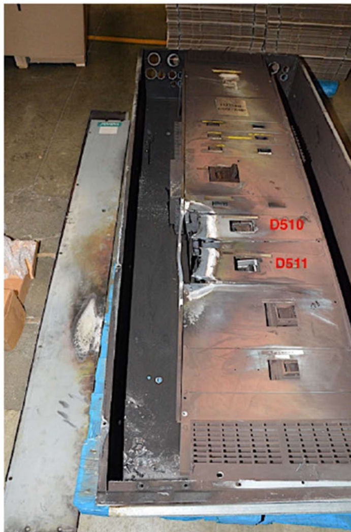
Photographie 2 Vue extérieure - armoire électrique
