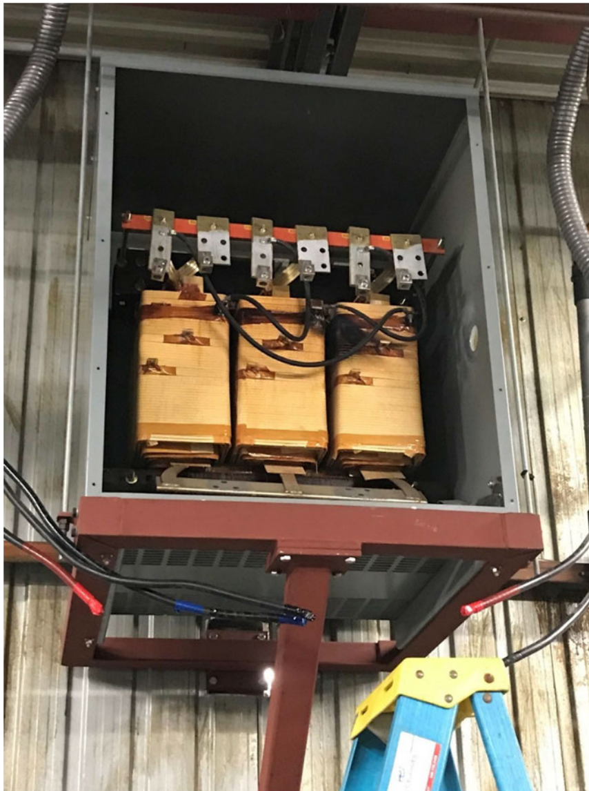
Figure 12 : Transformateur à la suite de l'accident avec le couvercle frontal retiré (source : CNESST)
