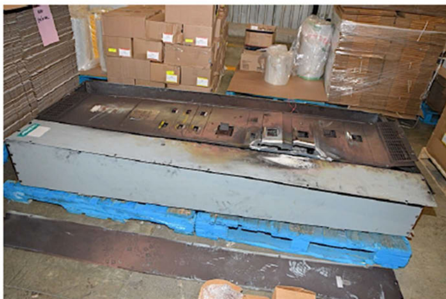
Photographie 1 Vue extérieure - armoire électrique
