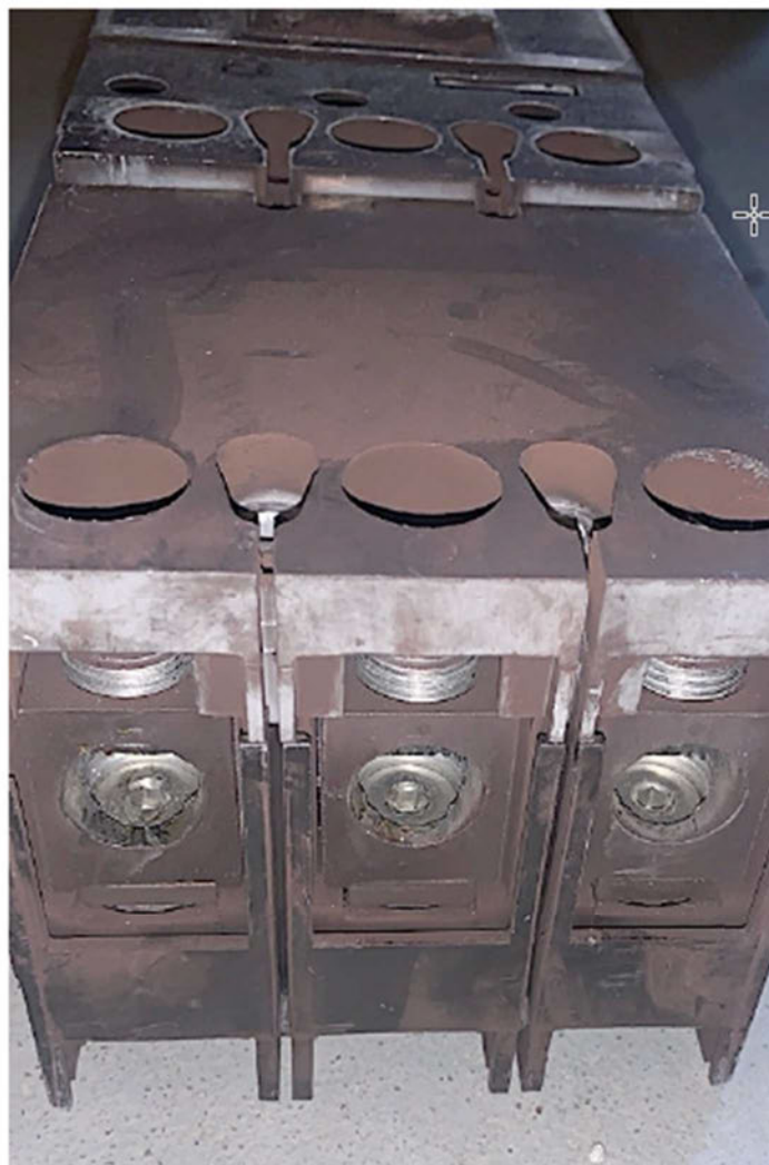
Photographie 21 Disjoncteur D511
