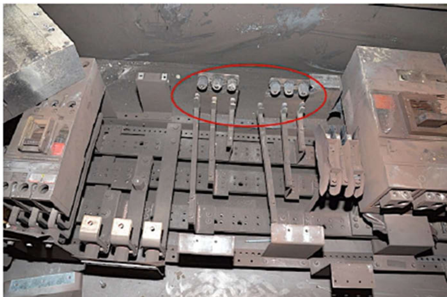
Photographie 11 Destruction des barres secondaires – disjoncteurs D510-D511
