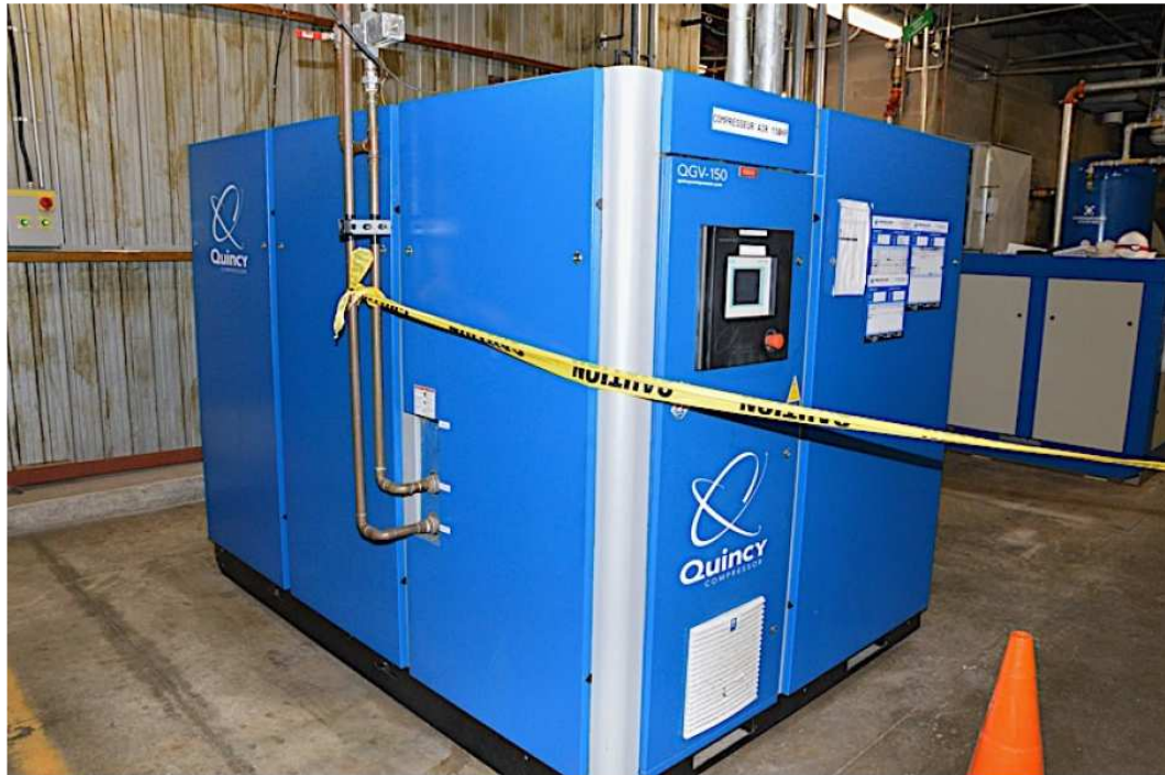
Figure 13 : Compresseur Quincy 150 HP (source : Stéphane Labonté, CEP Forensique)
