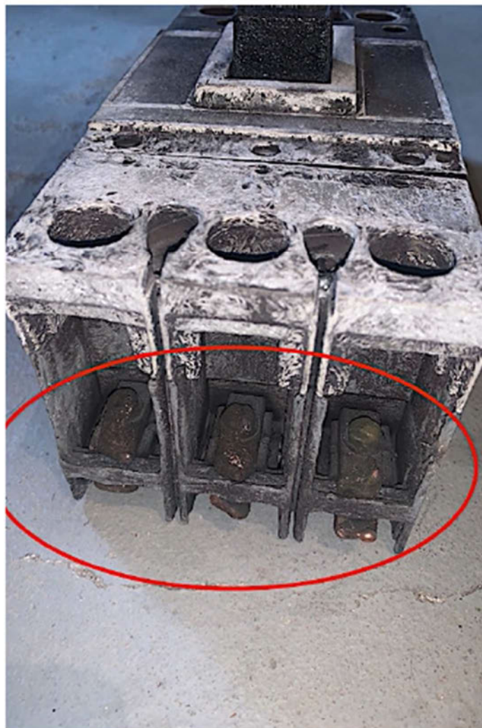
Photographie 18 Disjoncteur D511
