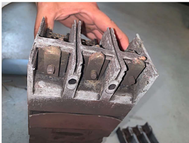
Photographie 20 Disjoncteur D511
