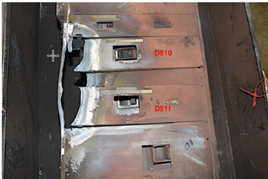
Photographie 3 Dommages par arcs électriques sur la façade de l'armoire électrique
