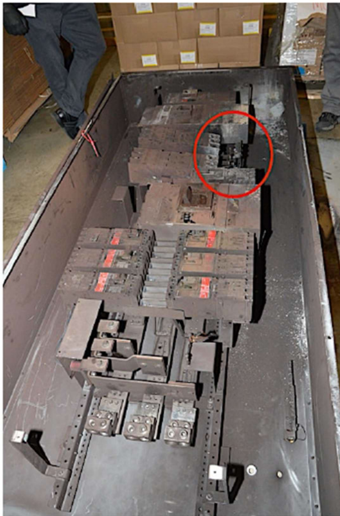
Photographie 8 Vue intérieure de l'armoire électrique
