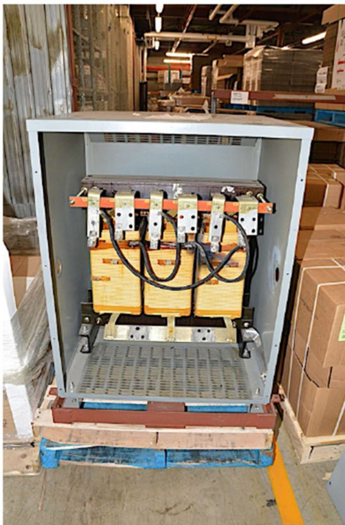
Photographie 13 Transformateur qui alimentait le compresseur
