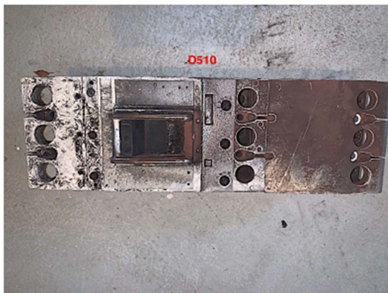
Photographie 24 Disjoncteur D510
