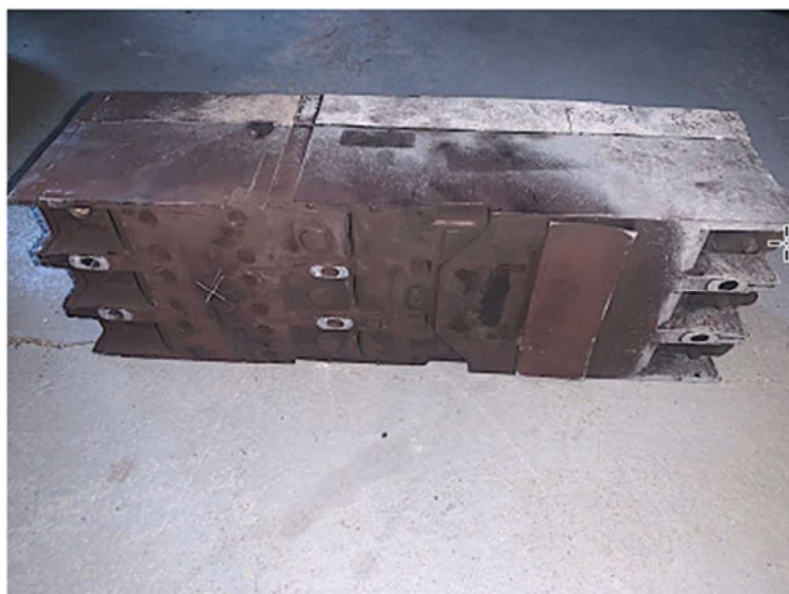
Photographie 17 Disjoncteur D511
