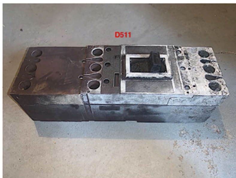
Photographie 16 Disjoncteur D511
