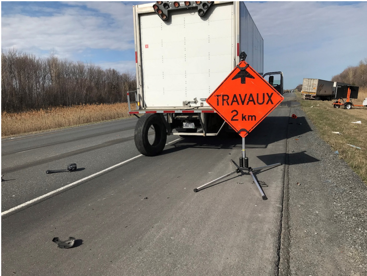
Figure 7 : panneau T-20 « Travaux 2 km » installé dans l'accotement de droite Source : CNESST
