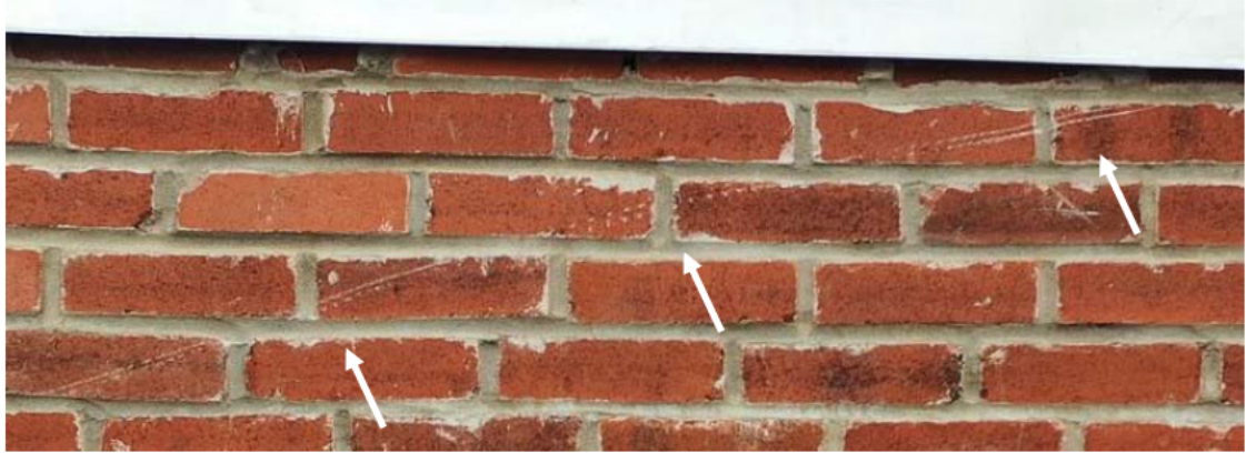
Photo 6 : Marque de frottement sur la brique (Source : CNESST)
