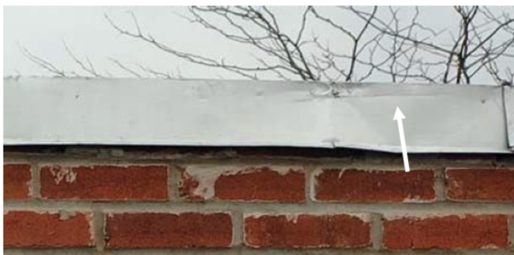
Photo 5 : Marque de frottement sur le parapet (Source : CNESST)
