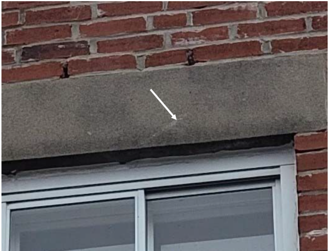
Photo 7 : Marque de frottement sur le linteau (Source : CNESST)
