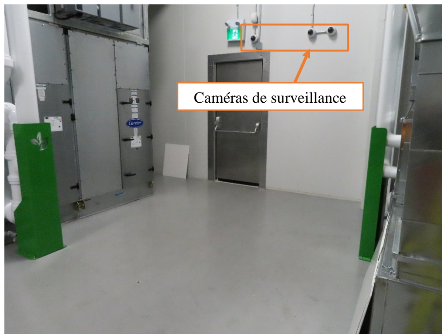
Fig. 5 : Caméras de surveillance corridor 109
