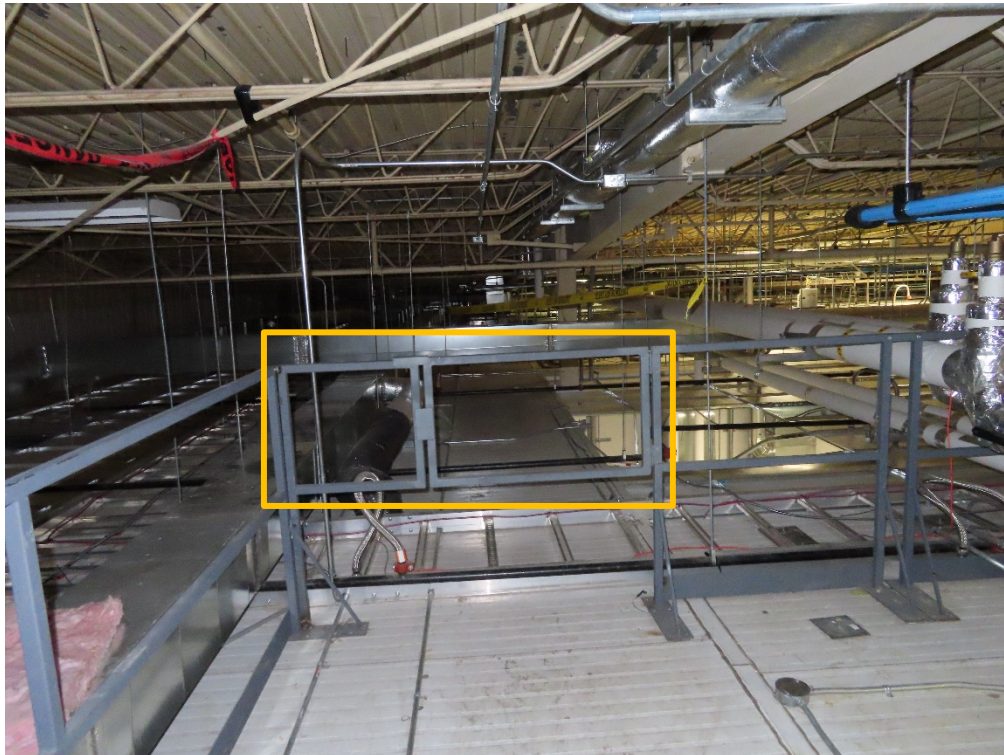
Fig. 10 : Porte du garde-corps à l'entrée de la zone non exploitée du comble Source : CNESST
