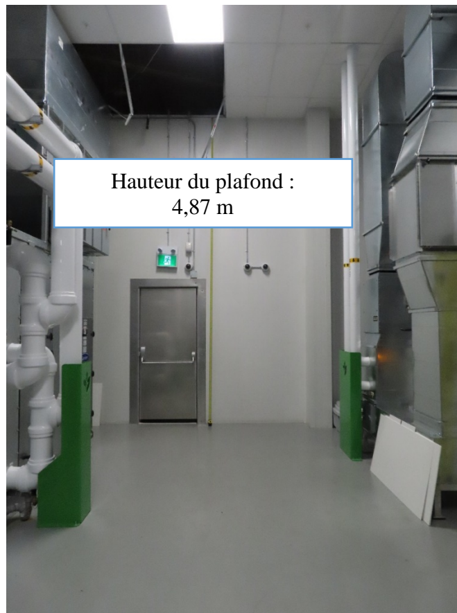
Fig. 14 : Plafond suspendu vu du corridor 109 Source : CNESST
