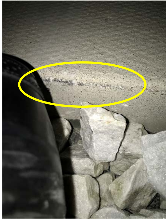
Photo 11 : Dépôt de cirage sur la dalle de béton (Source : CNESST)
