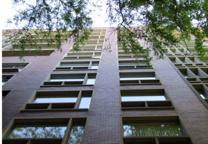
Photo 12 : Mur ouest de la tour C (36 mètres) (Source : CNESST)
