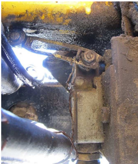
Galet de l'interrupteur retenu par l'attache en fil de fer torsadé Source : CNESST
