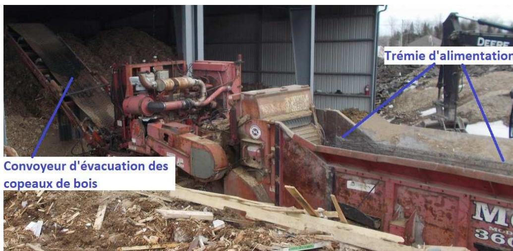
Photo 5 : Trémie d'alimentation du broyeur Morbark Source : CNESST
