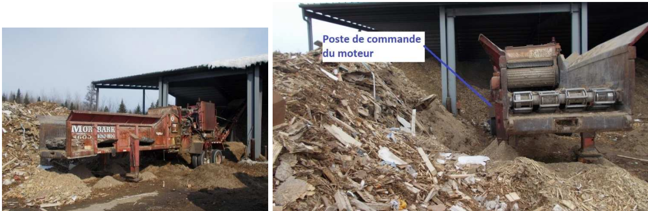
Photo 13 et 14 : Configuration du site amenant les travailleurs à circuler sous le convoyeur Source : CNESST
