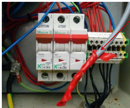
Photos 12 et 13: câble du capteur électromagnétique non raccordé au module de sécurité
