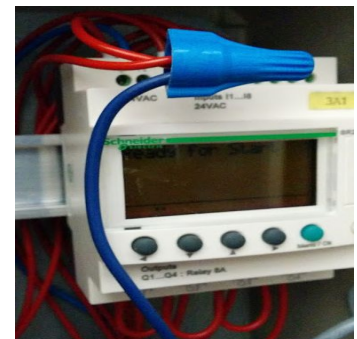
Photo 17: fil de contournement (« bypass »)
