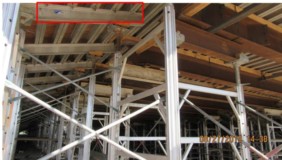
Figure 6.18 : Vue latérale de poutres JASCO et vue des agrafes 24
