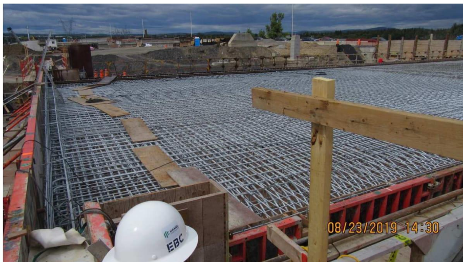
Figure 13.4 : Vue du côté ouest des coffrages 45
