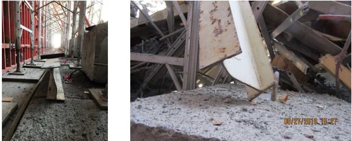
Figure 35 - Déformation de deux poutres W250x33 après l'effondrement Source : CNESST
