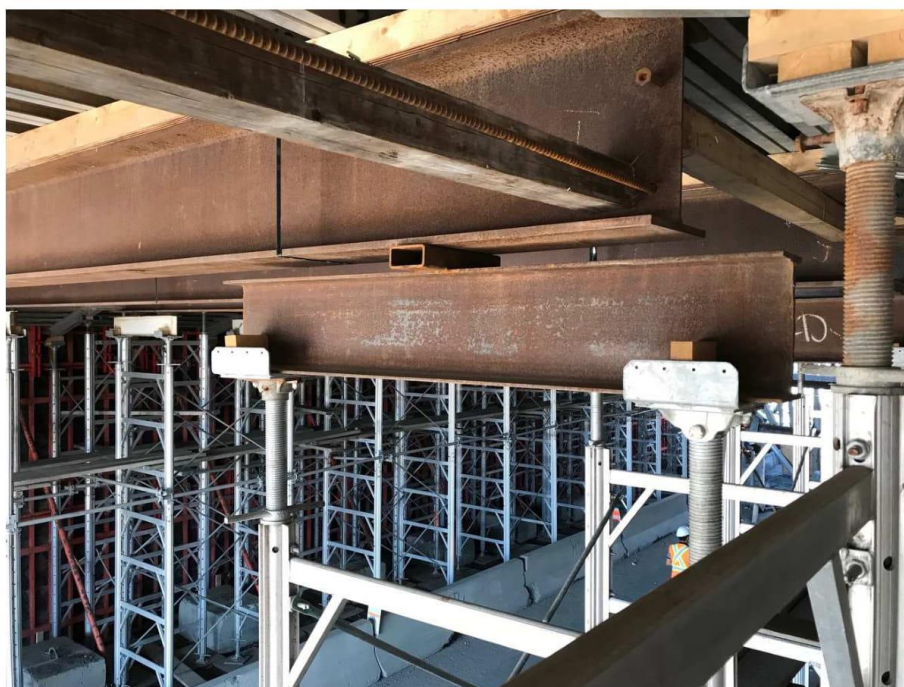
Figure 6.9 : Photo illustrant l'empilement des différents éléments du système central d'étaie 14
