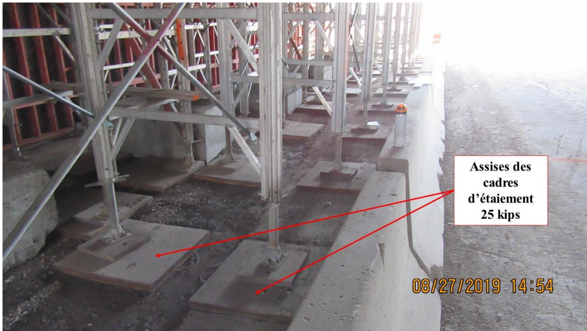
Figure 22 – Vue des assises installées sous les cadres d'étalement en aluminium 25 kips de la section centrale de l'étalement.
