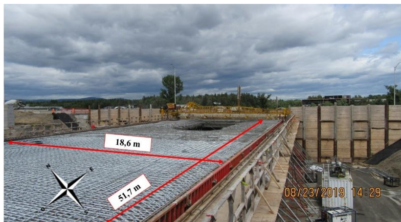
Figure 9 – Vue d'ensemble du tablier à bétonner du portique P-19410 section ouest (photo prise à la suite de l'effondrement) Source : CNESST
