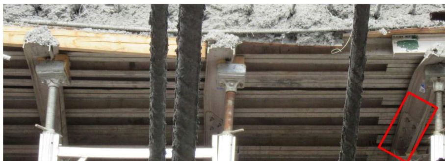
Figure 6.19 : Vue des poutres JASCO de l'étaie latérale après l'effondrement 25
