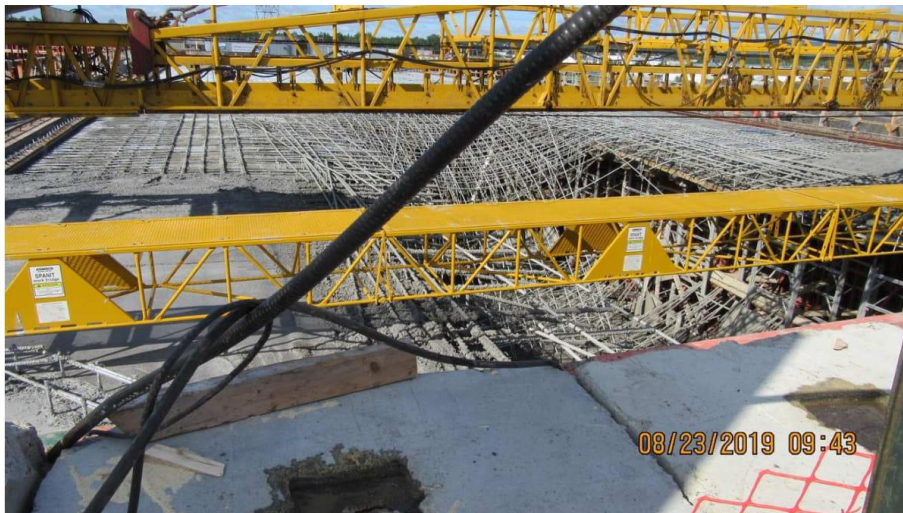
Figure 13.3 : Vue vers l'ouest du portique effondré 44
