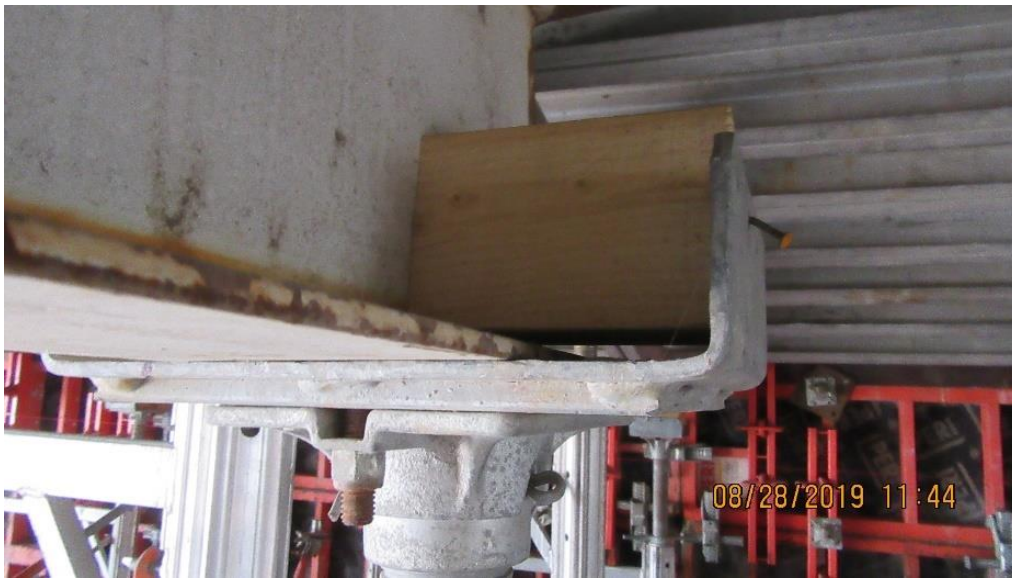
Figure 25 – Bloc de bois coincé entre l'âme d'une poutre W250x33 et le côté de la tête en « U » des cadres d'étaie. Source : CNESST
