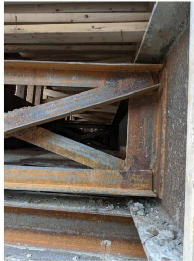
Photo 2 : Contreventement en acier
