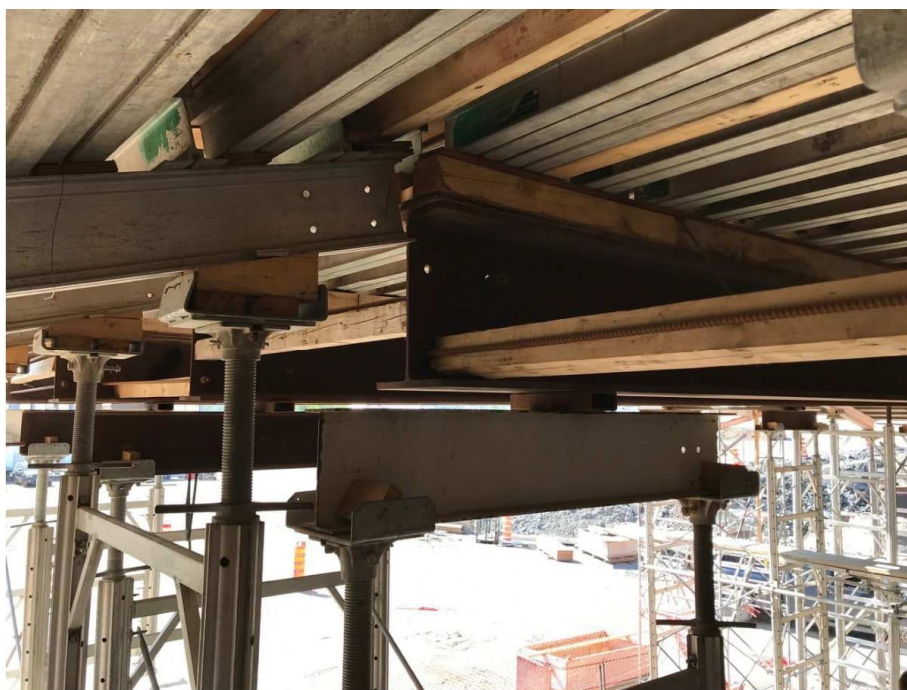
Figure 15.1 : Extrémité non contreventée d'une poutre JASCO 55
