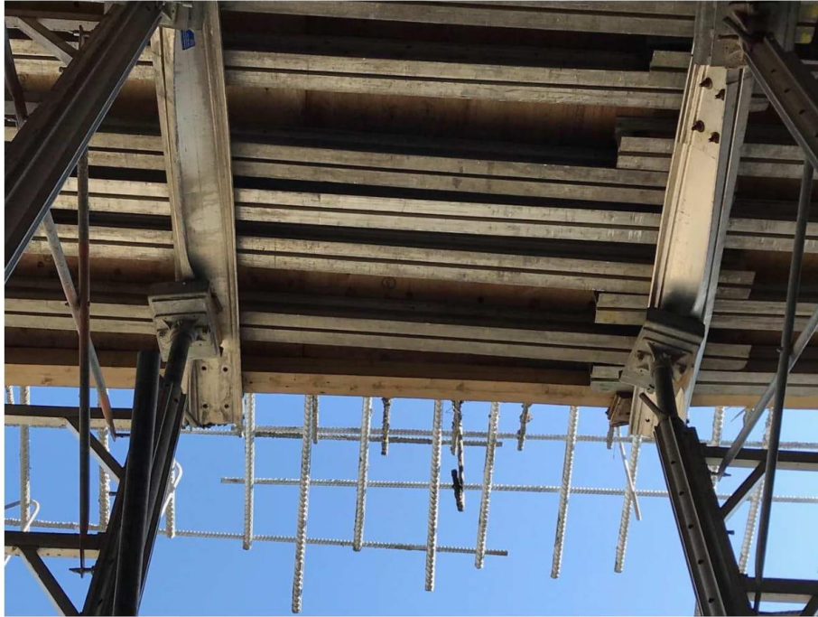
Figure 15.2 : Extrémité non contreventée d'une poutre JASCO dans la zone effondrée 56
