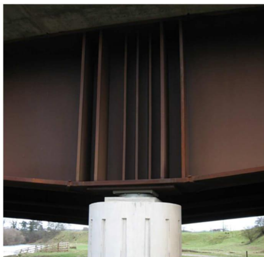
Figure 11.1 : Exemple de raidisseurs disposés à l'appui d'une poutre de pont 37
