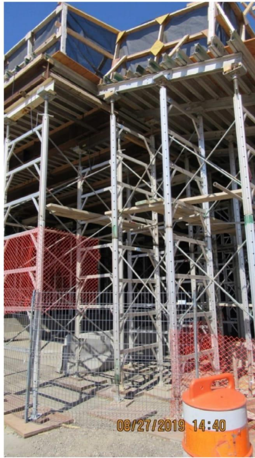
Figure 6.17 : Photo du système d'étaie en pente sous le portique 23
