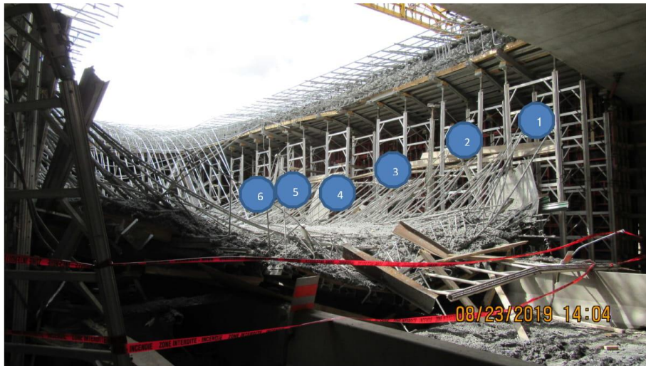
Figure 13.9 : Vue de la partie nord d'étaie dans la partie du gousset 46
