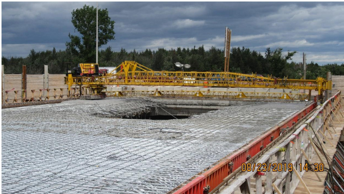
Figure 29 – Partie effondrée du tablier vue de l’ouest Source : CNESST
