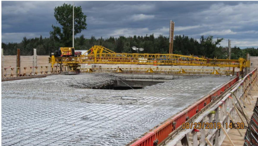
Figure 13.2 : Vue d'ensemble de la dalle supérieure après l'effondrement 43
