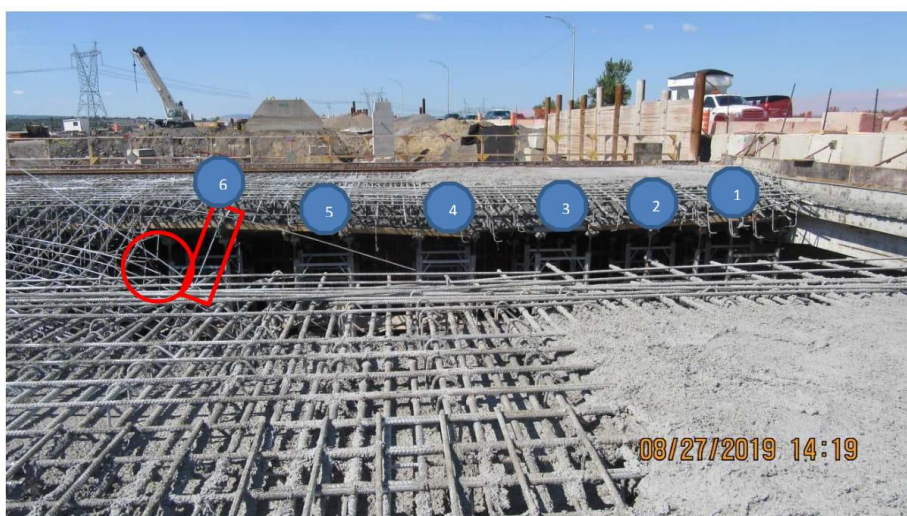
Figure 14.6 : Vue côté nord de la section effondrée 50
