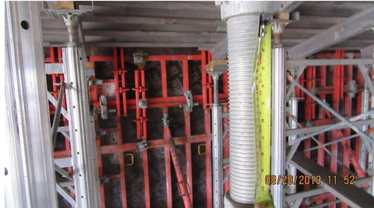
Figure 6.12 : Longueur de l'extension à la fin des jambes des cadres 17
