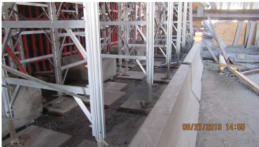
Figure 6.13 : Plaques de transfert des charges verticales vers le sol 18
