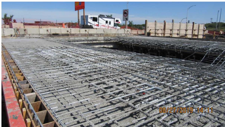
Figure 13.1 : Vue de la zone la plus épaisse du gousset au-dessus de la béquille nord 42
