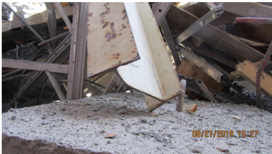
Figure 14.4 : Déformation d'une autre poutre W250x33 49
