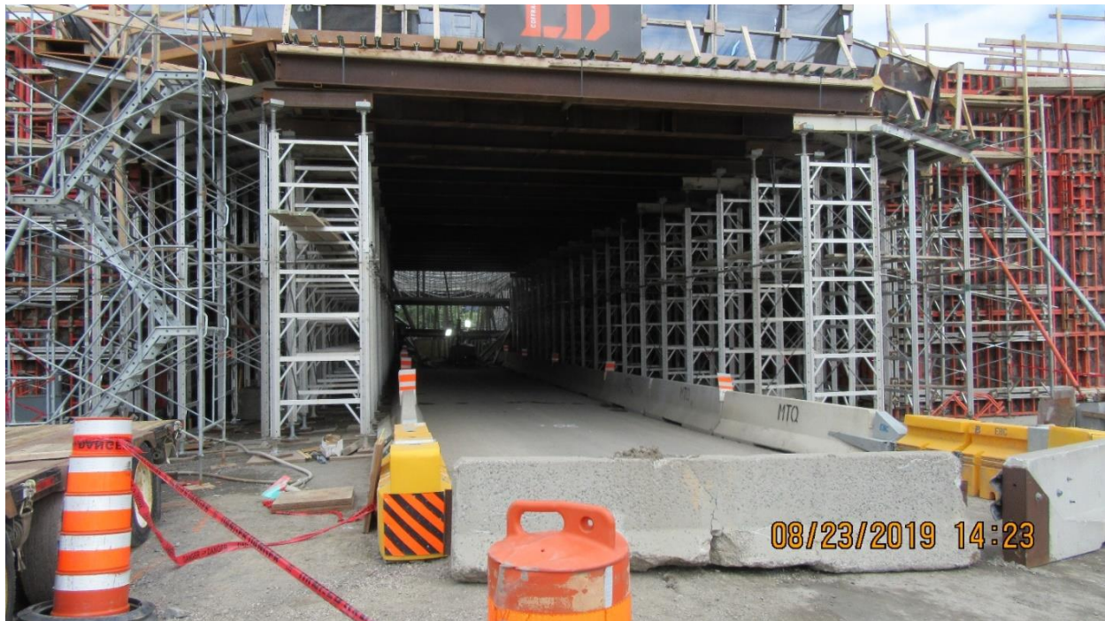
Figure 15 – Vue du côté ouest de l'étaie installée au chantier sous le tablier du portique P-19410 (phase 1B) Source : CNESST
