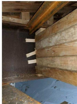
Photo 4 : Contreventement en bois
