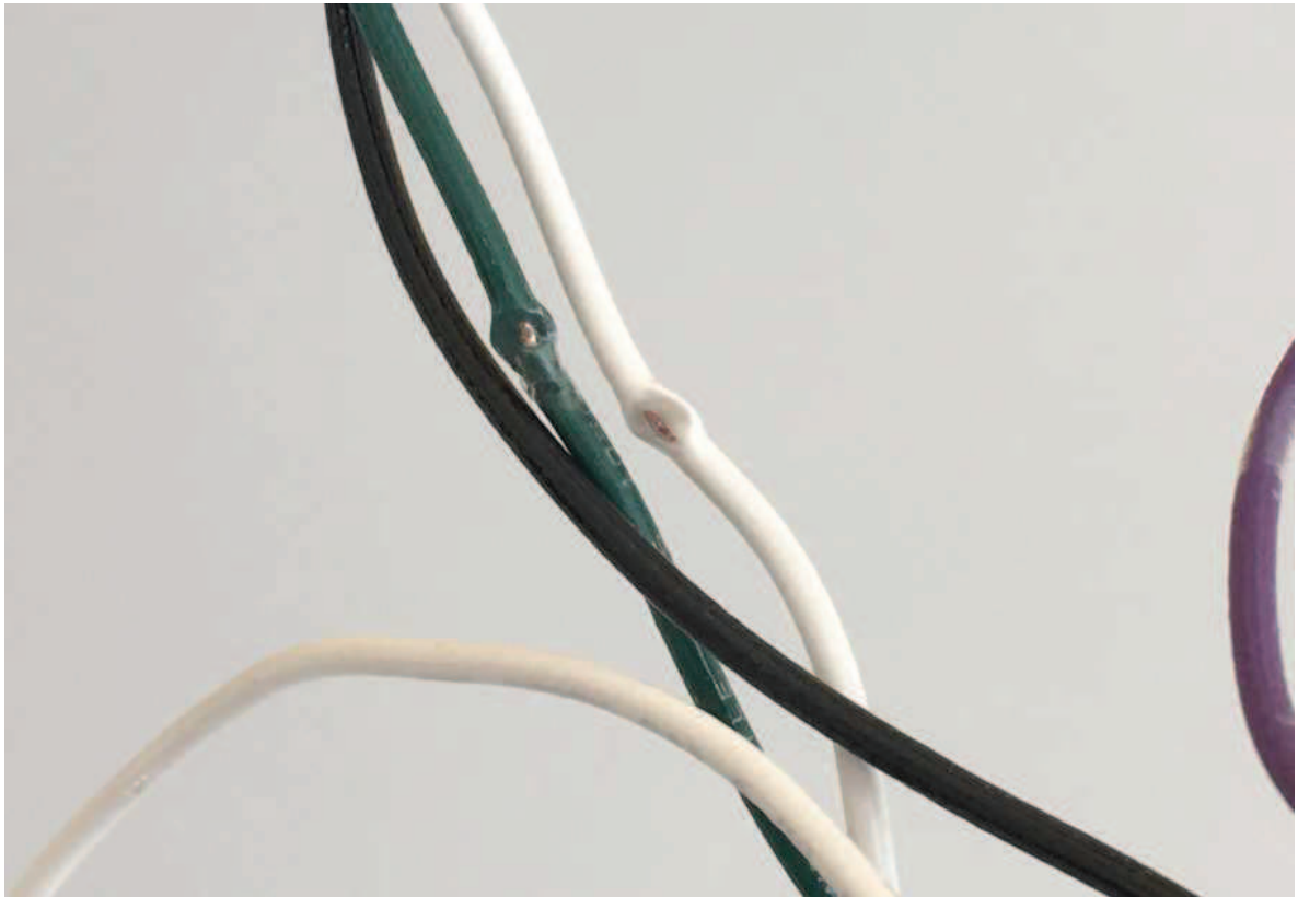
Photo #3 fil neutre et malt altérée et enveloppe fondue par passage de courant
