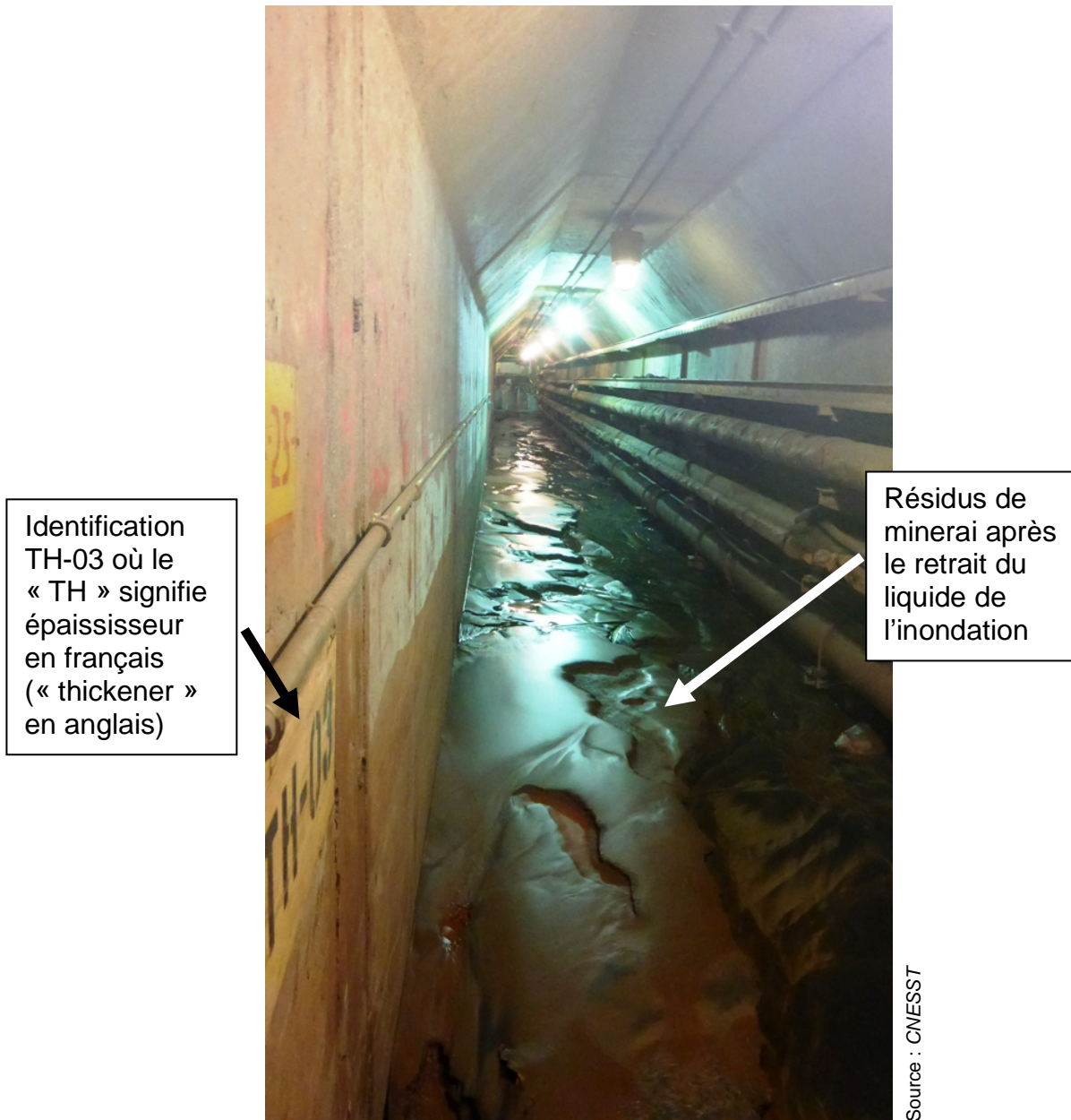
Photo 6 – Tunnel n° 3 au bout duquel se trouve la pompe PS-25
