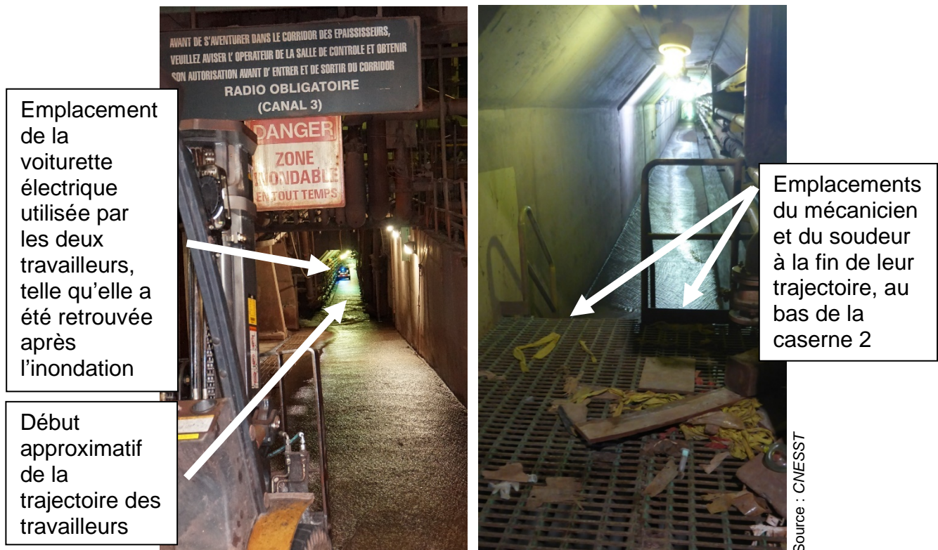
Photos 1 et 2 – Début et fin de la trajectoire des travailleurs dans le tunnel principal au moment de l'inondation
