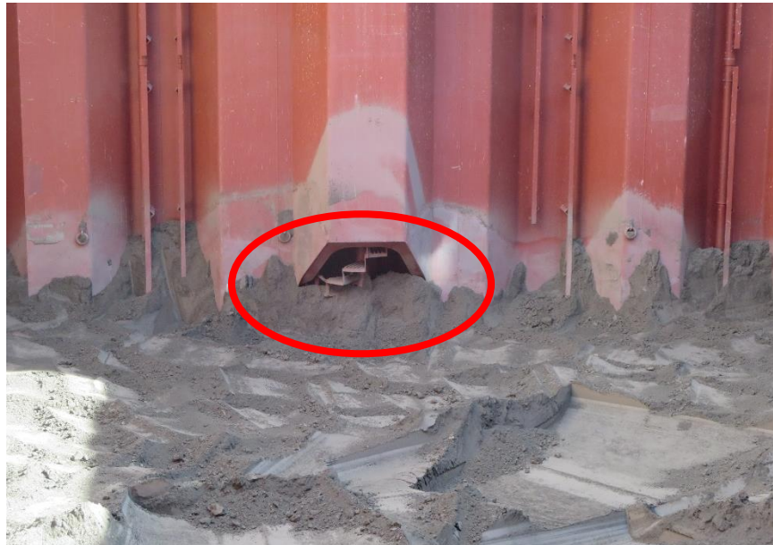
Figure 12: Base de l'escalier en colimaçon partiellement dégagée (source CNESST)
