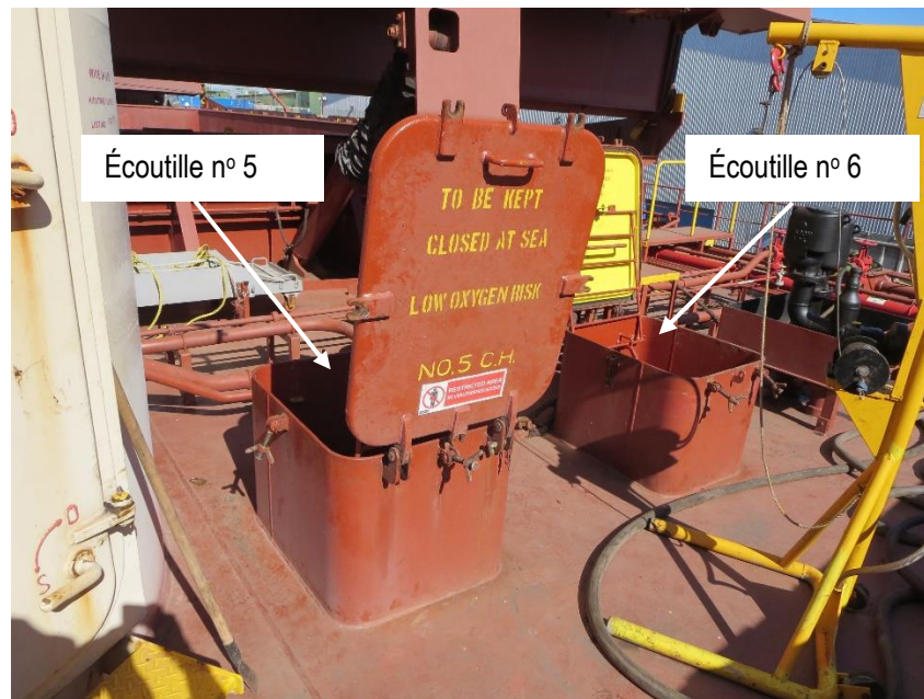
Figure 4: Écotilles d'accès aux cales n° 5 et n° 6 (source CNESST)
