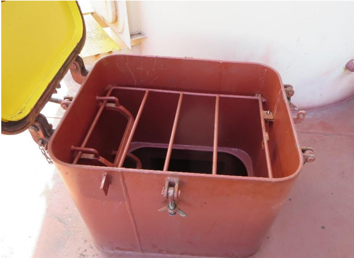
Figure 7 : Grillage pouvant être verrouillé (source CNESST)
