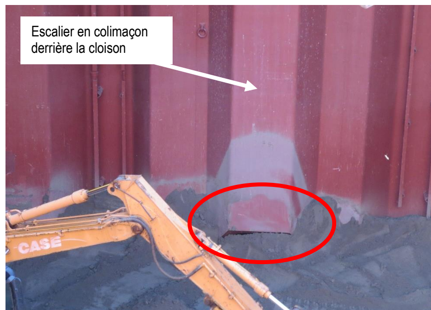
Figure 11 : Base de l'escalier en colimaçon se trouvant derrière la cloison, recouverte de concentré de zinc (source CNESST)
