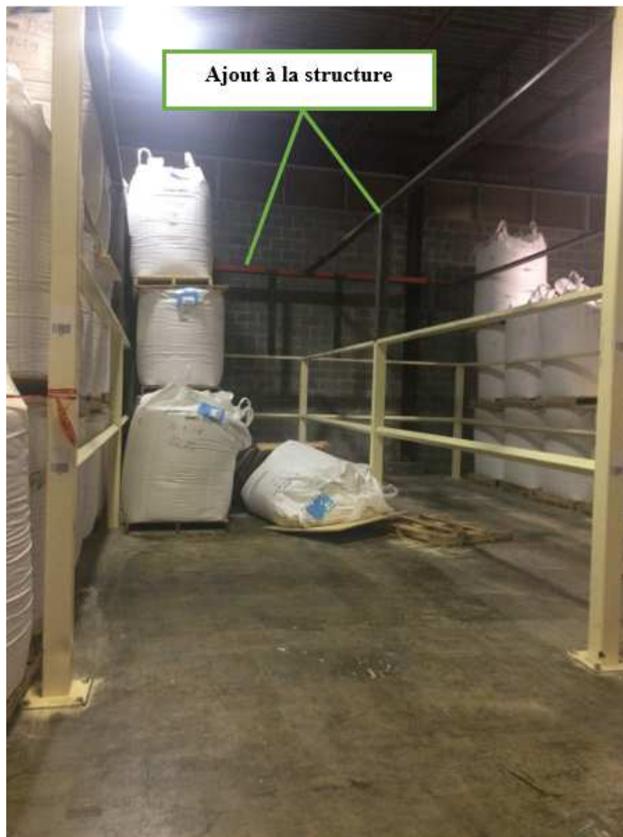
Figure 7 : Ajout à la structure (Source : CNESST)
