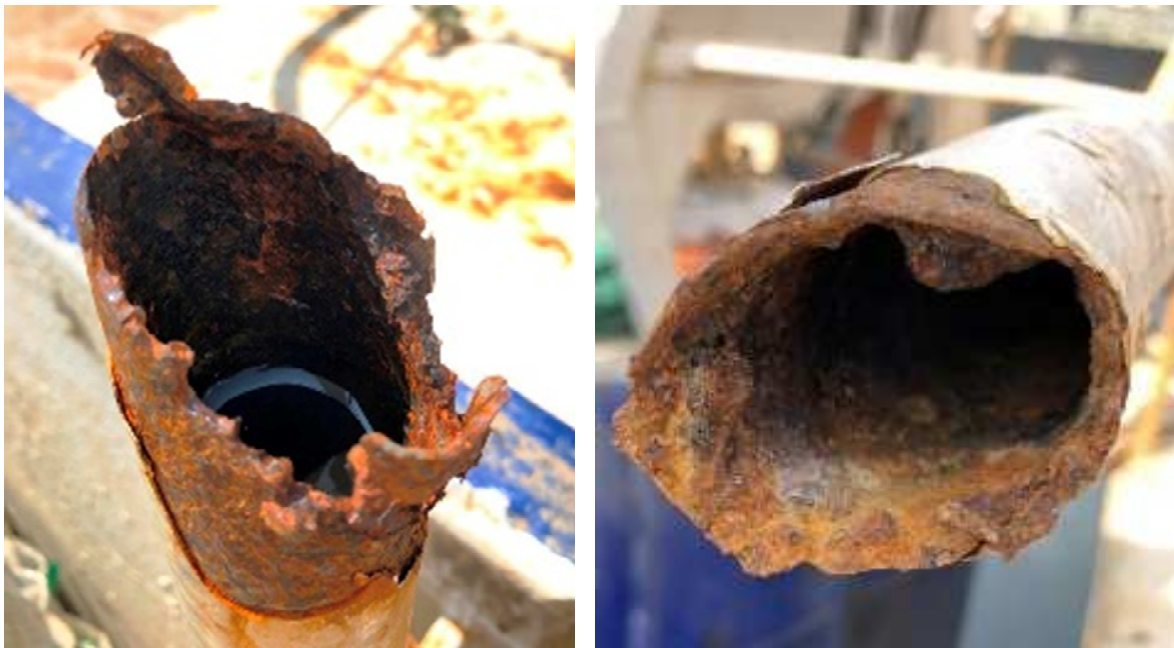
Photo 3 - Surfaces du garde-corps au point de rupture
