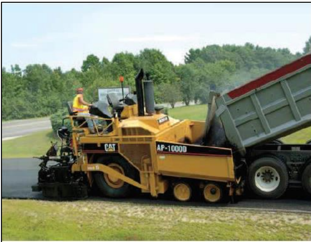
Image n°3 : Camion à benne basculante poussé par un finisseur
