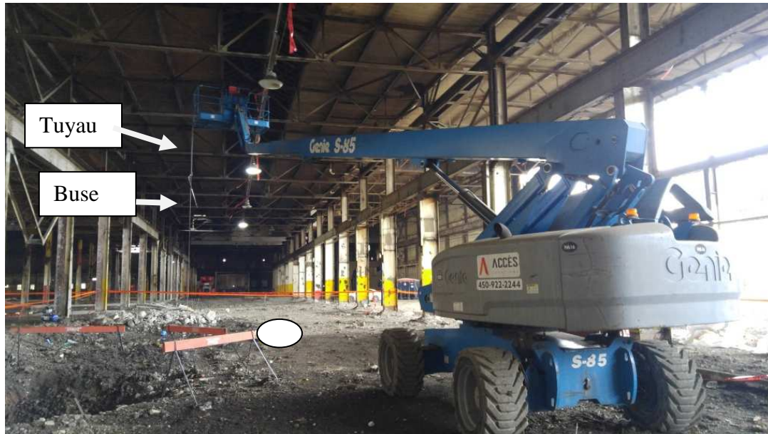
Photo 4 : Équipements utilisés (source : CNESST)
