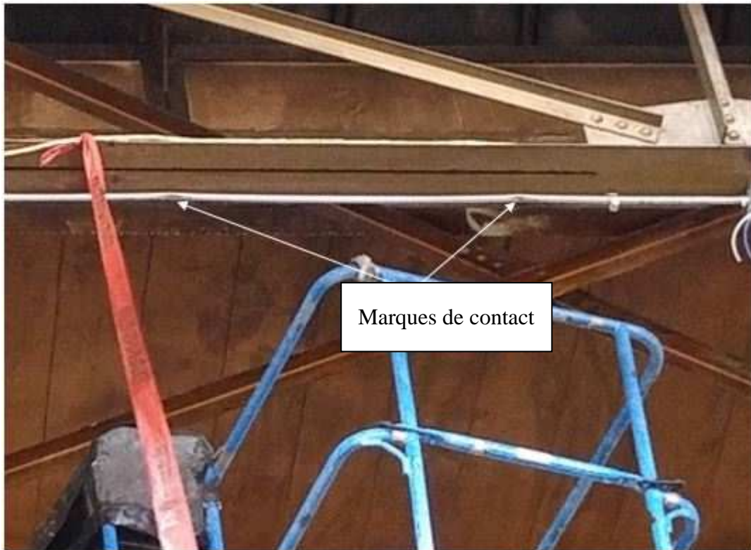
Photo 6 : Marques de contact (source : CNESST)
