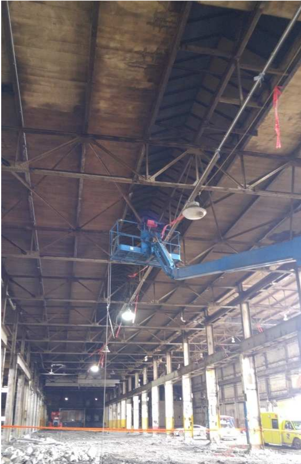
Photo 3 : Plafond à nettoyer (source : CNESST)
