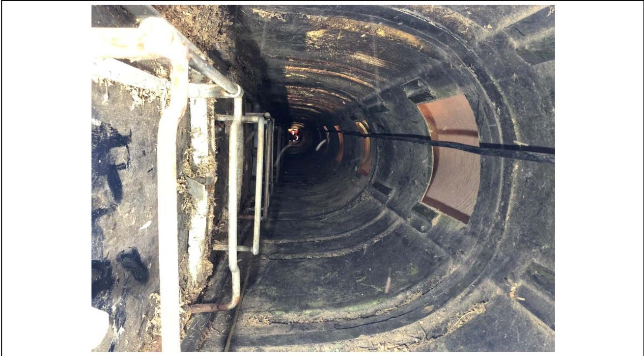
Photo 3 – Intérieur de l'échelle d'accès à crinoline
