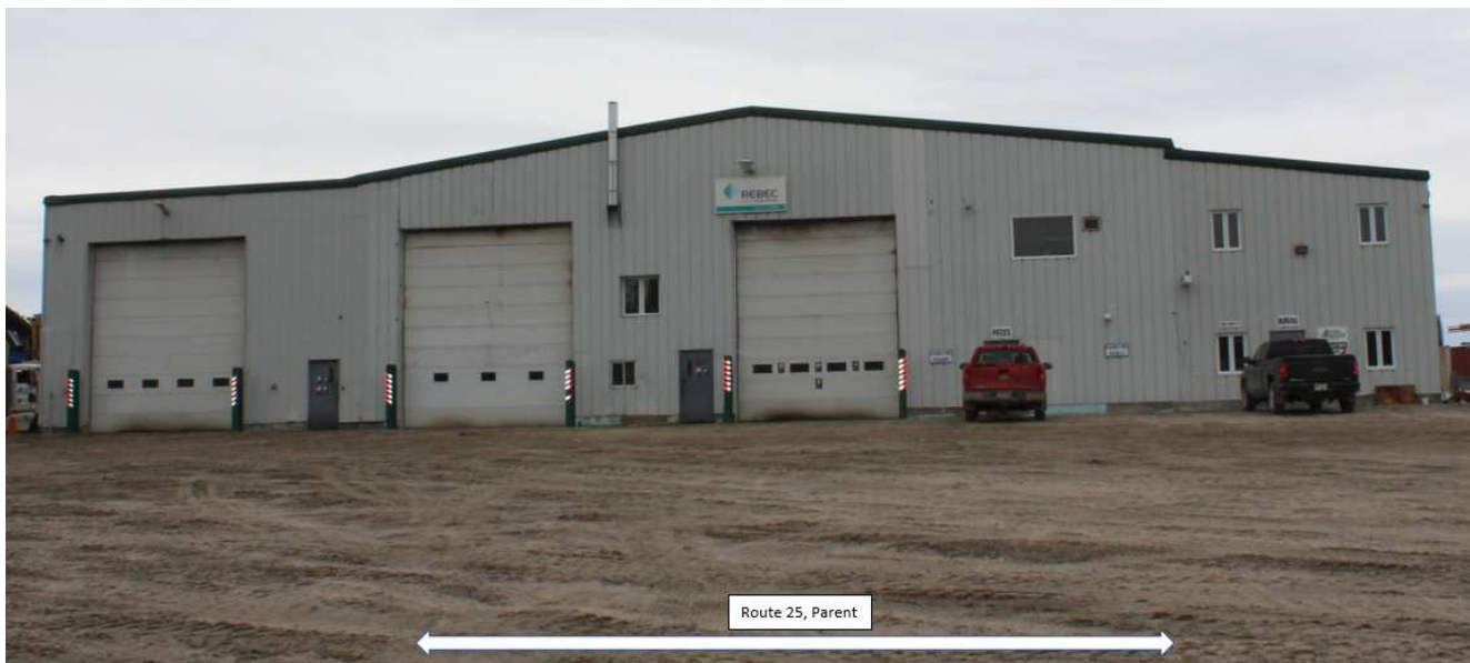
Figure 3 : Façade du garage utilisé par Entreprise RSLB inc. (source : CNESST)
