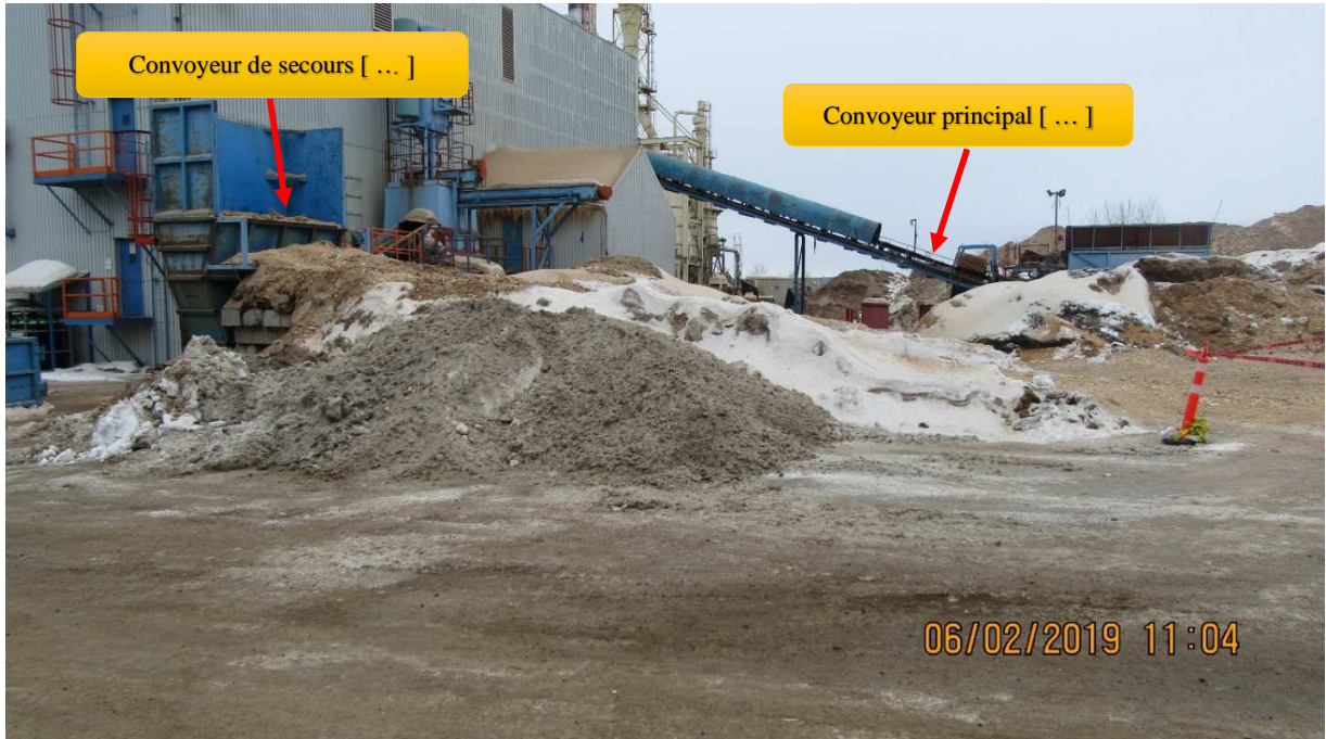
Photo 2 : Convoyeurs alimentant l'usine thermique (UT)
