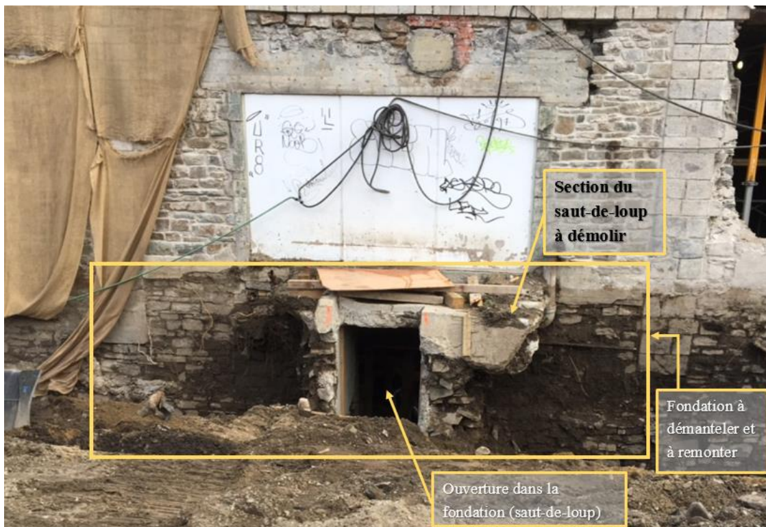
Photo 8 – Fondation (niveau 1) de la façade sud entre les axes 3 et 4 Source : Contremaître Tro-Chânes (modifiée CNESST)
