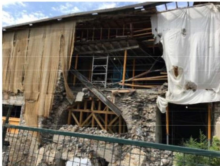
Photo n° 4 : État de la situation après l'effondrement de la section de mur
