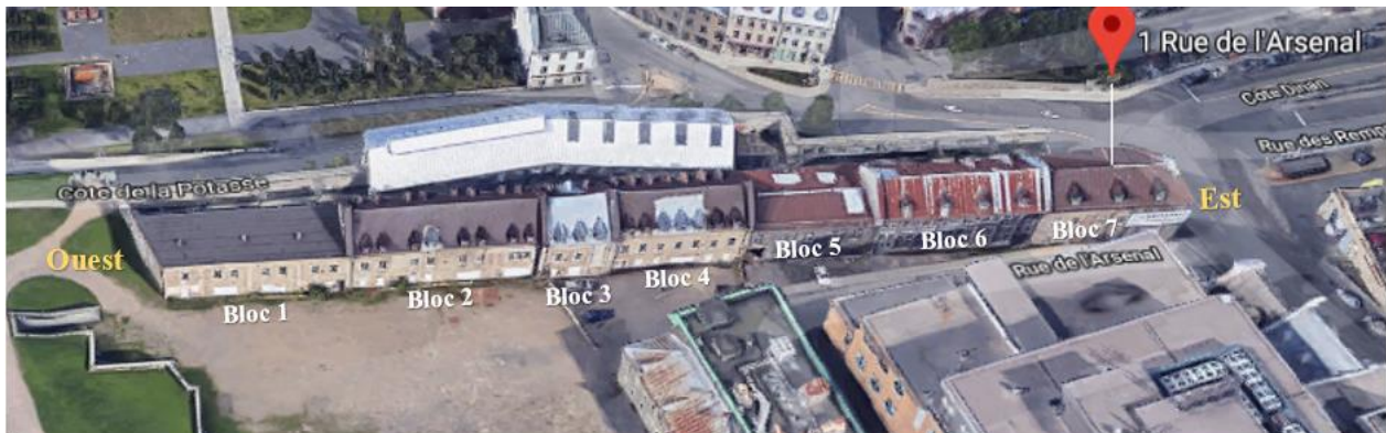
Photo 2 – Bâtiment Nouvelles-Casernes – Identification des blocs Source : Google modifiée par la CNESST
