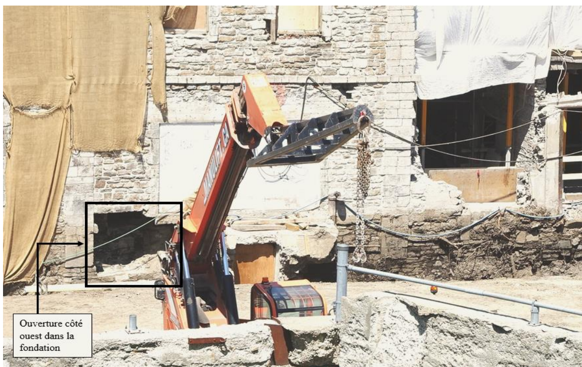
Photo 15 – Ouverture dans la fondation sans support ou étaielement
