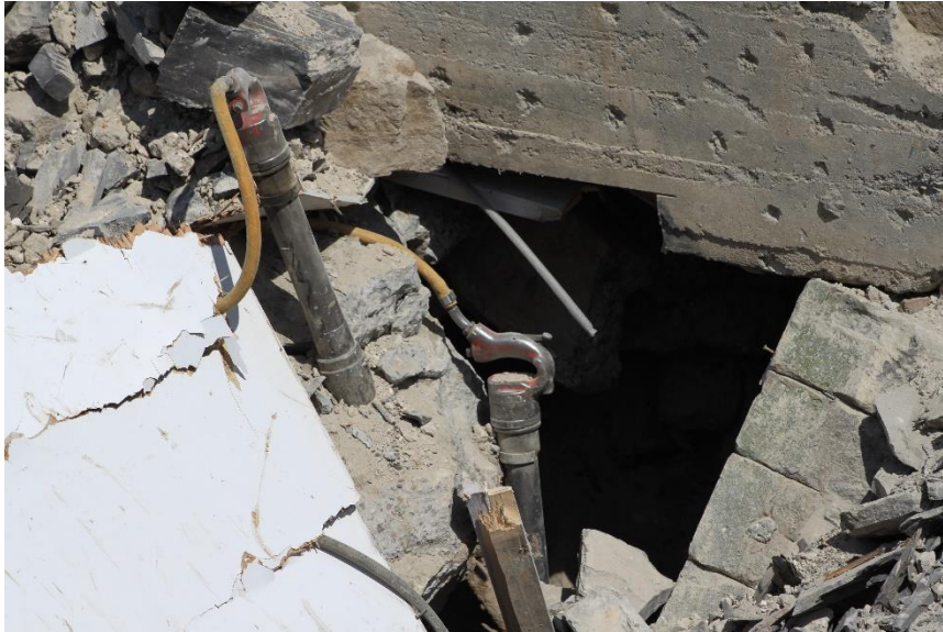
Photo 9 – Marteaux pneumatiques utilisés par les travailleurs Source : CNESST
