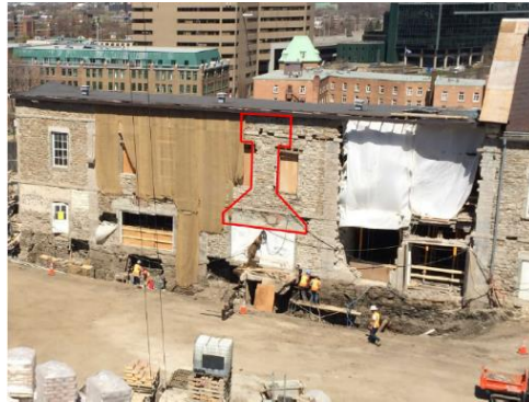
Photo 16 – Rupture en compression Source : WSP modifiée par Tetra Tech
