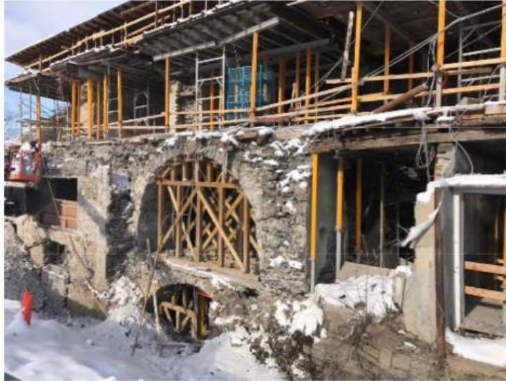
Photo n° 5 : État de la situation une fois la tranchée nettoyée
