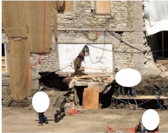
Photo n° 1 : État des travaux quelques heures avant l'effondrement
