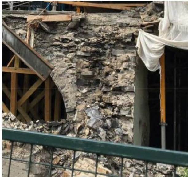
Photo n° 6 : État des pierres de liaisonnement au cœur du mur transversal de l'axe 4
