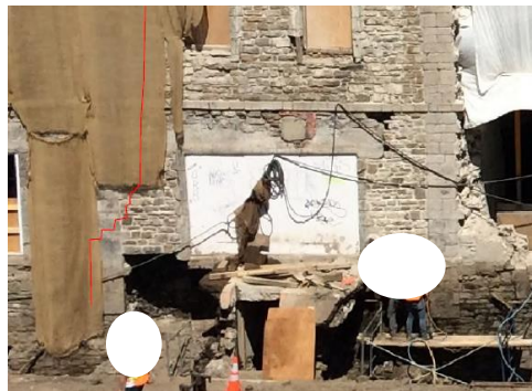
Photo 17 – Ligne de rupture en cisaillement Source : WSP modifiée par Tetra Tech
