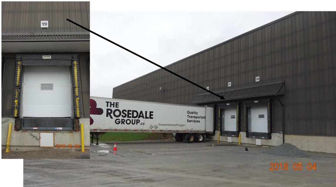
Photo 4 : Quai de transbordement n° 19 – vue de l’extérieur
