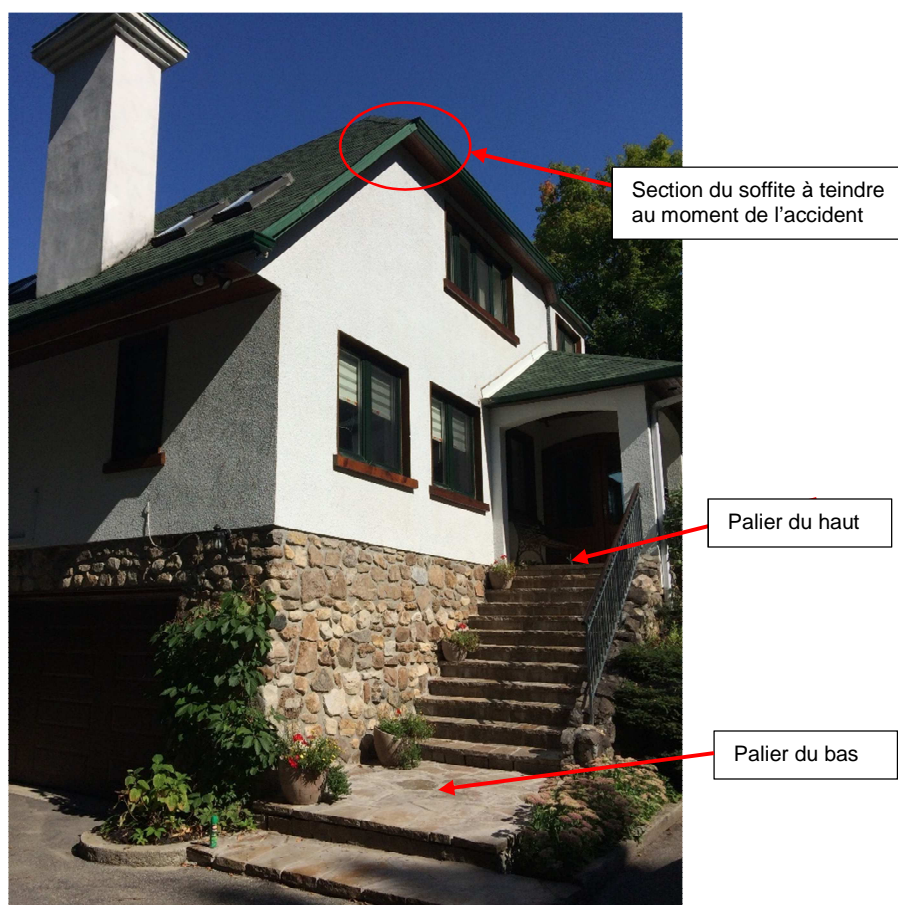
Photo 2 : Section du soffite où des travaux sont en cours lors de l'accident (Source : CNESST)
