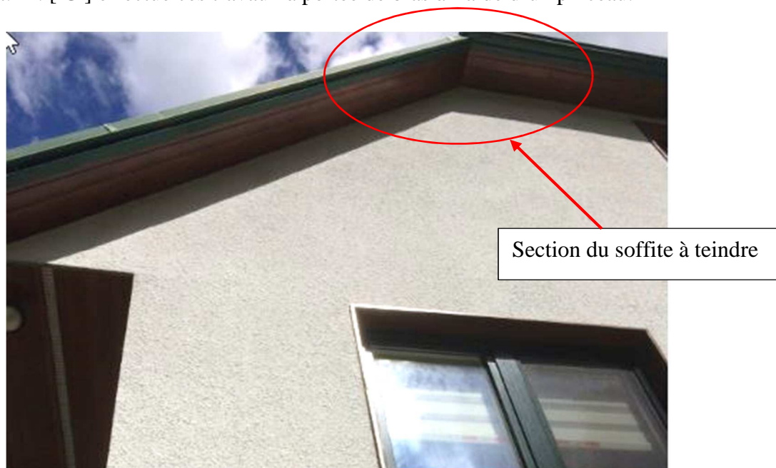
Photo 3 : Section de soffite où l'application d'une couche de teinture est à faire (Source : CNESST)
