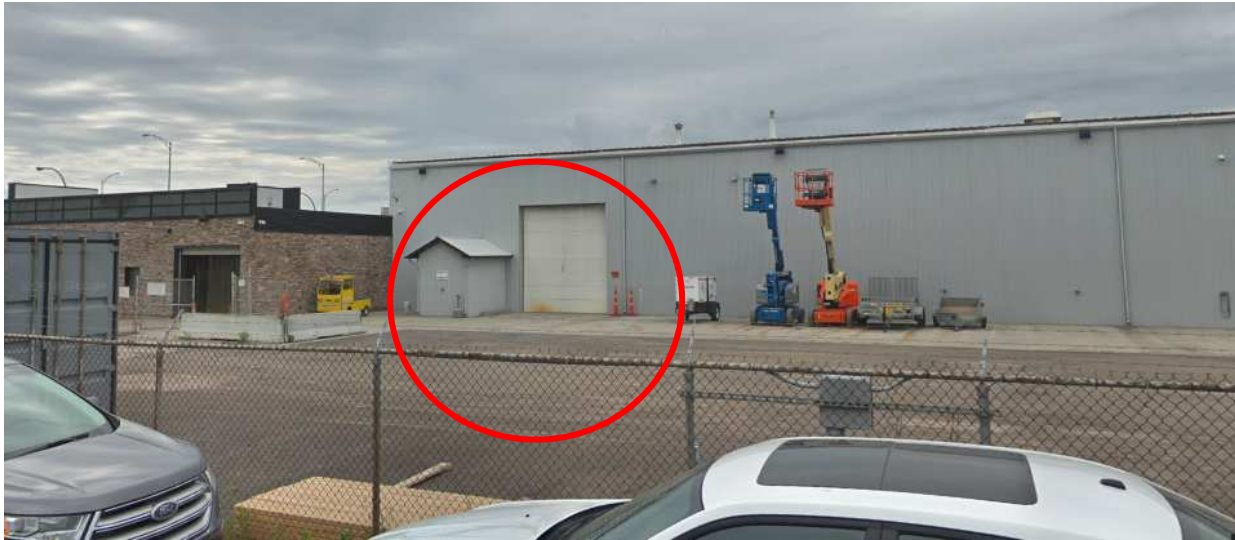
Photo 3 : Emplacement où est survenu l'accident, devant la porte de garage no 1 Source : https://www.google.com/maps , modifiée par la CNESST
