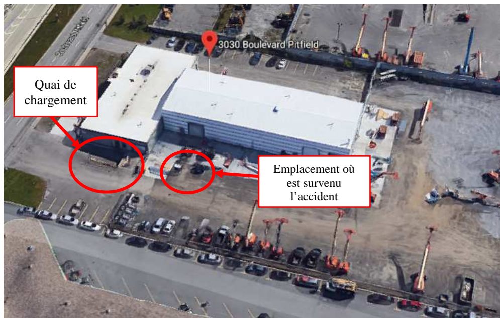
Photo 2 : Emplacement où est survenu l'accident, devant la porte de garage no 1 et quai de chargement Vue en hauteur de l'établissement
