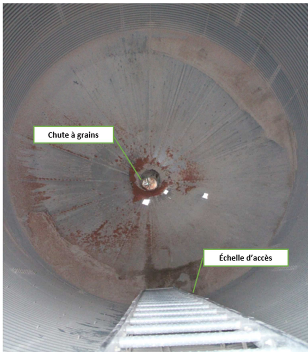
Photo n°2 : intérieur du silo H4 (Source : CNESST)
