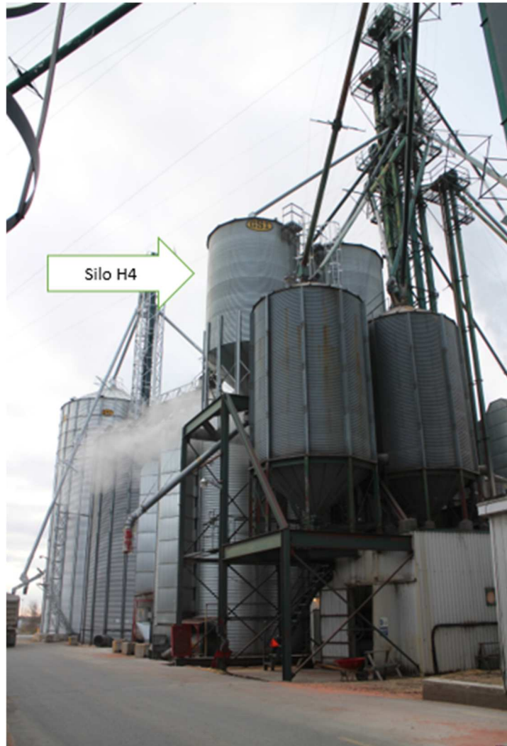
Photo n°1 : Silo H4 (Source : CNESST)
