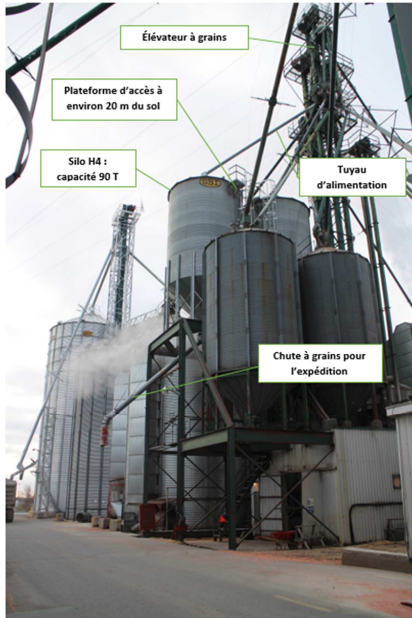
Photo n°4 – Silo H4 (Source : CNESST)
