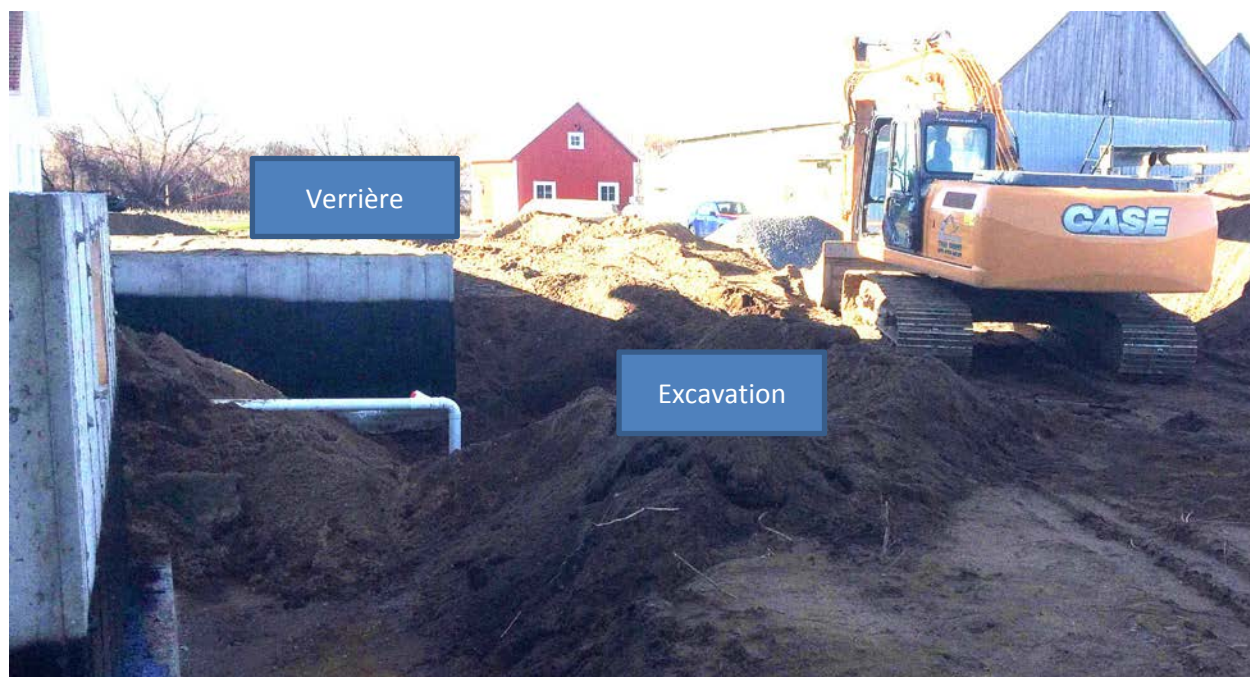
Photo n°4 : Travaux de réparation du tuyau d'égout (source : CNESST)
