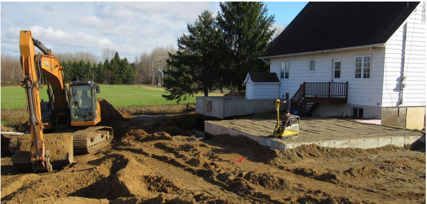
Photo n°1 : photo du lieu de l'accident prise le 8 novembre 2018 (source : CNESST)
