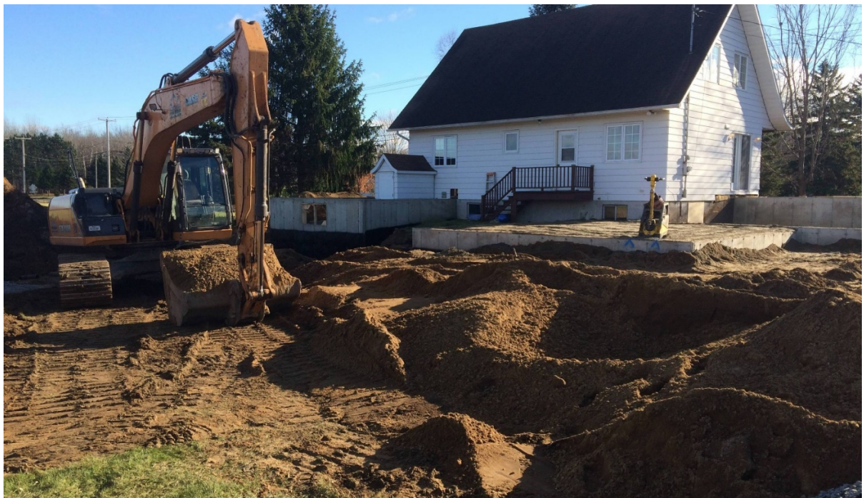
Photo n°2 : Vue arrière du chantier (source : CNESST)
