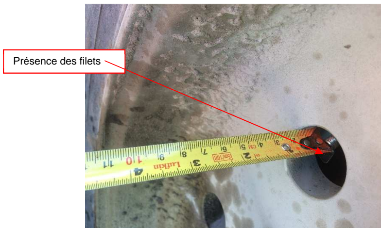
Photo 25 – Valve en bon état
