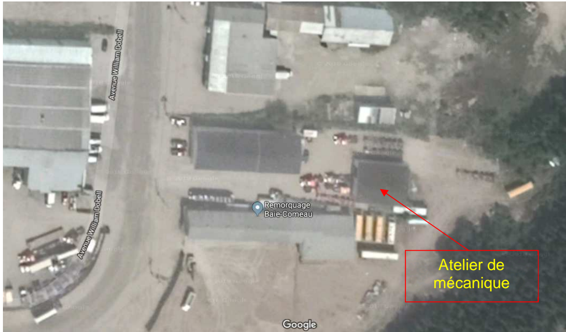
Photo 3 - Lieu de l'accident
