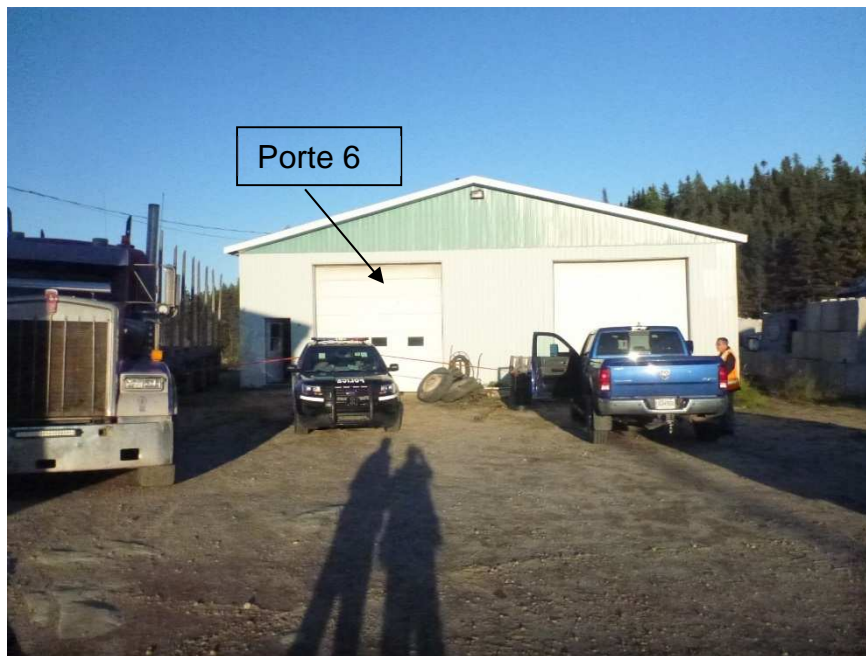
Photo 4 - Lieu de l'accident (atelier de mécanique, 52 avenue William-Dobell)
